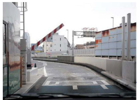
圖4-6-2 ETC 收費車道實體佈設
