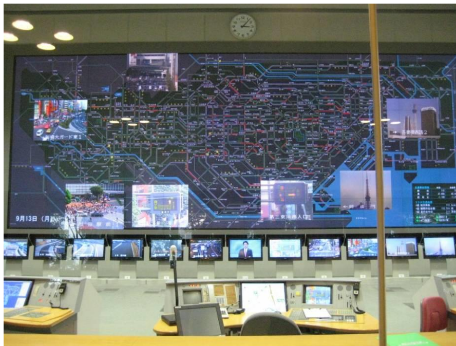
圖4-2-3警視廳交管中心中央顯示板
