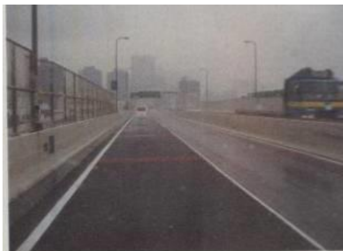
圖4-4-18快速排水鋪面
