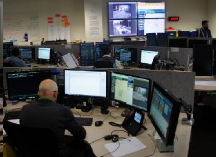
圖3-22 行控中心CCTV監看
