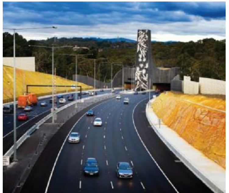
圖3-19 東聯隧道洞口
