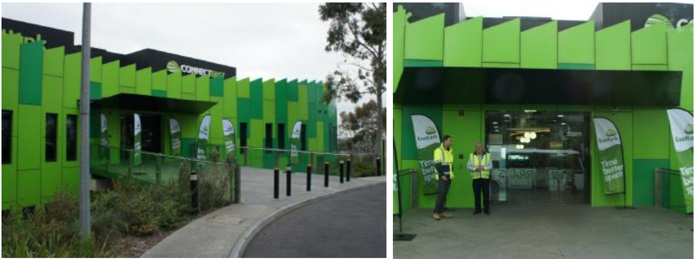
圖3-10 東聯高速公路公司控制中心外觀
