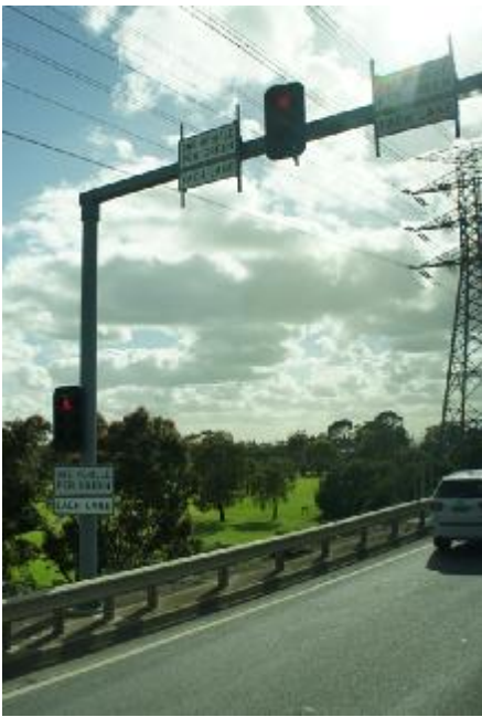
圖3-7 匝道儀控(每次僅放行1部車) 圖3-8 交控系統中央電腦速限可變標誌
