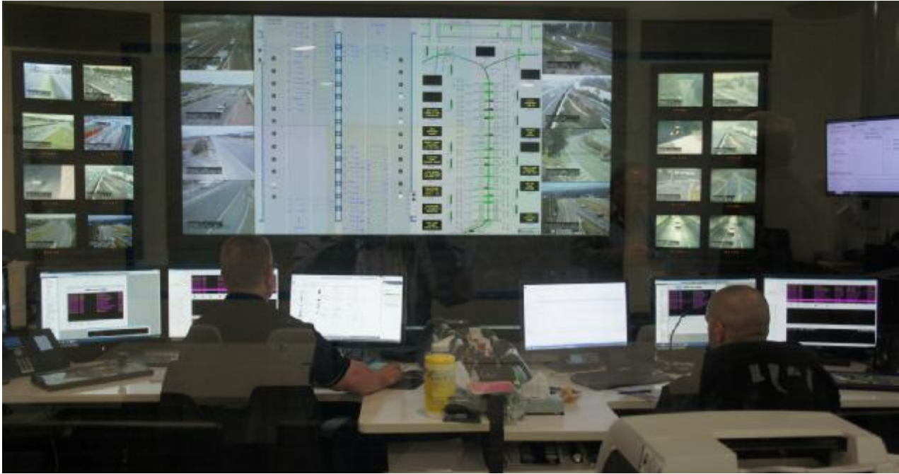
圖3-12 東聯高速公路公司交通控制中心控制室
