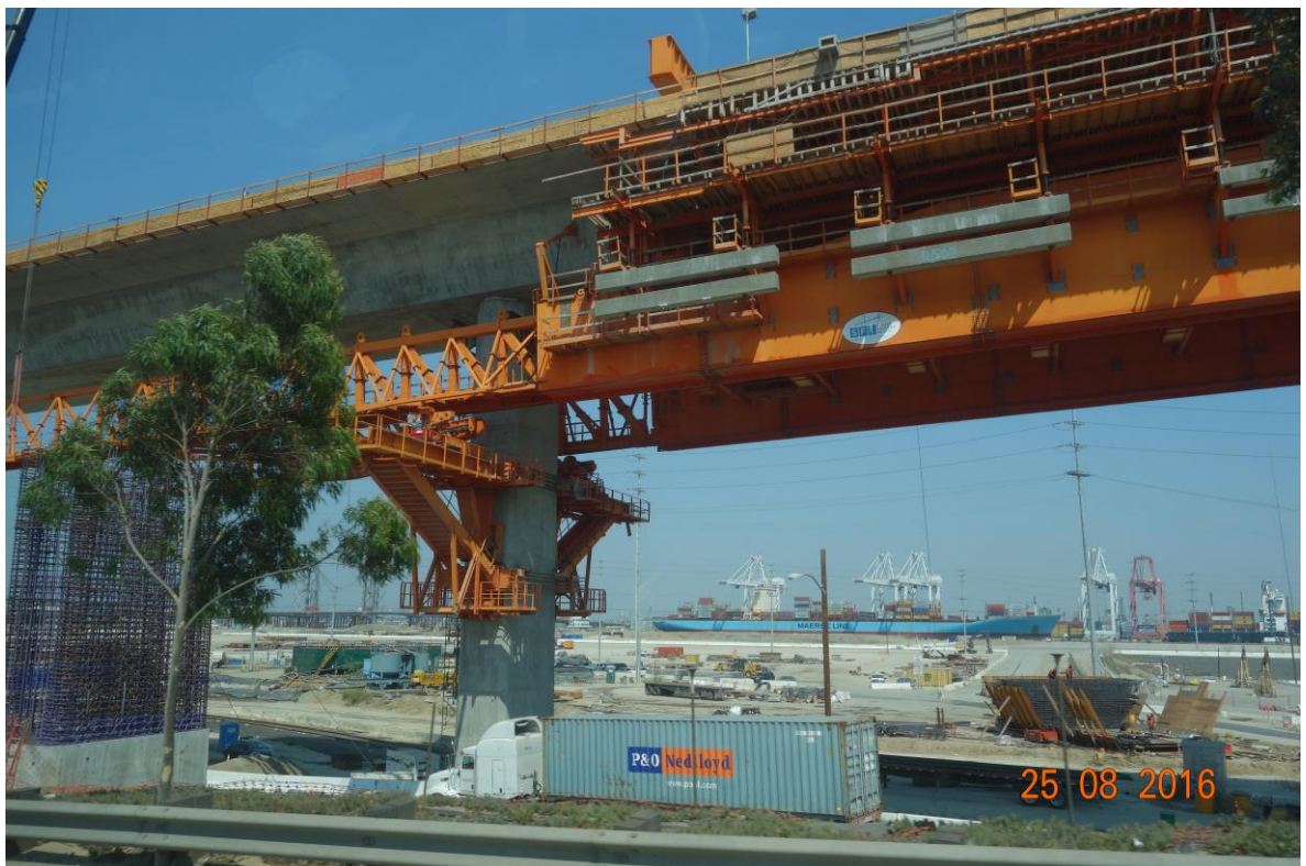
圖六十 支撐先進工法橋梁施工
