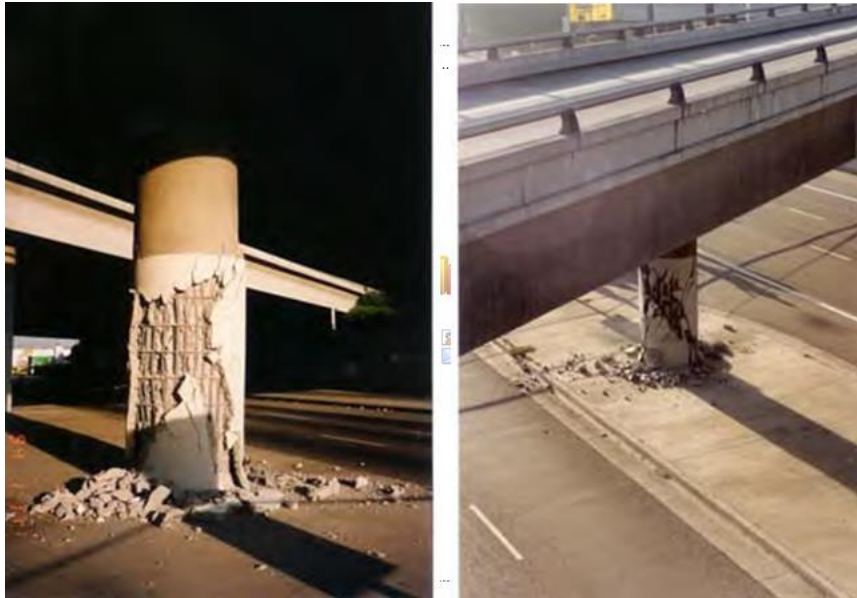
圖二十一 橋柱剪力破壞
