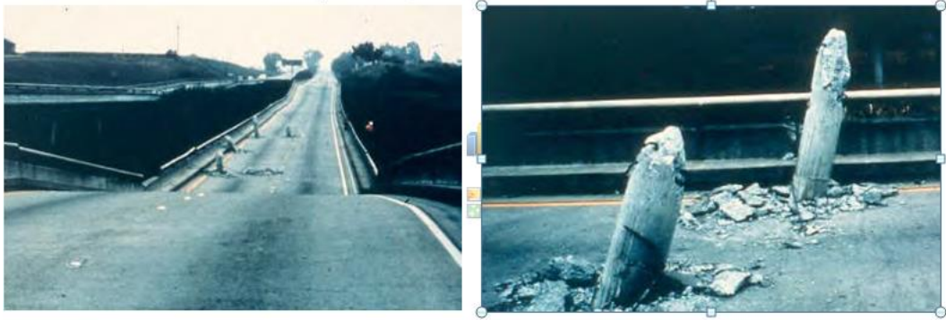
圖二十 橋梁上部結構穿孔損壞落橋
