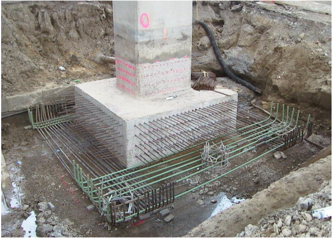
圖五十九 橋梁耐震補強樁帽擴大增加樁並使用環氧樹脂防蝕鋼筋
