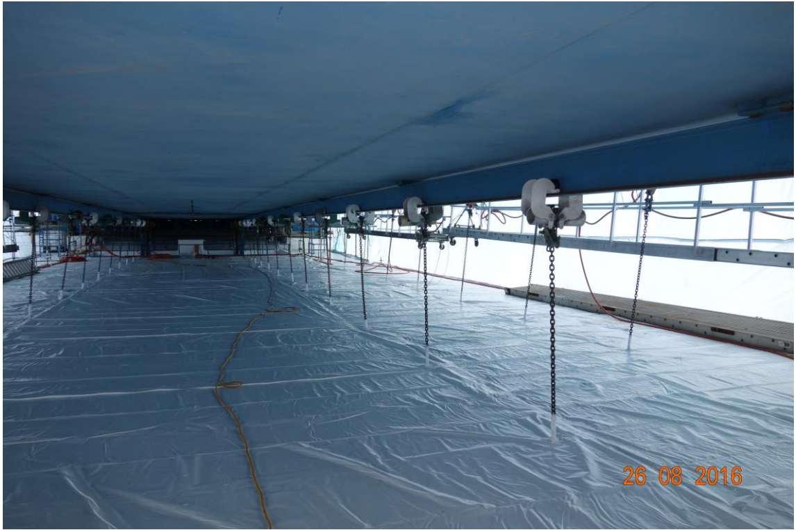
圖五十 Los Angeles Harbor Vicenti Thomas 橋梁維修用臨時吊裝平台
