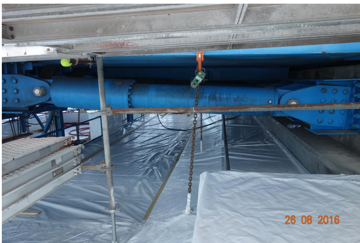
圖四十九 Los Angeles Harbor Vicenti Thomas Bridge耐震補強阻尼器
