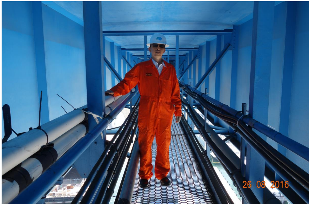
圖四十七 Los Angeles Harbor Vicenti Thomas Bridge橋梁檢測專用步道
