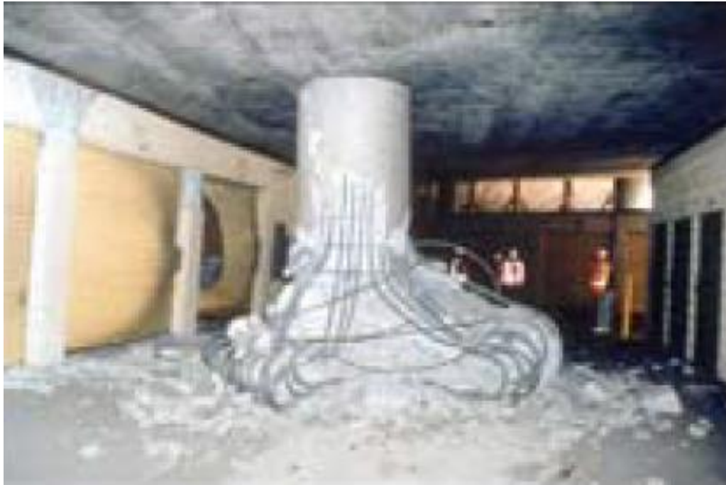
圖十五 橋柱主筋挫屈破壞
