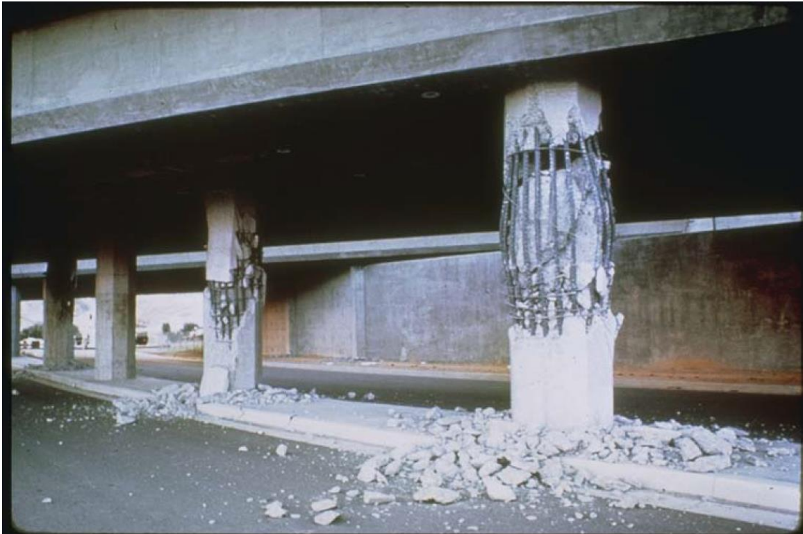
圖十二 橋柱剪力破壞
