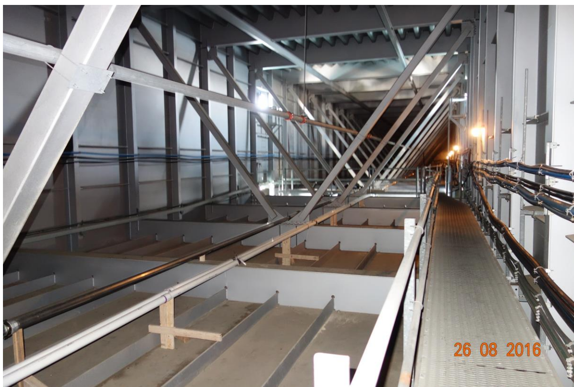
圖四十八 Los Angeles Harbor Vicent Thomas Bridge箱梁內檢測步道
