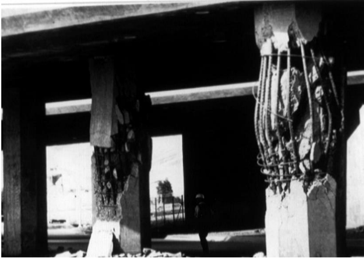
圖十三 橋柱剪力破壞
