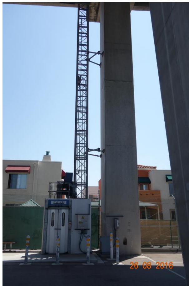
圖四十三 San Diego Coronado 橋梁檢測專用電梯
