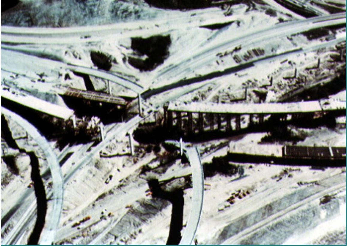
圖九 橋梁落橋
