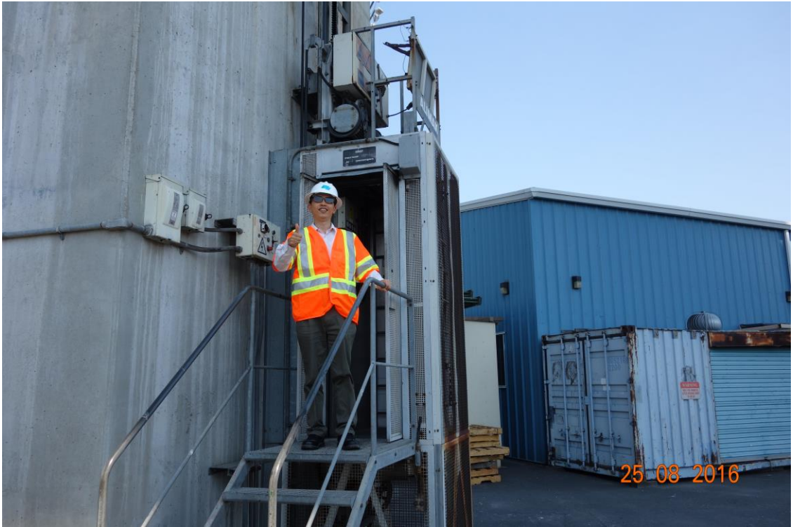
圖四十二 San Diego Coronado 橋梁檢測專用電梯
