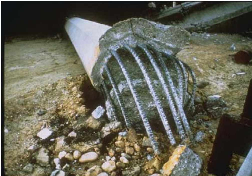
圖十四 橋柱主筋錨定長度不足破壞
