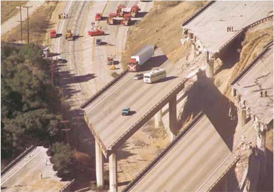
圖十八 上部結構外懸鉸接損壞落橋
