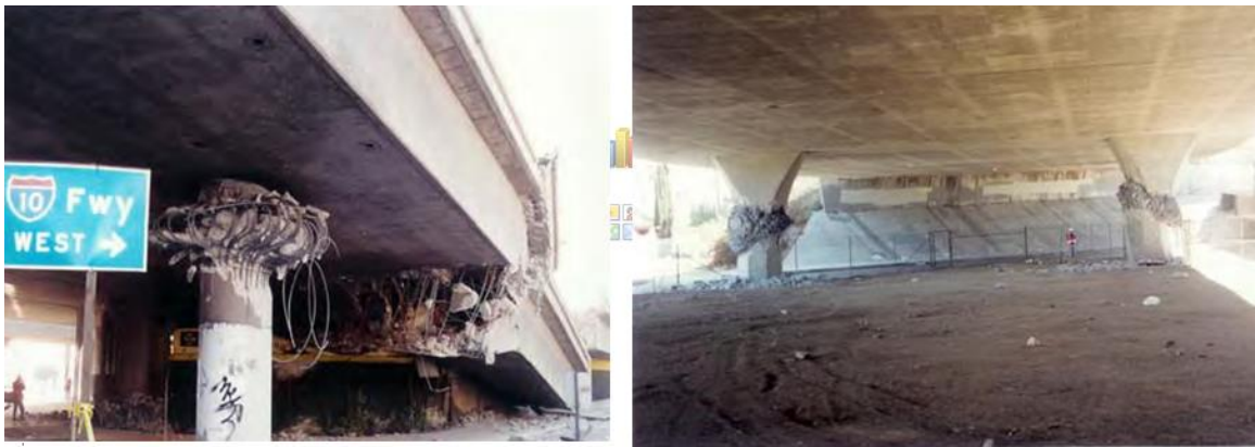
圖二十二 橋柱剪力破壞
