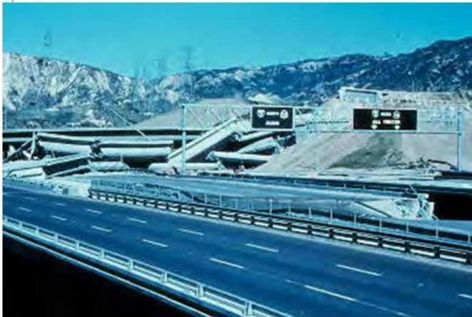
圖十 橋梁完全崩塌
