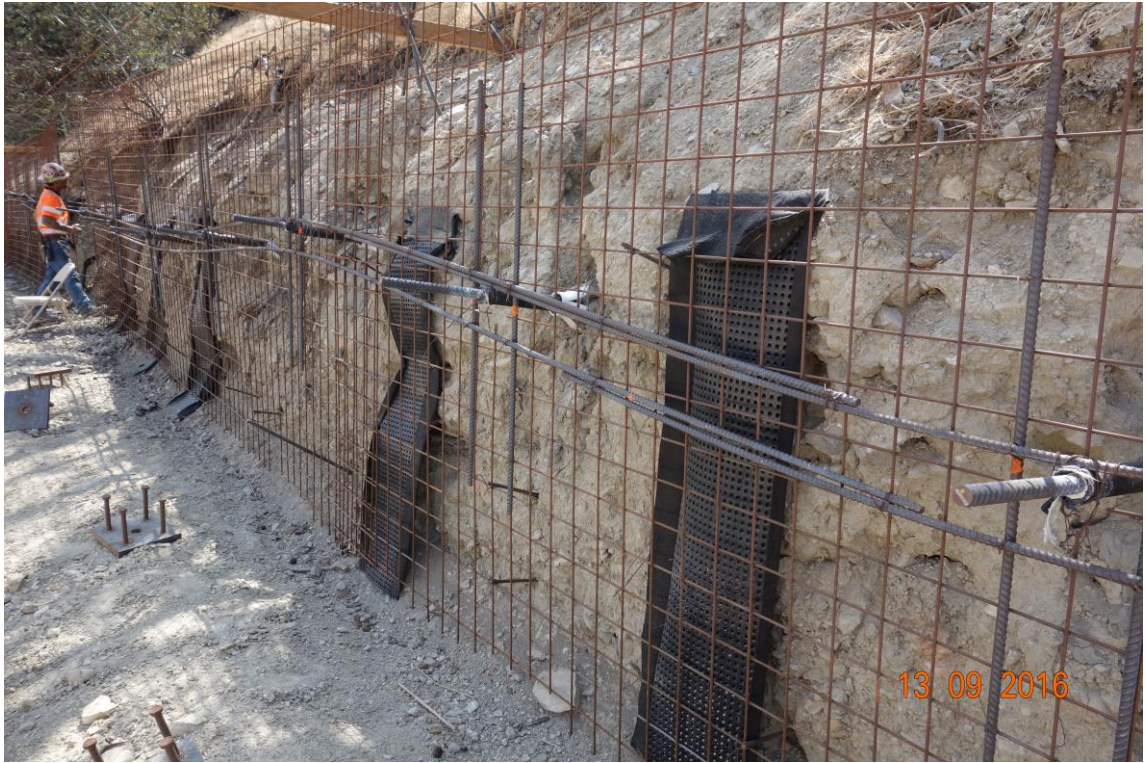
圖五十五 10號高速公路拓寬工程邊坡擋土牆裝排水用地工織物
