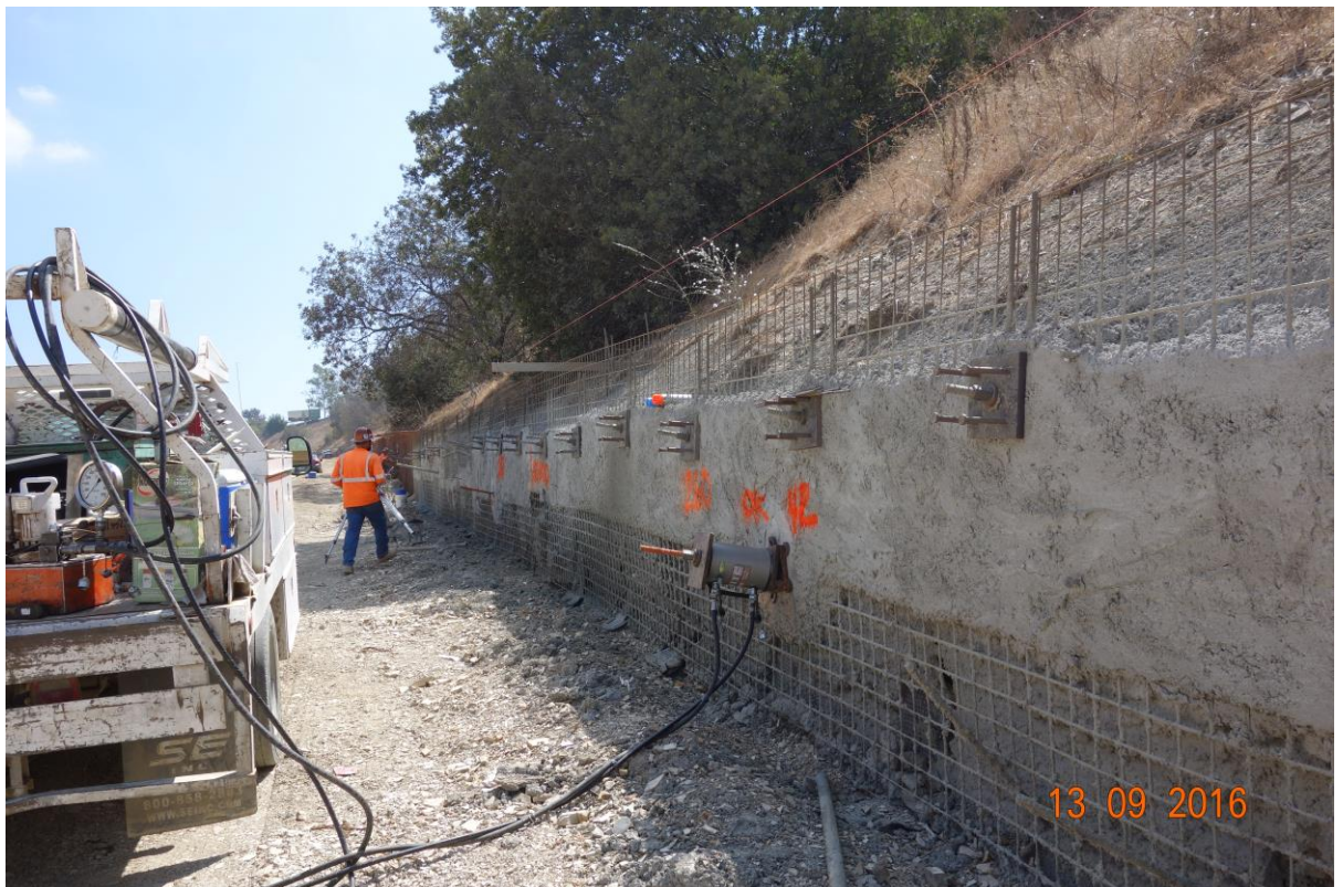
圖五十四 10號高速公路拓寬工程邊坡擋土牆裝設土釘
