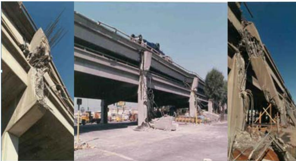
圖十九 雙層高架橋接頭剪力損壞落橋
