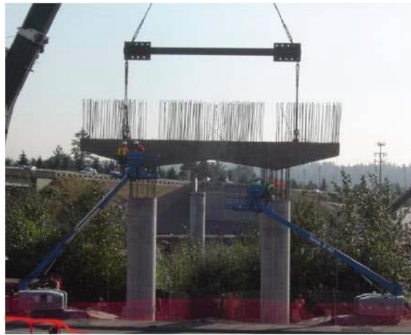
圖二十六 預鑄帽梁吊裝施工
