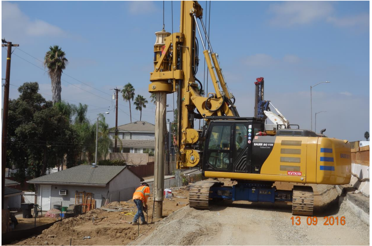
圖五十二 10號高速公路拓寬工程工地觀摩
