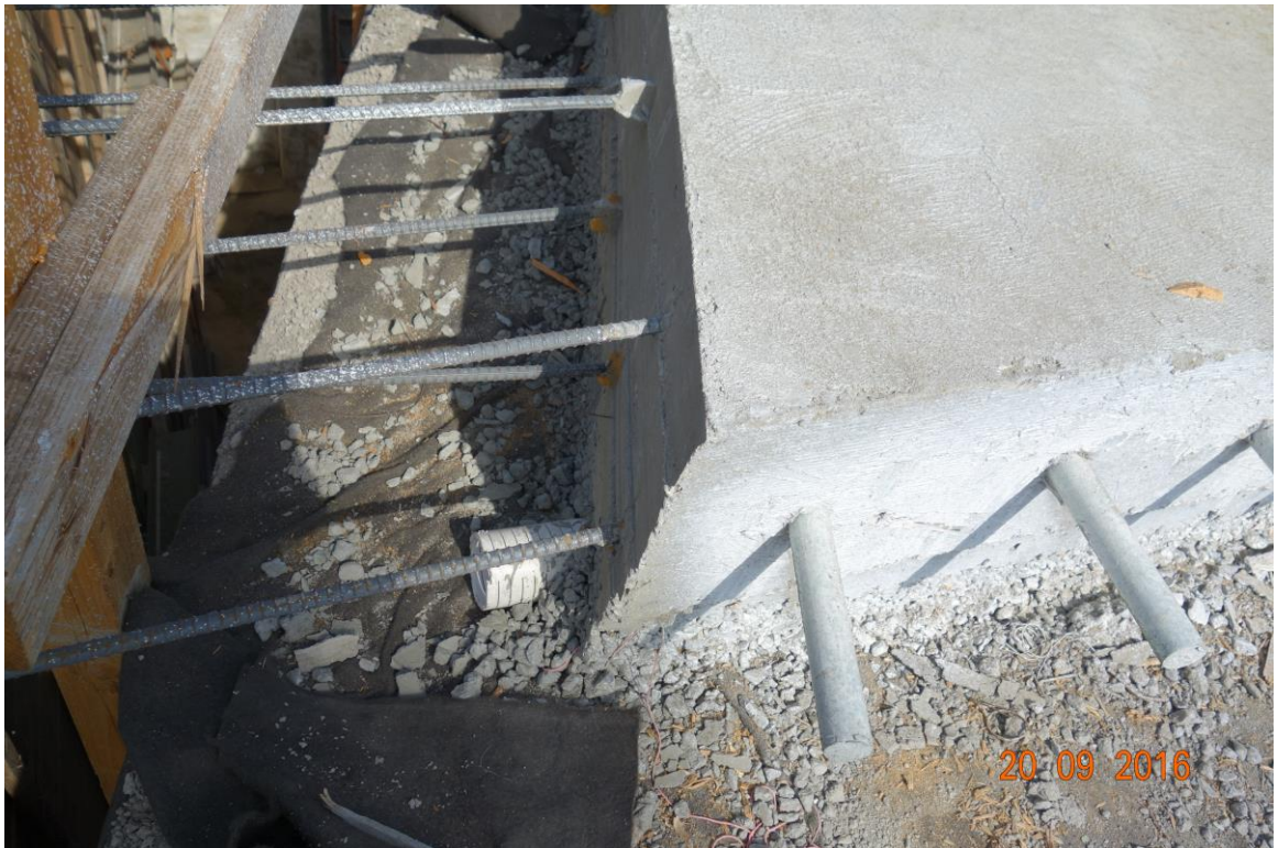
圖五十七 10號高速公路拓寬工程基樁超音波檢測
