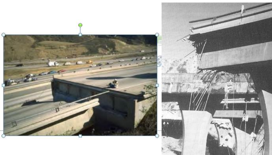
圖二十三 伸縮縫處鉸接破壞落橋
