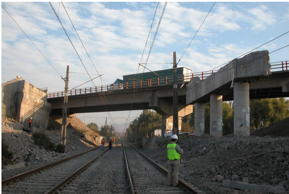
圖十六 斜交角較大落橋
