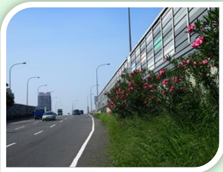
拍攝地點：國道1號高雄交流道
