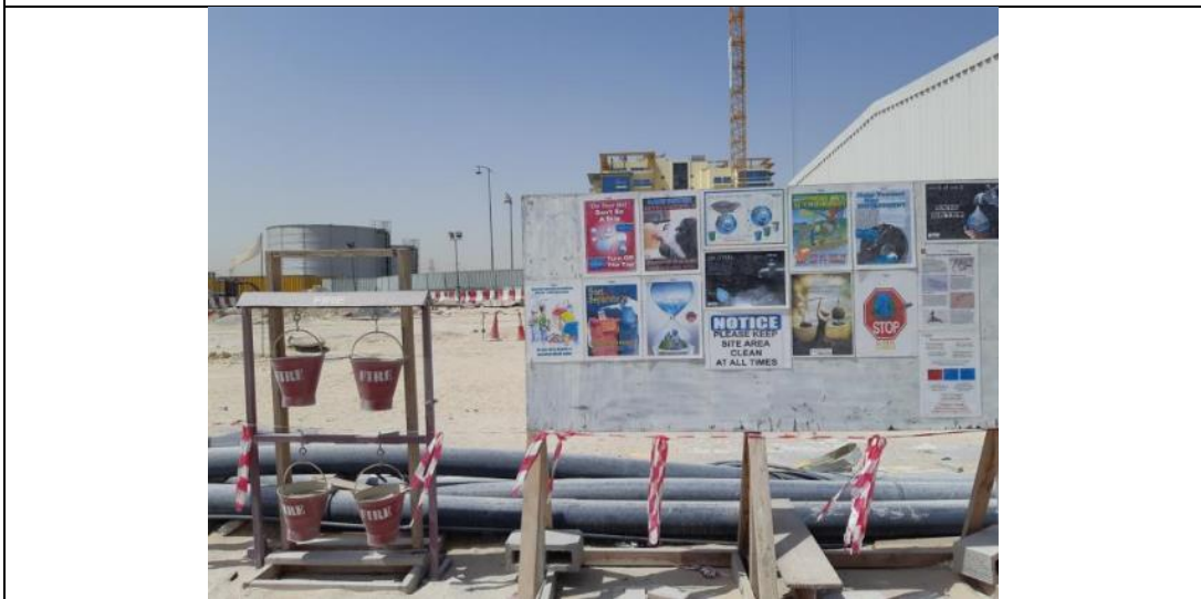
圖 5-6 工地安全告示及消防砂
