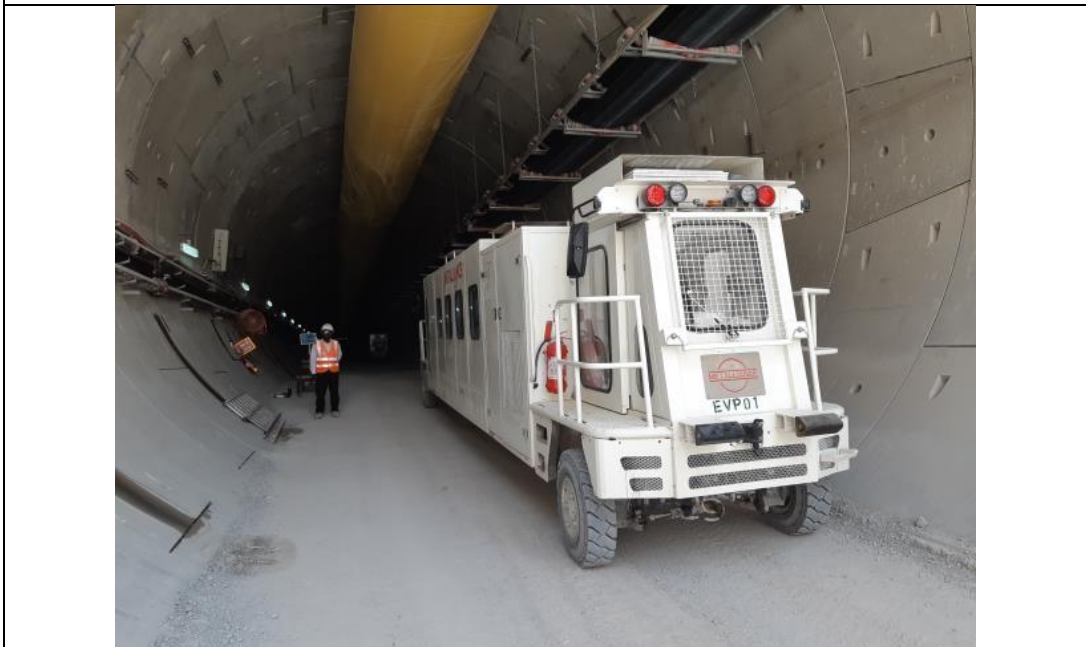
圖 5-12 進出隧道之人員運輸車(兼具避難功能)
