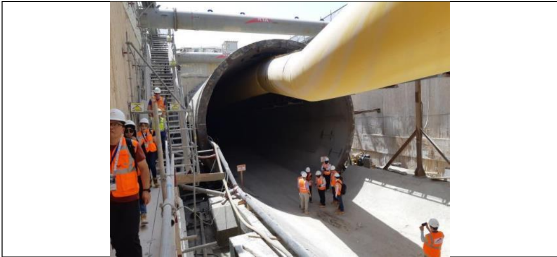
圖 5-8 隧道洞口潛盾機發進起點
