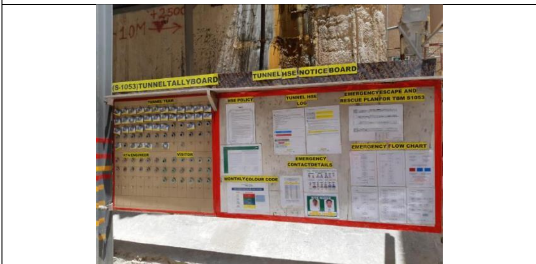
圖 5-7 隧道洞口之人員管制牌
