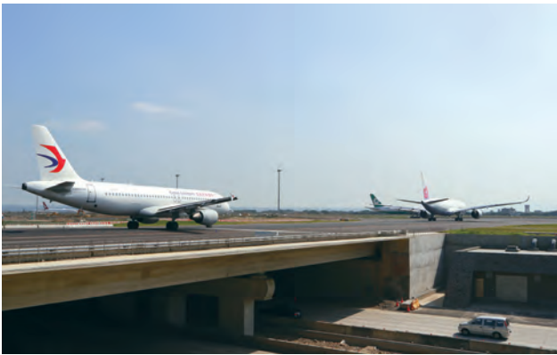
第 C009 標 W2 滑行道 (NC-R) 區段開放 - 航機通過 W2S 跨越橋
