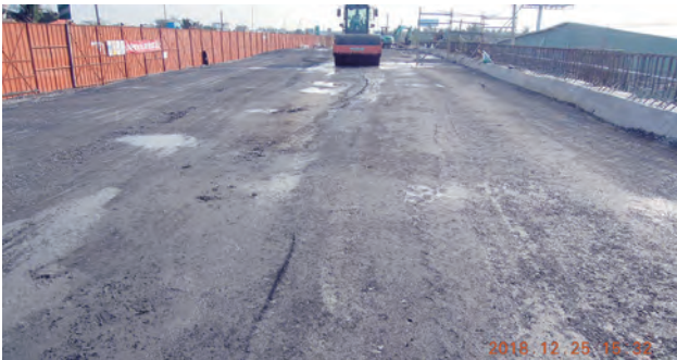
第 5A1 標 高速公路主線級配粒料底層之鋪築與整平
