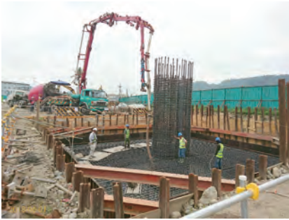
第 C711 標 第一座下構基礎澆置 混凝土 ( 匝 3P12 )
