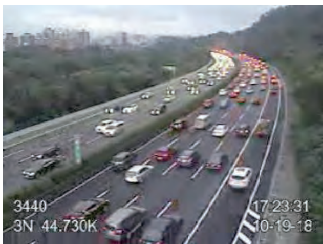
國道 3 號樹林 - 土城北出 (車道及路肩寬調整改善後)
