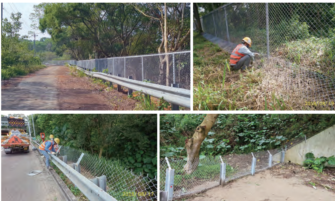
國道 3 號大林隧道設置多功能動物通道—動物通道導引
