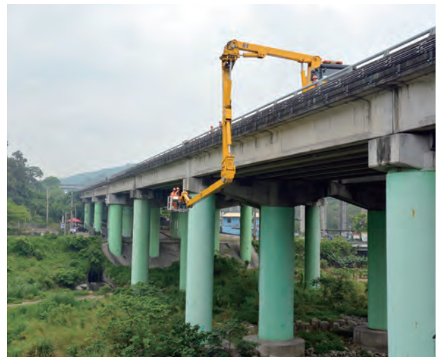
橋梁檢測作業 2
