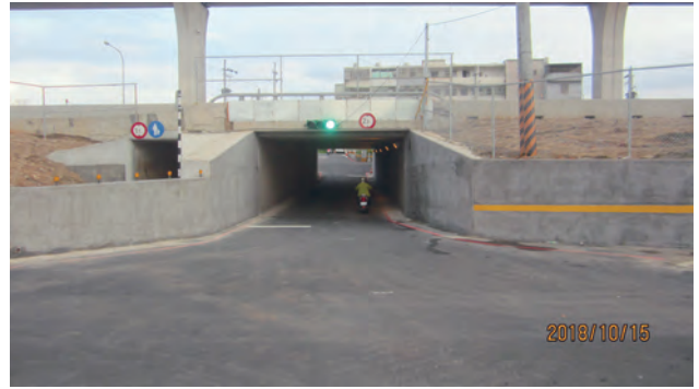
新興街箱涵 通車後現況
