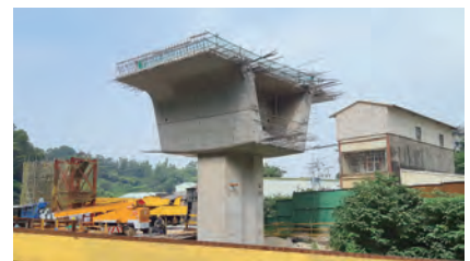
第 C712 標 中坑溪橋 PE1 柱頭節塊完成
