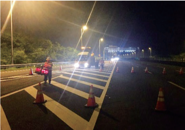
交通管制設施布設與撤除及機具出入施工地區時，派真人旗手指揮
