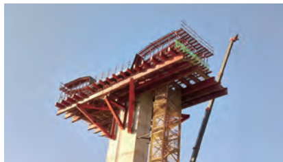
第 C714 標 主線 P23 懸臂柱頭節塊翼腹模板組搭
