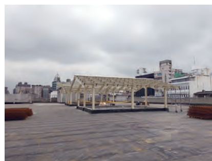
博一工程 屋頂採光罩完成
