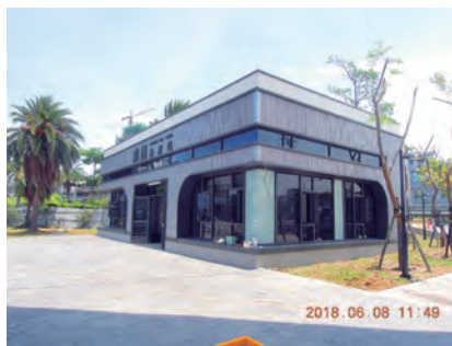
前鎮輪渡站新建工程完工
