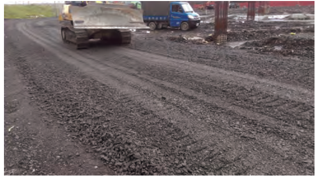
第 E252 標 周邊公共設施配合工程 環場道路路基碎石級配底層鋪設
