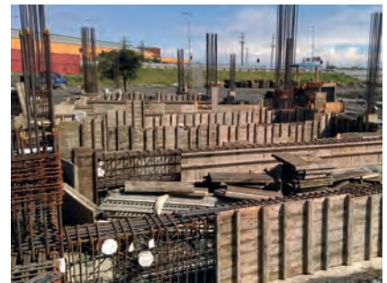
第 E252 標 東側廁所地梁鋼筋模板組立
