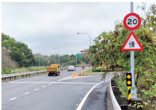
國道3號香山北出設置「慢」及「速限20」標誌，並於右彎岔道加密反光標記
