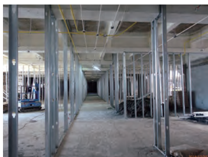
博一工程 輕隔間骨架組立
