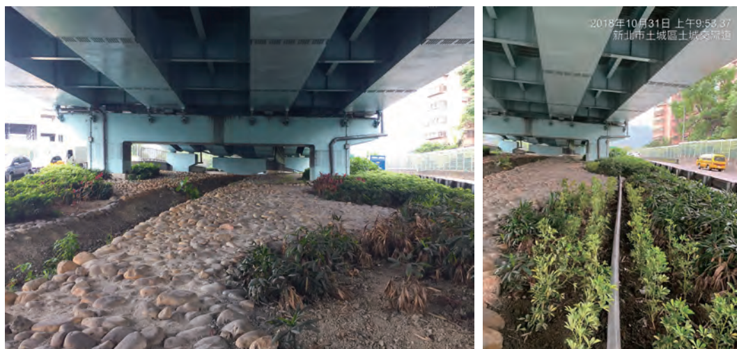
國道 3 號土城交流道高架橋下設置雨水澆灌系統
