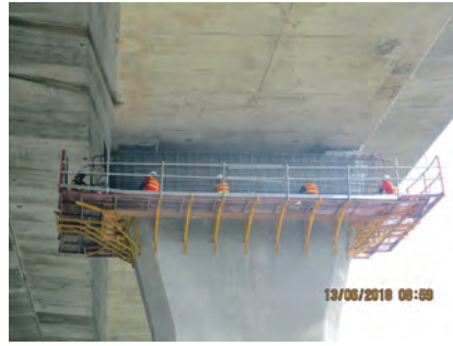
第 M37B 標 牛稠溪橋混凝土止震塊鋼筋綁紮
