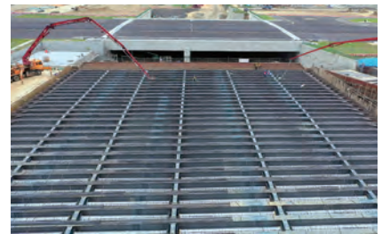
第 C009 標 W1 滑行道航站北路 W1N 跨越橋混凝土澆置
