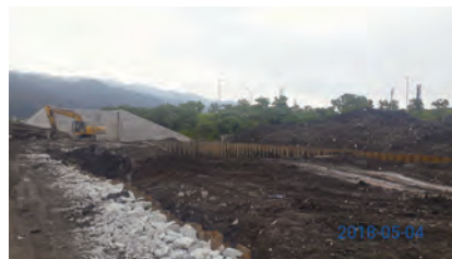
第 E14 標 匝道 R1 1k+427 ~ 1k+520 不適用材料挖除及卵塊石全置換
