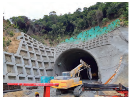
第 C713 標 豐原 3 號隧道東口西行線混凝土及噴凝土格梁施作
