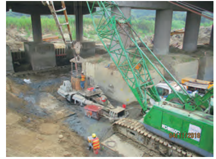
第 M37B 標 龜重溪橋全套管基樁 P5R5 施作
