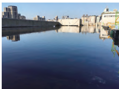
博一工程 屋頂防水層試水作業
