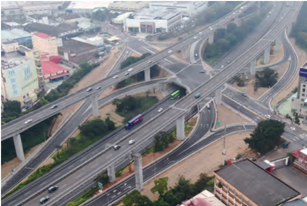
第 214 標 完工後之空拍照二
