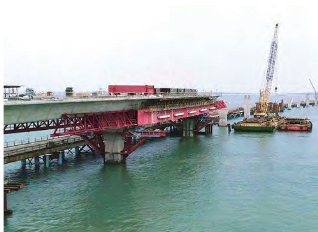
第 CJ02-2C 標 小金端引橋段上部結構施工
