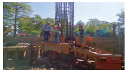
第 C715 標 P33R-1 基樁鋼筋查驗
