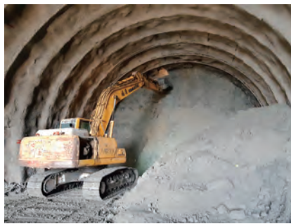
第 C713 標 豐原 3 號隧道東口西行線上半 30 輪開挖
