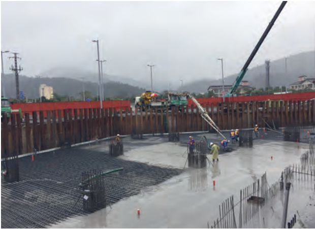
第 E252 標 服務中心地下一層基礎灌漿
