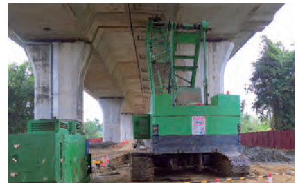
第 M37D 標 南投高架橋全套管基礎施工
