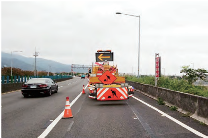
國道 5 號北上 30k+400 路側施工增設緩撞車
