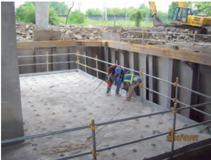
第 M41 標 P42R 基礎植筋鑽孔
