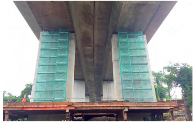
第 M37A 標 石龜溪河川橋 P8 鋼止震施工
