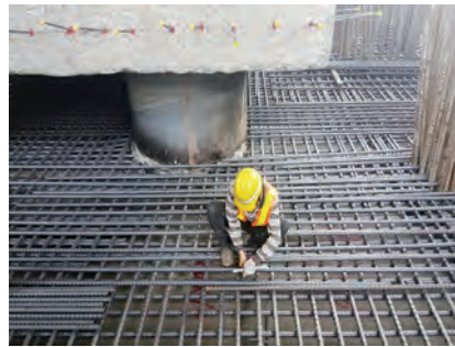
第 M37C1 標 基礎鋼筋綁紮
