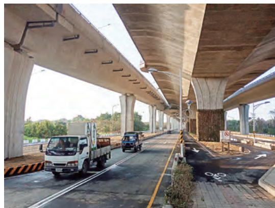
第 D44 標 交流道橋下道路通車情況
