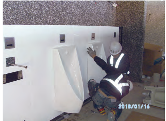
第 E251 標 西側廁所小便器安裝
