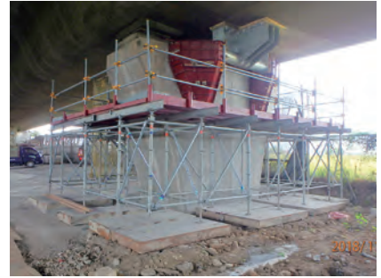
第 M37E 標 霧峰高架橋 P57 鋼止震施工
