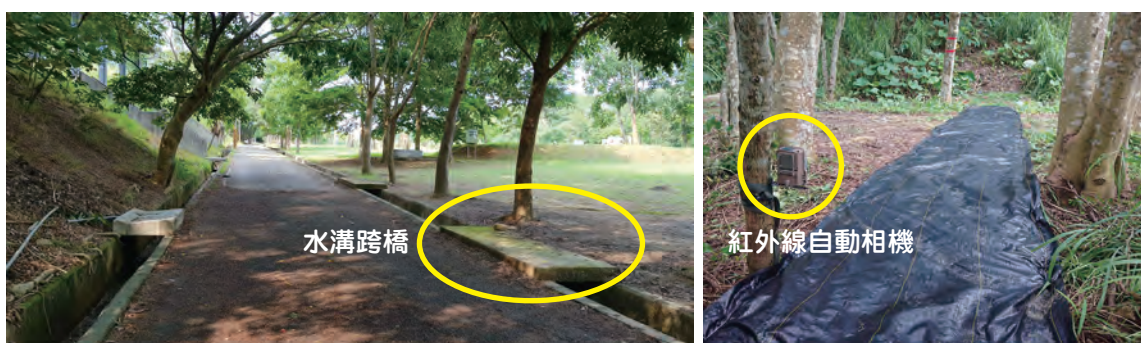
國道 3 號大林隧道設置多功能動物通道—路徑清理與監測
