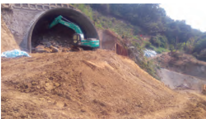
第 C712 標 豐原 2 號隧道東口東行線進洞
