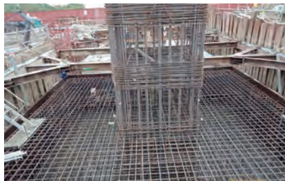
第 H72 標 EBP11R 基礎鋼筋綁紮
