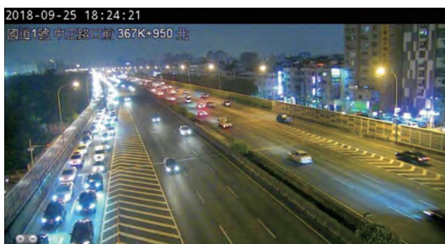
高雄市中正路 (改善前)
