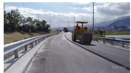
第 E14 標 匝道 R1 路堤段密級配瀝青混凝土鋪築
