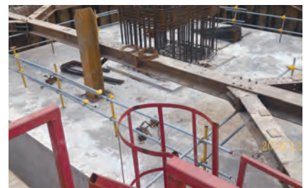
第 H72 標 EBP12R 基礎混凝土澆置完成
