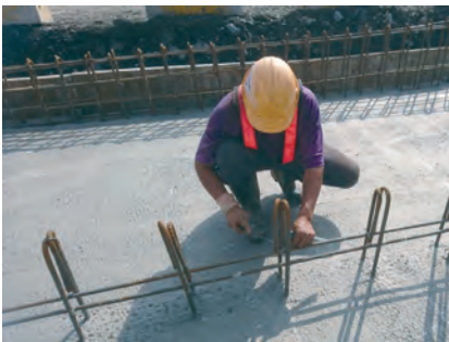
第 E252 標 洗車台鋼筋組立施工
