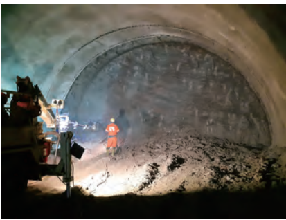
第 C713 標 豐原 3 號隧道東口東行線上半 101 輪噴凝土施作
