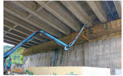
第 M37C2 標 斗六大圳 2 號橋 A2 橋台澆置
