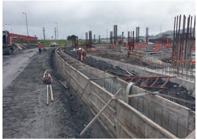
第 E252 標 周邊公共設施配合工程 周邊水溝 (UA502 水溝) 模板組立
