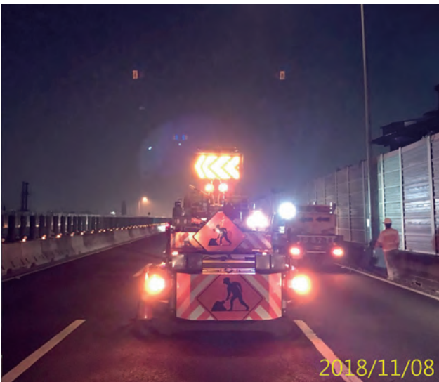
工區近端增設緩撞車及交通錐，前漸變區段增設標誌車
