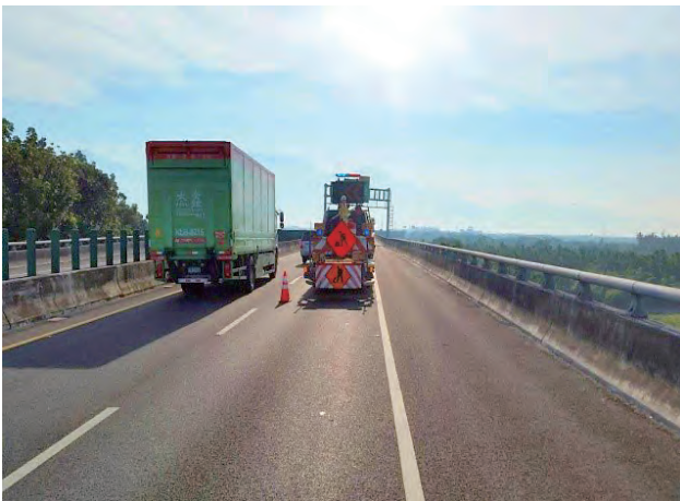
工區近端增設緩撞車及交通錐，前漸變區段增設標誌車
