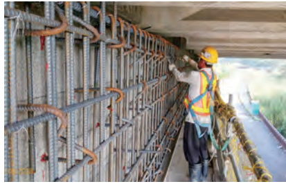
第 M37C2 標 楓樹湖南溪 P1 帽梁 鋼筋組立
