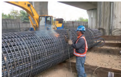
第 M37D 標 南投高架橋鋼筋籠焊接作業
