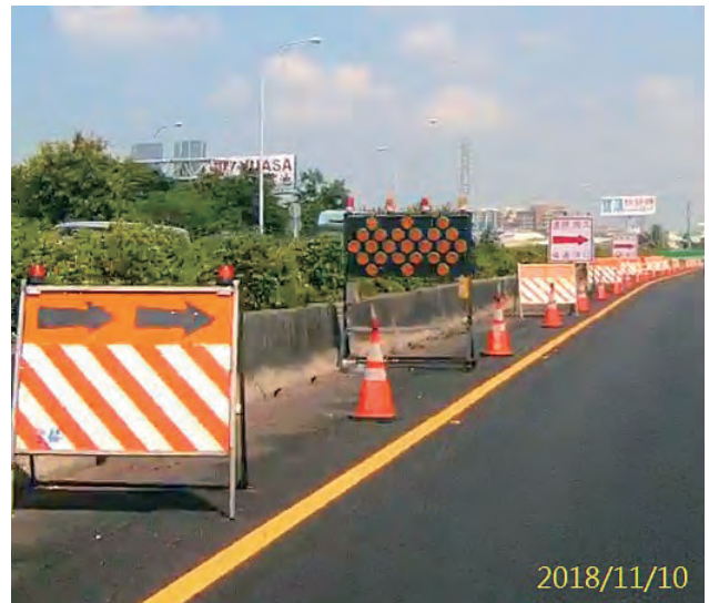
工區近端增設緩撞車及交通錐，前漸變區段增設標誌車
