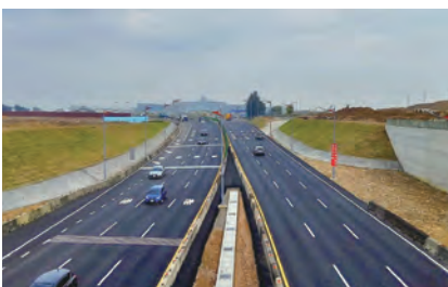
第 C009 標 航站南路第二階段交維改道通車現況
