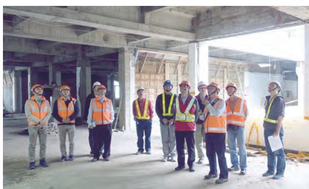
博一工程 趙局長興華視察工地
