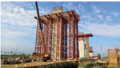
第 C714 標 主線 P24 懸臂柱頭節塊支撐架組搭
