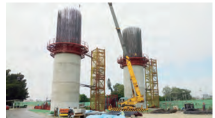
第 C714 標 P8E/W 墩柱昇層繫筋
