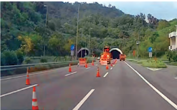
工區近端增設緩撞車、交通錐及交通筒，前漸變區段增設標誌車
