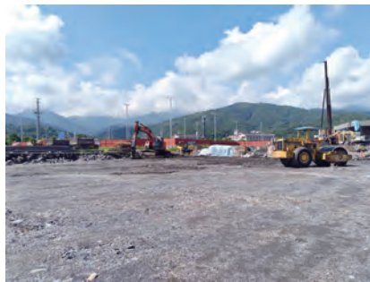
第 E252 標 東側廁所基礎底整地夯實
