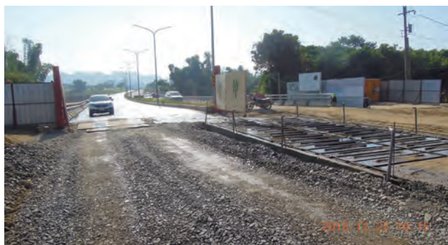
第 L111 及第 L112 合併標 工區出入口便道及洗車台
