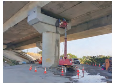
第 M37C1 標 液態阻尼器安裝前鑽孔
