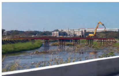
第 H72 標 施工便橋 A 段 R 側架設
