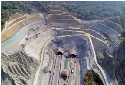
第 D11 標 中寮隧道路塹施工空拍圖
