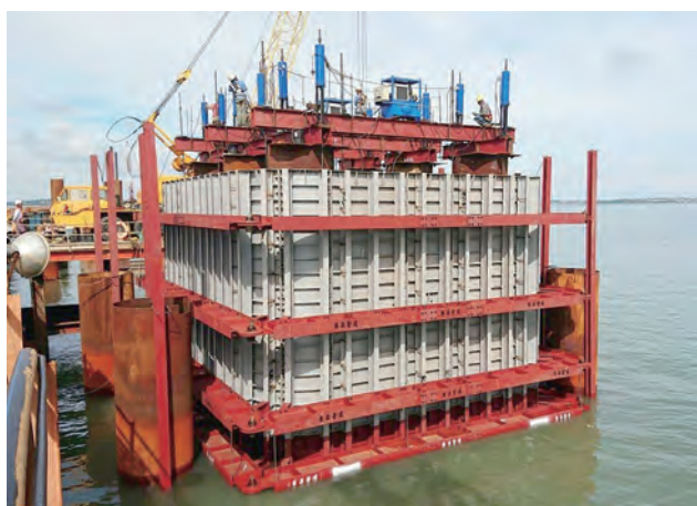
第 CJ02-2C 標 第 1 座樁帽圍堰 (小金引橋段 P15) 下放
