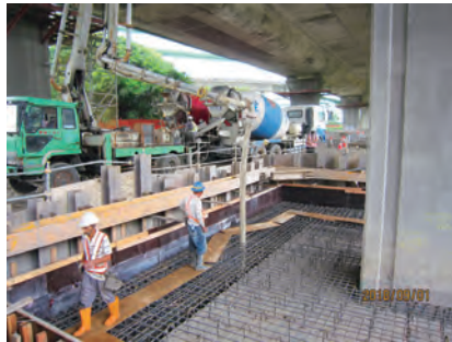
第 M41 標 P44R 基礎 SCC 混凝土澆置
