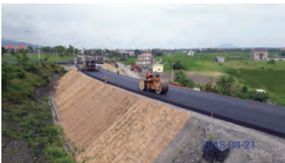
第 E14 標 匝道 L1 路堤段瀝青處理底層及密級配瀝青混凝土鋪築
