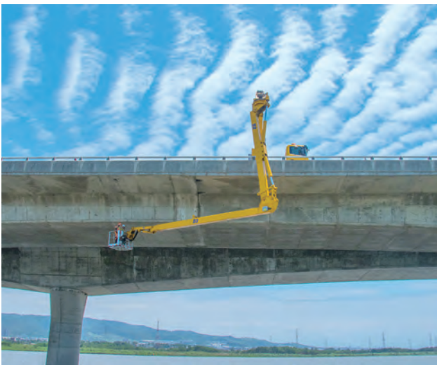
橋梁檢測作業 1
