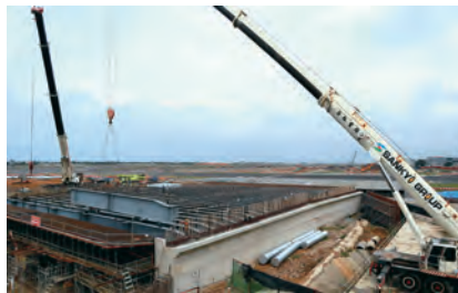
第 C009 標 W1 滑行道航站北路 W1N 跨越橋鋼梁吊裝
