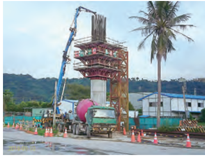
第 C711 標 匝 3P11 墩柱第 4 昇層 澆置
