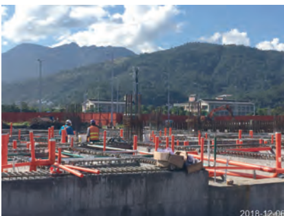
第 E252 標 東側廁所水電管線施工
