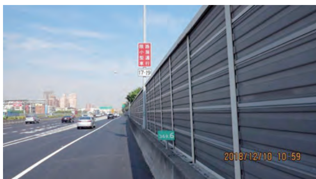
國道1號北上中正路出口開放路肩
