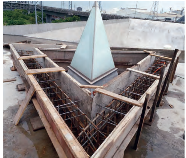
第 E251 標 西側廁所屋頂景觀座椅鋼筋模板組立
