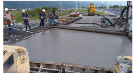
第 E14 標 農路 FP30-1 剛性路面混凝土鋪築
