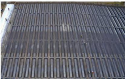
第 C009 標 W1 滑行道航站北路 W1N 跨越橋頂板鋼筋綁紮
