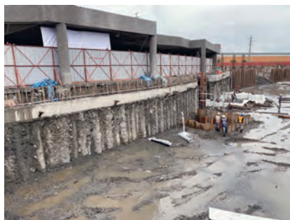
第 E252 標 預壘樁施作完成
