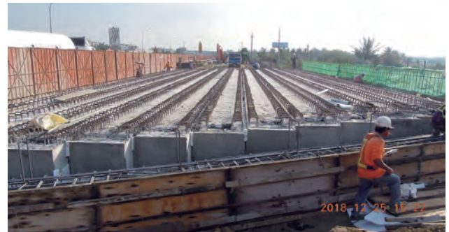
第 5A1 標 簡支密排預力中空板梁施工
