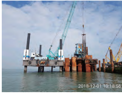
第 CJ02-2C 標 P47 基樁工作面 (P47-17 鋼筋籠下放)
