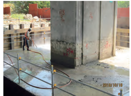
第 M41 標 P46R 基礎表面水刀處理施工
