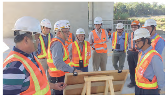
第 M37A 標 崙子溪河川橋簡易水保完工檢查
