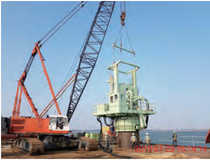
第 CJ02-2C 標 第 1 支直徑 2.5M 基樁展開施工 (深槽區主橋段 P48)
