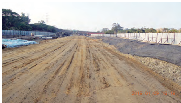
第 L111 及第 L112 合併標 路基級配滾壓
