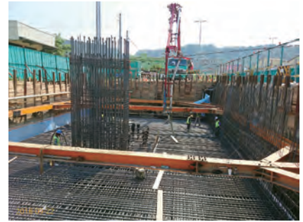
第 C711 標 PW21 基礎澆置
