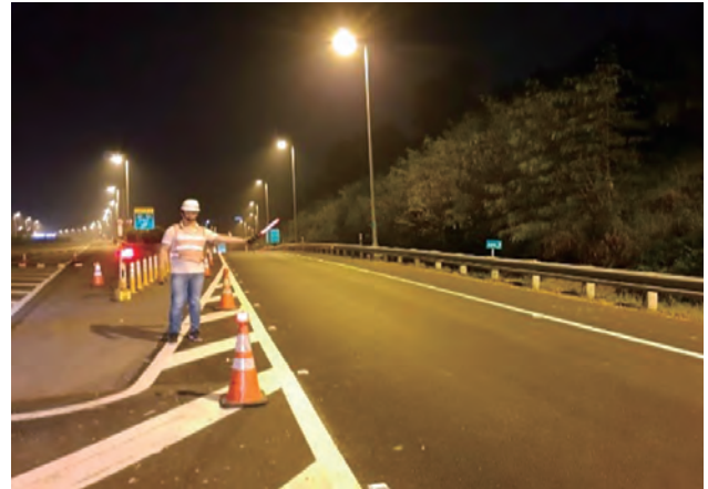
交通管制設施布設與撤除及機具出入施工地區時，派真人旗手指揮
