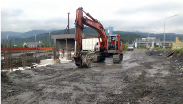
第 E252 標 周邊公共設施配合工程 環場道路路基整地
