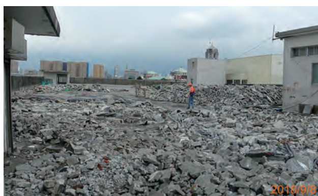
博一工程 屋頂既有防水隔熱層拆除
