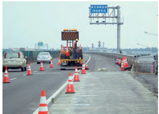
工區近端增設緩撞車及交通錐，前漸變區段增設標誌車
