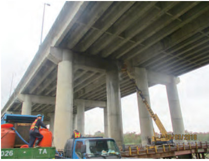
第 M37B 標 八掌溪河川橋帽梁表面水刀處理
