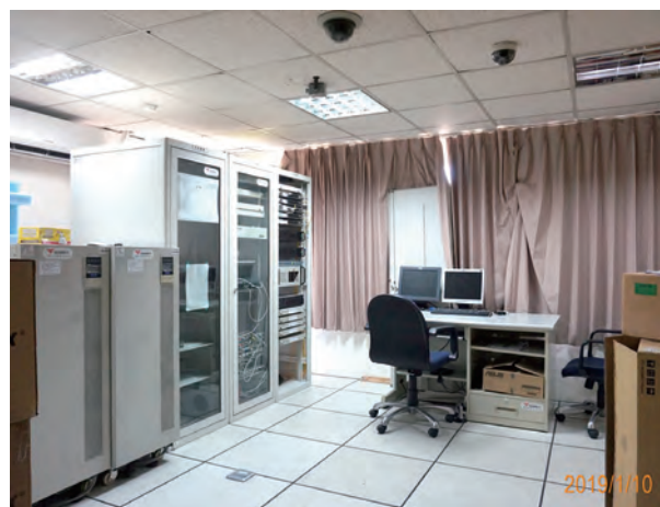
國道 1 號汐止收費站 - 遠通電收承租作為電子收費系統維運空間辦公室使用
