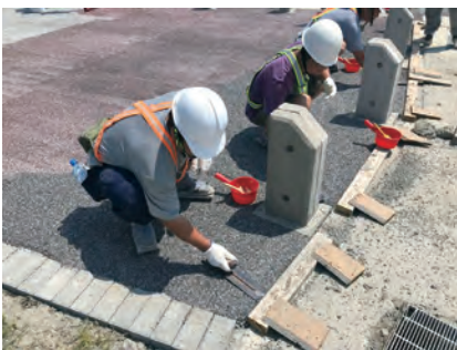
第 E251 標 停車場透水鋪面磁質面層施工
