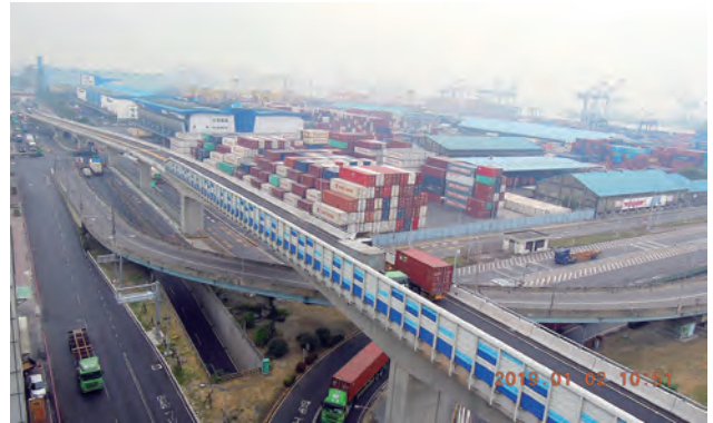
第 CM01 標 通車後高雄港聯外高架道路及四、五貨櫃中心遠景
