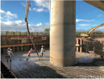
第 M37E 標 烏溪三號橋 P52R 基礎澆置
