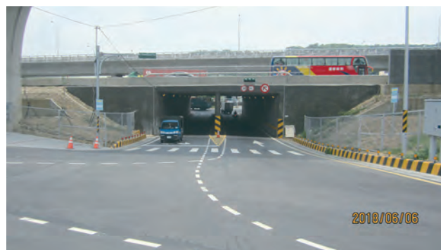
桃 6 線箱涵 通車後現況
