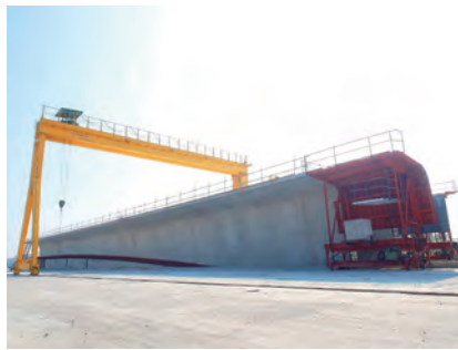
第 CJ02-2C 標 預鑄節塊生產情形
