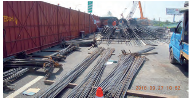
第 5A1 標 基樁鋼筋籠施工
