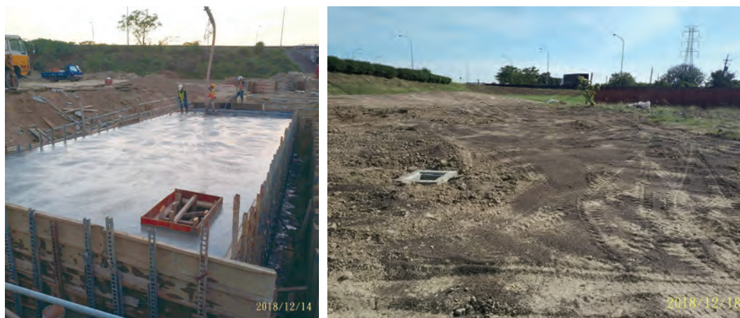
國道 1 號大林至高雄段整體景觀改善工程－路竹交流道
