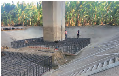
第 M37D 標 南投高架橋 P83L 基礎鋼筋綁紮
