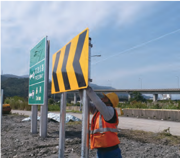
第 E251 標 停車場導引牌面安裝
