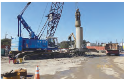
第 H72 標 T15RP4#1 全套管基樁鑽掘施工
