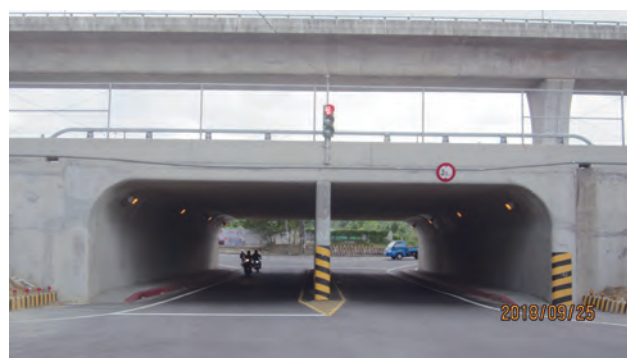
龍安街箱涵 通車後現況
