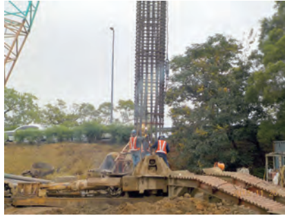
第 M37E 標 中興交流道基樁施工
