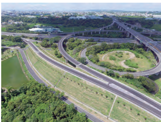
第 I14 標 北側匝道 R4 及 R7 竣工
