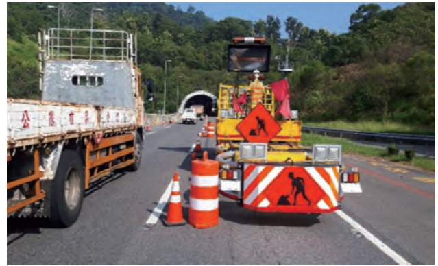
工區近端增設緩撞車、交通錐及交通筒，前漸變區段增設標誌車
