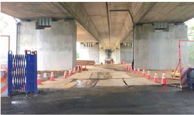
第 M37A 標 大湖口溪排水橋 P4 增設剪力樁施工
