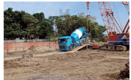
第 H72 標 EBP5L#2 全套管基樁混凝土澆置
