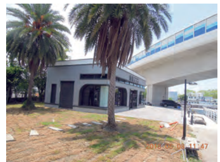
前鎮輪渡站新建工程完工
