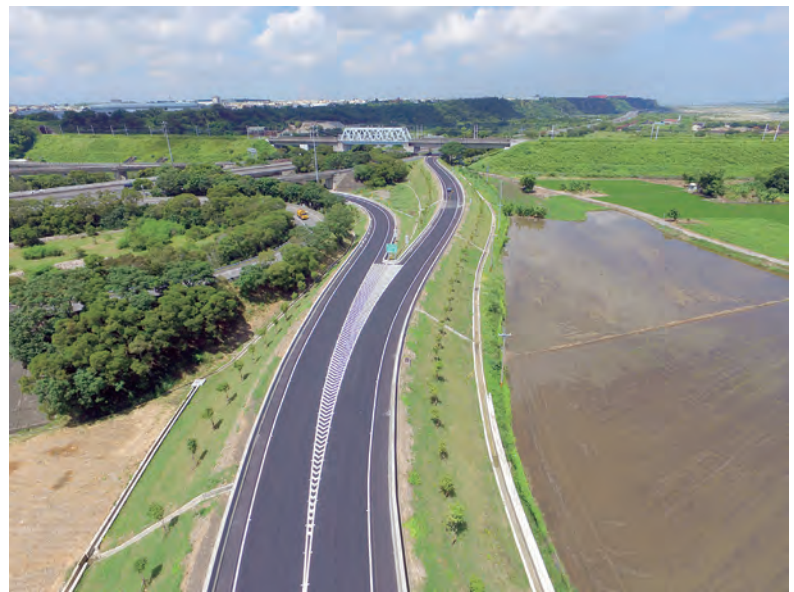
第 I14 標 北側匝道 R2 及 R5 竣工
