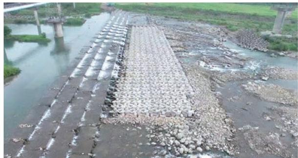
圖 5-20.1 頭前溪固床工鼎塊流失修復（105 年拍攝）
