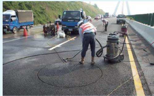
圖 5-23.13 圓形環路線圈施工
