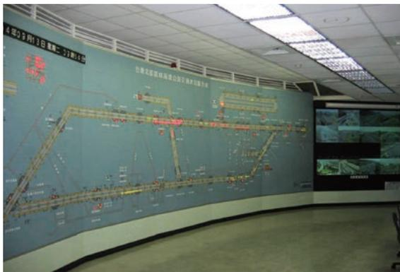
圖 5-23.29 點陣式面板及閉路電視監視牆
