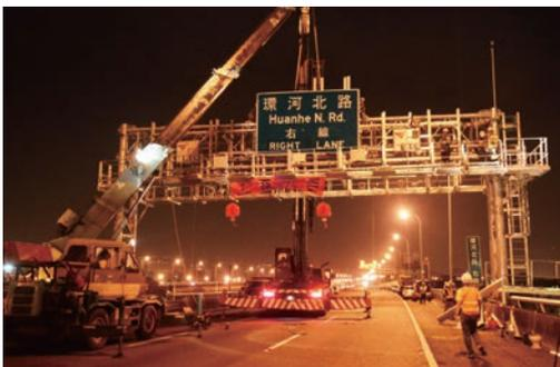
圖 7-3-3.4 第 319 座 ETC 門架吊裝作業
