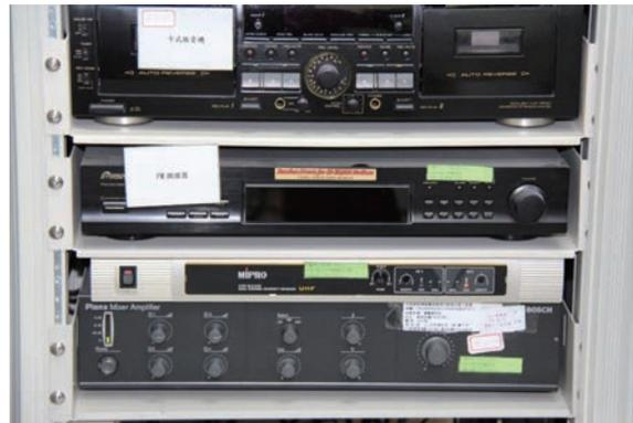
圖 5-23.28 隧道廣播系統語音設備
