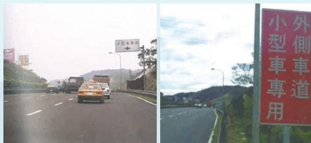
圖 5-7.4 國道 1 號基隆～汐止南向路段劃設為三車道情形
