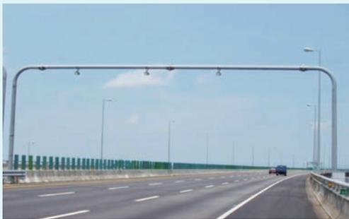
圖 5-23.14 高架式車輛偵測器
