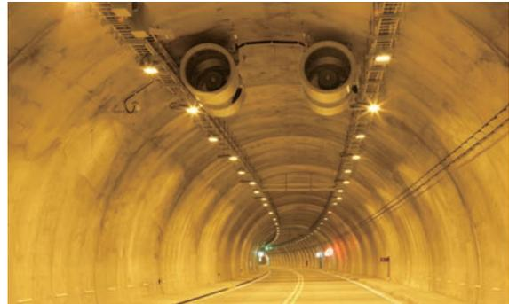
圖 5-26.2 隧道噴流式風機
