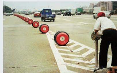
圖 7-2-2.4 泰山收費站中央分隔島輪軸式設置
