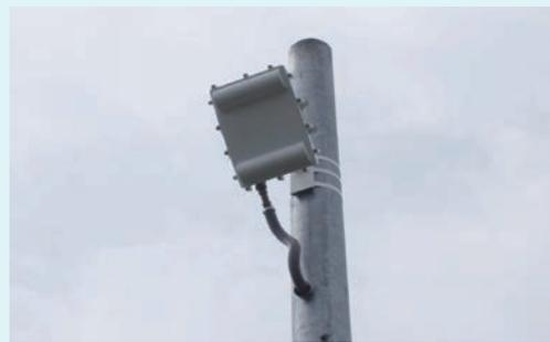
圖 5-23.15 路側式 (微波) 車輛偵測器
