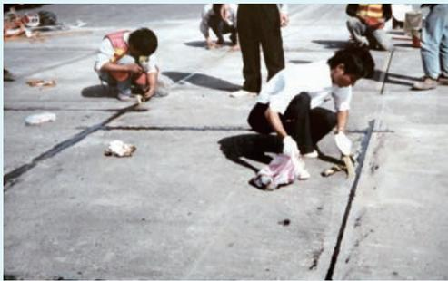
圖 5-23.12 方形環路線圈施工
