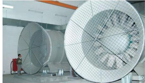
圖 5-26.3 雪山隧道軸流式風機
