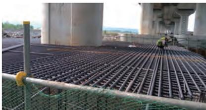
圖 3.79 第 M37C1 標 濁水溪河川橋 P32R 基礎補強鋼筋綁紮
