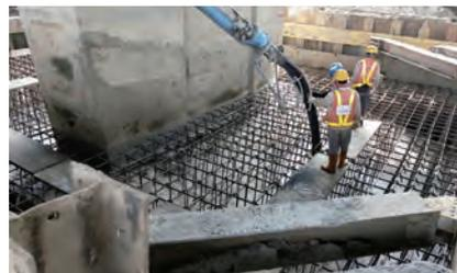
圖 3.84 第 M37C2 標 斗六東溪 P3 基礎混凝土澆置
