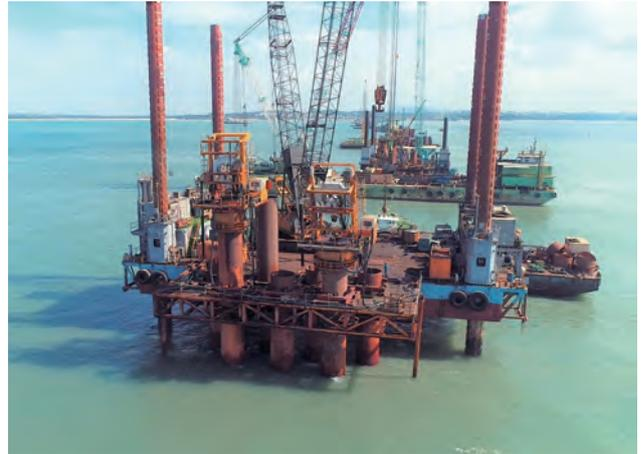
圖 3.102 第 CJ02—2C 標 P41 基樁施工作業
