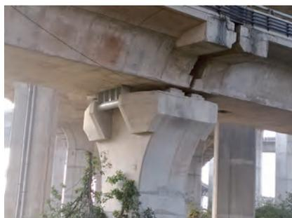
圖 3.95 第 M37F 標中港系統匝 5 PR5—20 鋼止震施作完成
