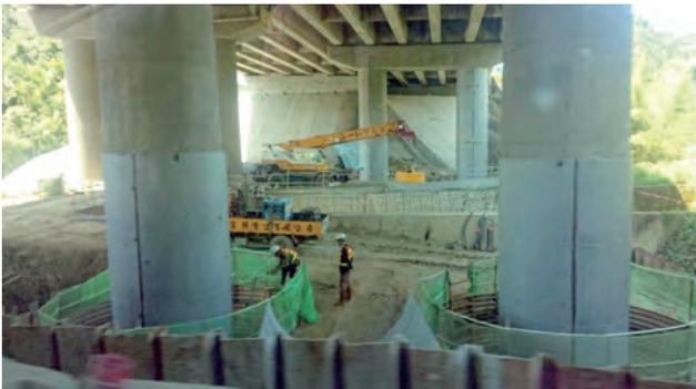
圖 3.77 第 M37B 標仁義潭八號 PS2 墩柱鋼板包覆補強
