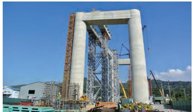
圖 3.49 第 C714 標 主線 P6、P7 墩柱區支撐鋼梁
