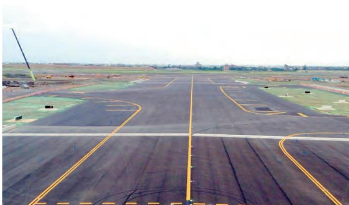
圖 3.132 第 X004 標滑行道指示燈光竣工
