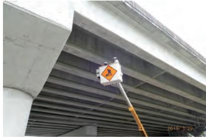
圖 4.4 橋梁檢測作業 2—高空作業車檢測
