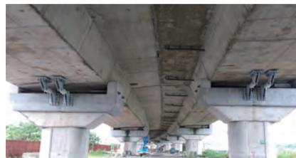
圖 3.81 第 M37C1 標 濁水溪河川橋 P4RL 液態黏滯性阻尼器
