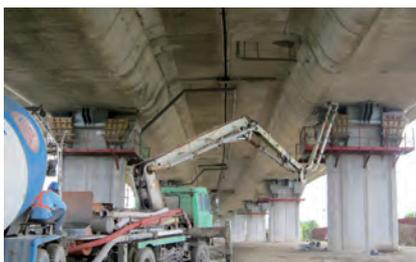
圖 3.99 第 M41 標 豐原高架橋 P9R 混凝土擋塊混凝土澆置
