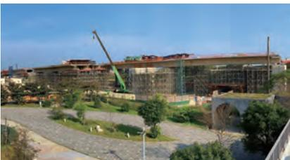
圖 3.23 第 H72 標主線合併段場鑄逐跨工法
