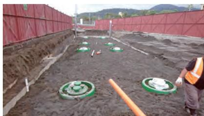
圖 3.66 第 E253 標油槽區油槽吊裝至護體完成回填
