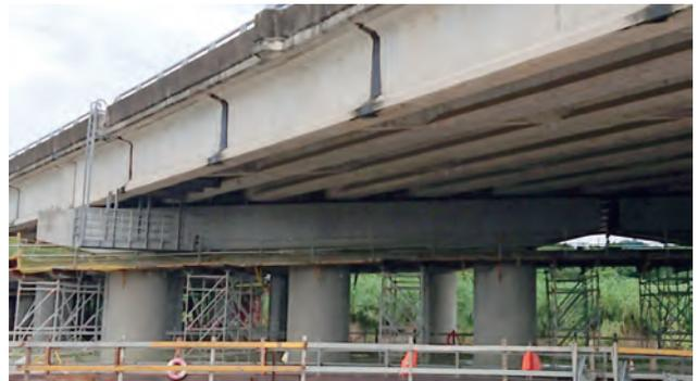
圖 3.78 第 M37B 標龜重溪 P4 端隔梁模板組
