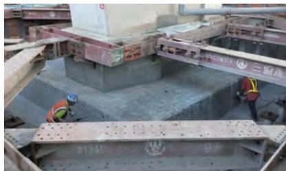
圖 3.83 第 M37C2 標 鐵路二號 PS6 基礎植筋鑽孔
