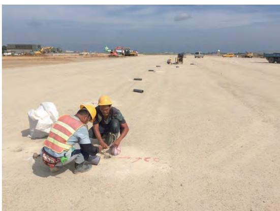
圖 3.131 第 X004 標 W1 滑行道鑽孔安裝燈具
