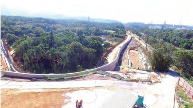
圖 3.31 第 B44 標 L1 及 L3 右側擋土牆施作完成
