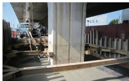
圖 3.101 第 M41 標 豐原高架橋 P114R 基礎 SCC 混凝土澆置
