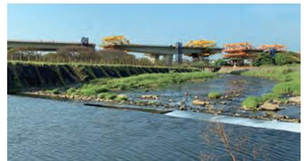
圖 3.25 第 H72 標主線跨越新街溪段懸臂工法
