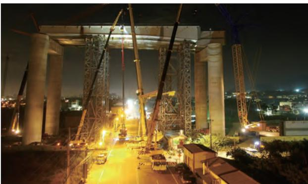
圖 3.50 第 C714 標主線 U2 單元 P6 ~ P7 夜間鋼梁吊裝
