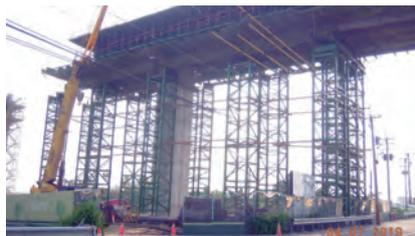
圖 3.55 第 C715 標 場撈 U4E-4 底腹支撐架搭設
