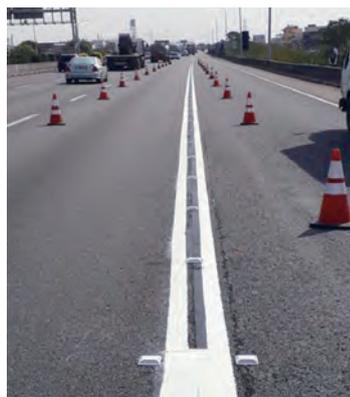
圖 6.10 國道 1 號彰化南入槽化區往下游延伸禁止變換車道線，標記加密為 1 個 / 公尺
