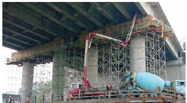
圖 3.76 第 M37B 標獅子頭溪 P2 帽梁混凝土
