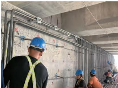
圖 3.90 第 M37E 標 石川里高架橋 P5 帽梁鋼筋組立
