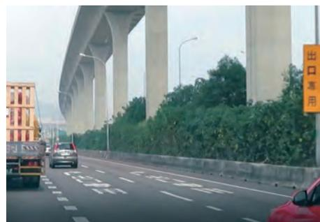
圖 6.8 國道 1 號雙向桃園至機場系統路段車道重新規劃，調整為 2 個出口專用車道—2
