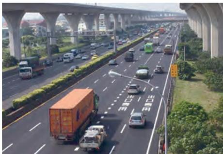
圖 6.7 國道 1 號雙向桃園至機場系統路段車道重新規劃，調整為 2 個出口專用車道—1
