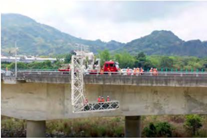
圖 4.3 橋梁檢測作業 1—橋檢車檢測
