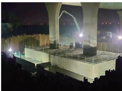
圖 3.94 第 M37F 標國道 3 號大安溪橋 P7LR 基礎補強施作
