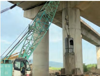
圖 3.85 第 M37D 標 南投高架橋 P2R 基樁施作
