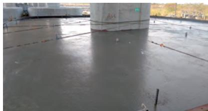
圖 3.80 第 M37C1 標 濁水溪河川橋 P19R 基礎補強澆置混凝土
