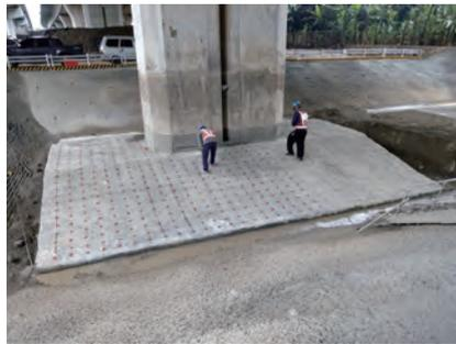
圖 3.86 第 M37D 標 南投高架橋 P110R 植筋鑽孔前放樣
