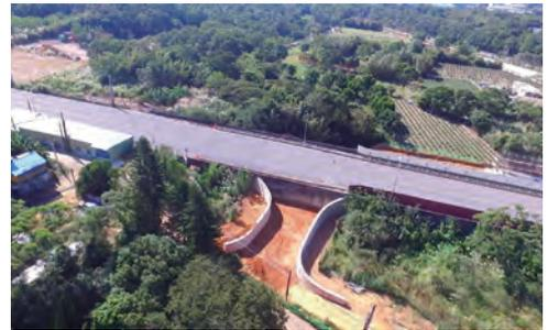
圖 3.30 第 B44 標 FP-14 雙側擋土牆施作完成
