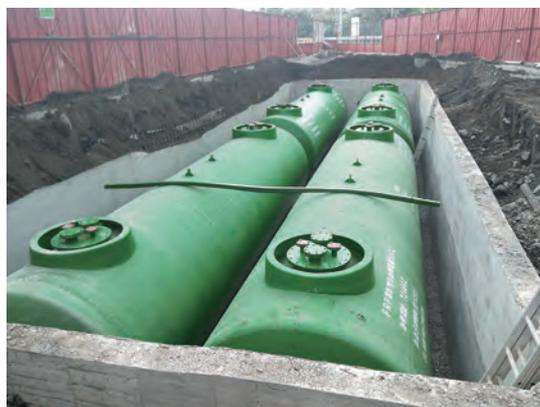
圖 3.65 第 E253 標油槽區油槽吊裝至護體固定
