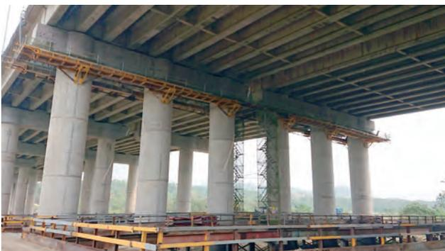
圖 3.75 第 M37B 標八掌溪河川橋 P11N 帽梁補強
