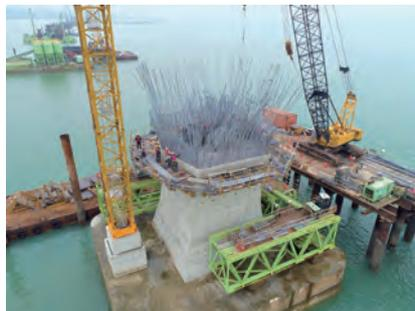
圖 3.104 第 CJ02—2C 標 P48 墩柱昇層施工
