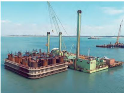
圖 3.103 第 CJ02—2C 標 P46 樁帽鋼箱下放作業
