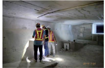
圖 4.5 橋梁檢測作業 3—箱型梁內部檢測
