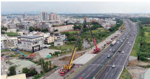
圖 3.111 第 5A1 標 第四階段跨越橋預力中空密排梁吊梁作業
