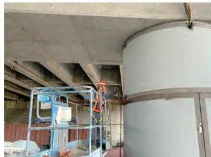
圖 3.92 第 M37E 標 投四穿越橋 P1 鋼板包覆安裝
