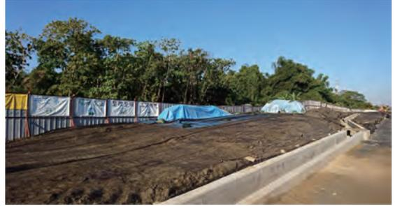
圖 3.69 第 L111 及第 L112 標合併標工區防塵網覆蓋
