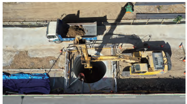
圖 3.9 第 186 標 環中路台 74 線橋下 PE17 井式基礎開挖
