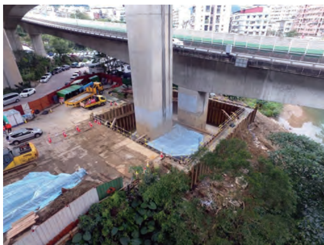
圖 3.134 第 M38D1 標 第一號橋 PR1 - 6 橋墩基礎補強工程
