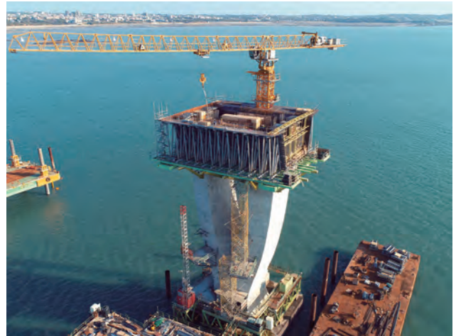
圖 3.150 第 CJ02-2C 標 主橋 P48 柱頭節塊施工
