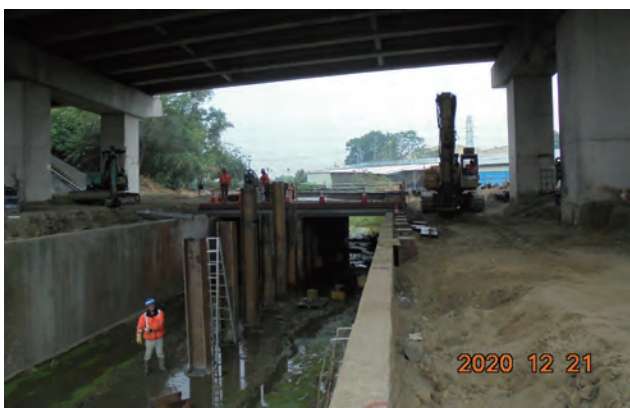
圖 3.113 第 M38A3 標 深坑溪橋河川上構台作業
