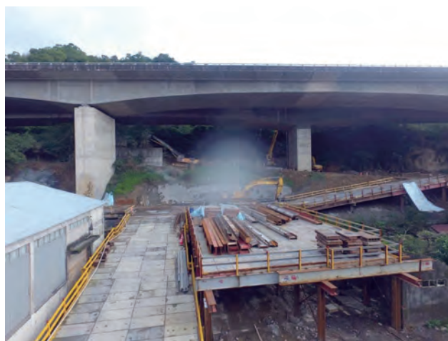
圖 3.135 第 M38D1 標 第十號橋（汐萬路）PS10C - 2 橋墩基礎補強及構台搭設工程
