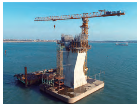
圖 3.148 第 CJ02-2C 標 主橋 P46 墩柱昇層施工
