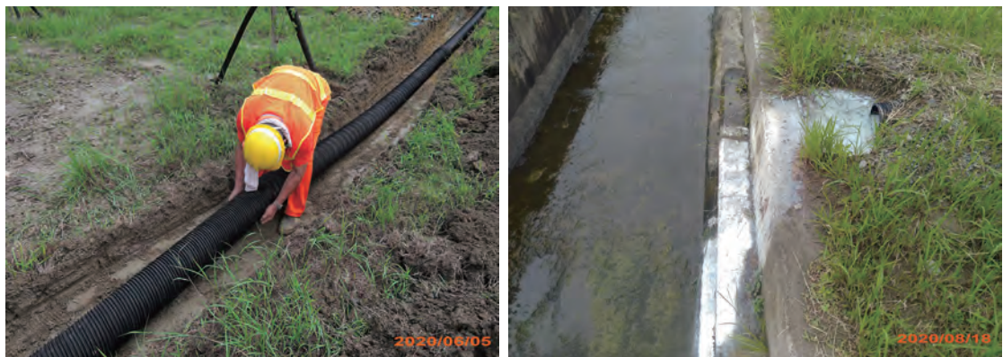
圖 4.8 國道 3 號燕巢系統交流道排水改善 （左圖）：埋設盲溝作業中 （右圖）：施工完成後，盲溝排水情形
