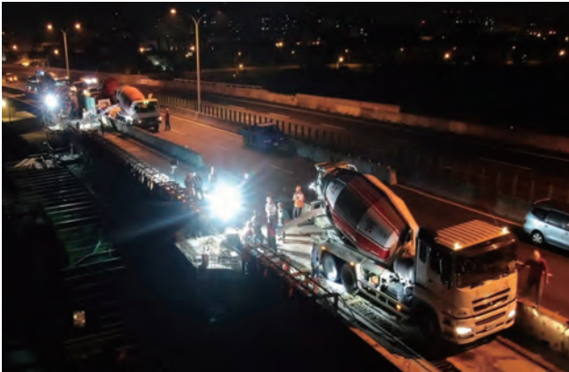
圖 3.63 第 C715 標 夜間二次混凝土澆置施工
