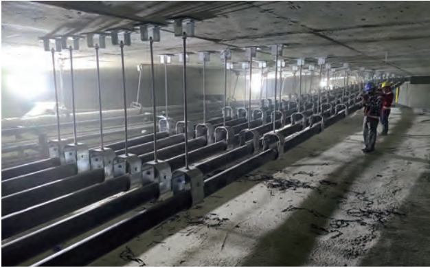
圖 3.90 第 M37D 標 南投高架橋 P100L 箱型梁內外置預力套管施工作業
