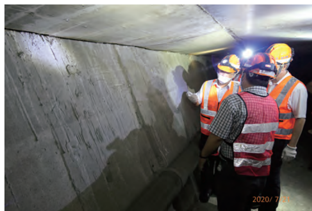
圖 4.5 橋梁檢測作業 - 箱型梁內部檢測
