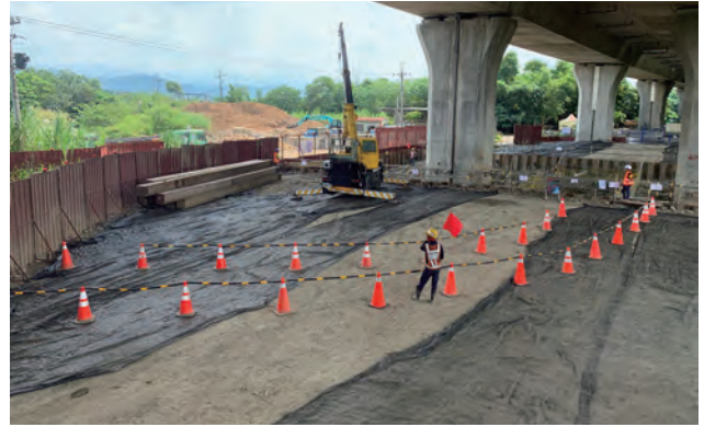
圖 3.91 第 M37D 標 南投高架橋 P53R 基礎補強擋土支撐打設作業
