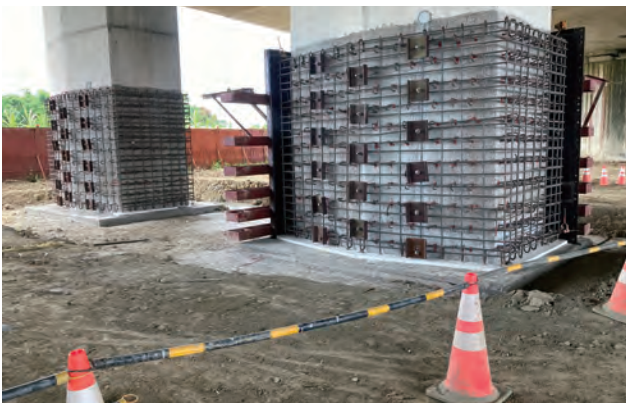
圖 3.103 第 M37G 標 墩柱包覆鋼模組立
