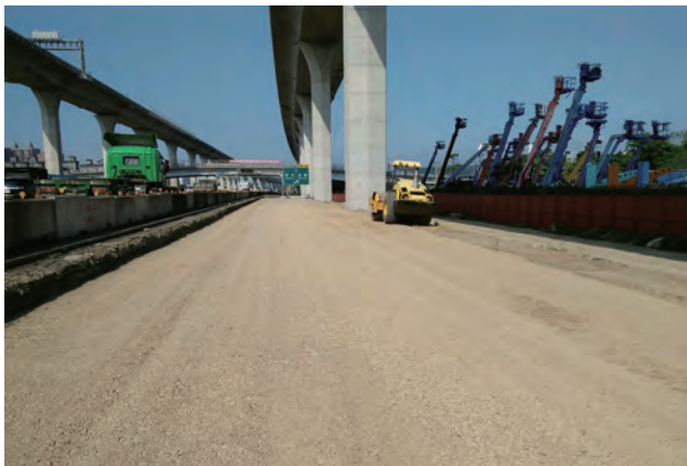
圖 3.1 第 164 標 國道 1 號北上側交維改道路堤填築
