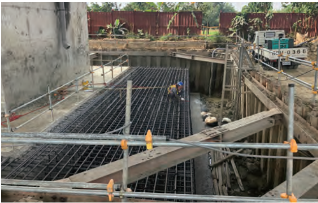
圖 3.101 第 M37G 標 基礎鋼筋角隅焊接
