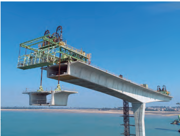
圖 3.151 第 CJ02-2C 標 大金邊橋 P50 預鑄節塊吊裝
