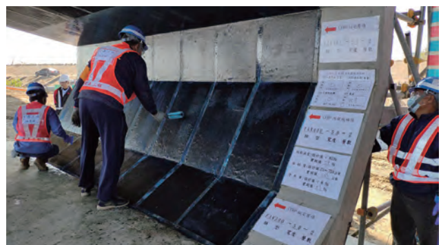
圖 3.121 第 M38B 標 碳纖維 (CFRP) 貼片實作驗證
