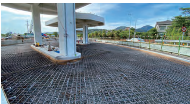
圖 3.70 第 E253 標 加油站泵島地坪鋼筋綁紮
