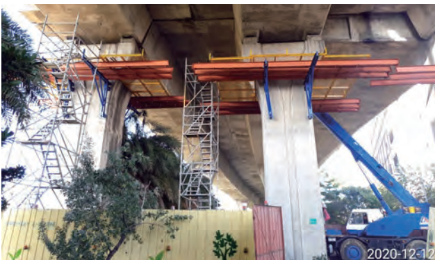
圖 3.99 第 M37F 標 國道 3 號大甲聯絡道高架橋 (PC07) 上構補強施作
