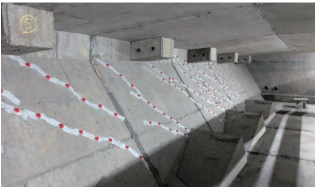
圖 3.77 裂縫補強注射環氧樹脂作業
