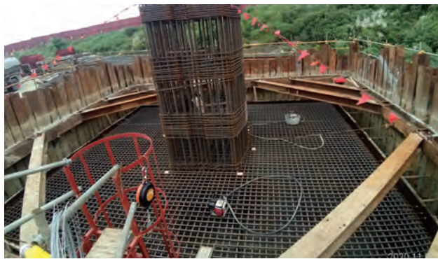
圖 3.33 第 336 標 橋梁 SR1P10 直基礎施工
