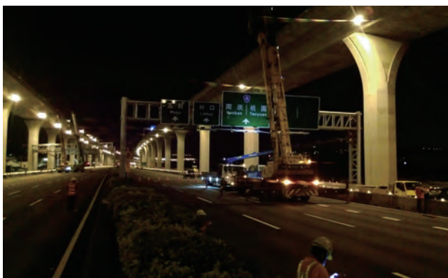
圖 3.3 第 164 標 國道 1 號路段全面封閉進行門架吊裝作業築
