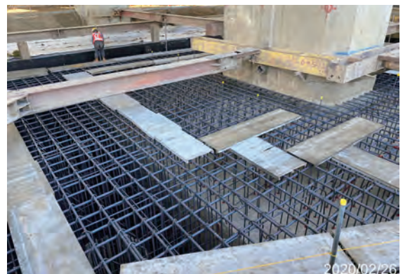
圖 3.89 第 M37D 標 南投高架橋 P12R 基礎補強模板組立
