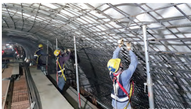
圖 3.50 第 C712 標 豐原 1 號隧道襯砌鋼筋綁紮及機電配管
