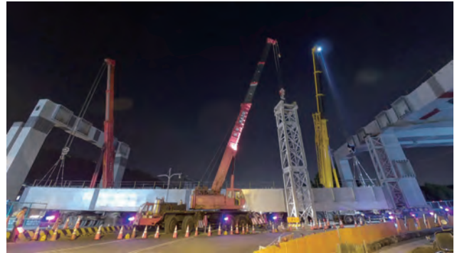
圖 3.45 第 C711 標 P26-P27 GA33 ~ GA36 鋼箱梁夜間吊裝
