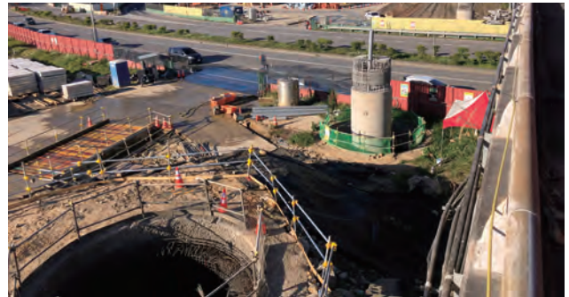
圖 3.32 第 336 標 橋梁墩柱基礎施工
