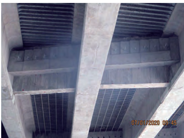
圖 3.79 第 M37B 標 深坑溪橋 P1、P2 防震拉條施工
