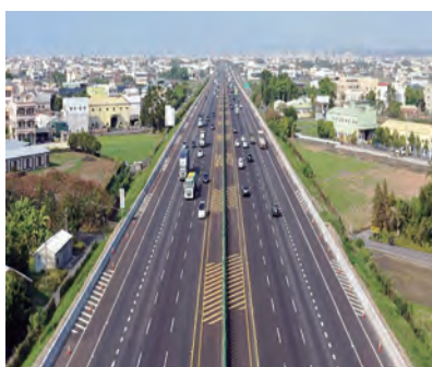
圖 6.21 國道 1 號彰化戰備道雙向，外側增設護欄、內外側護欄增設 LED 路形導引設施
