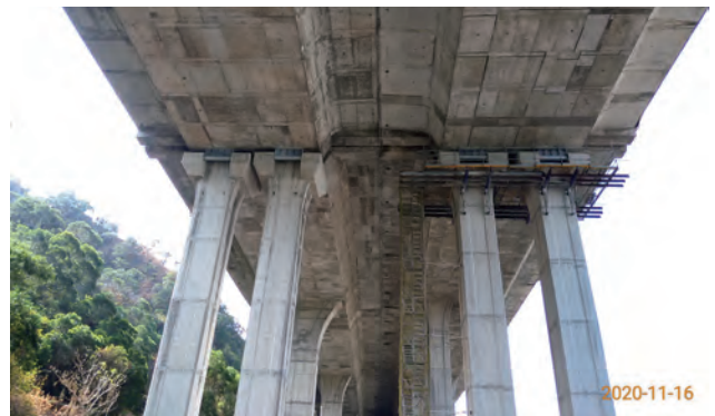
圖 3.98 第 M37F 標 國道 3 號大甲溪橋 (P63R&P61L) 上構補強施作
