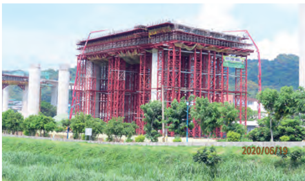
圖 3.58 第 C714 標 U4 單元 P12 ~ P13 場撐頂板 RC 澆置
