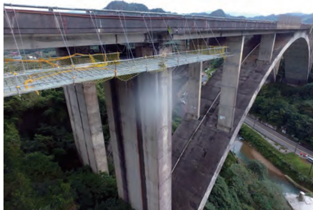
圖 3.133 第 M38D1 標 第五號橋（瑪陵橋）懸吊式施工架
