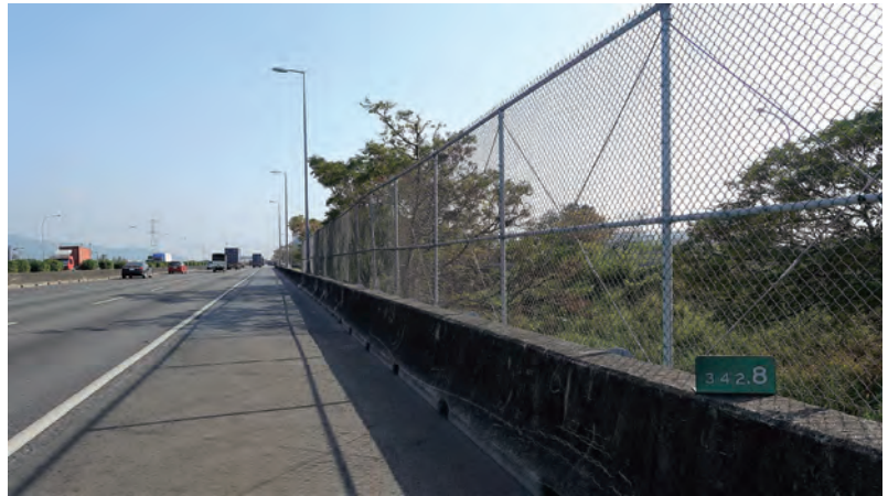
圖 4.19 生態防護網設置完成
