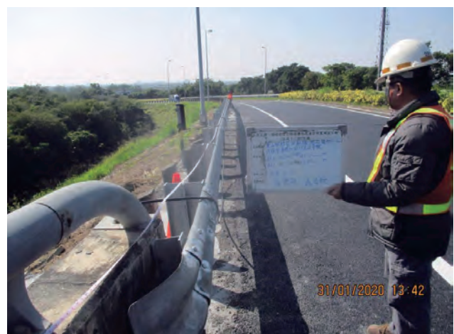
圖 3.80 第 M37B 標 東山服務區跨越橋金屬護欄復舊完成
