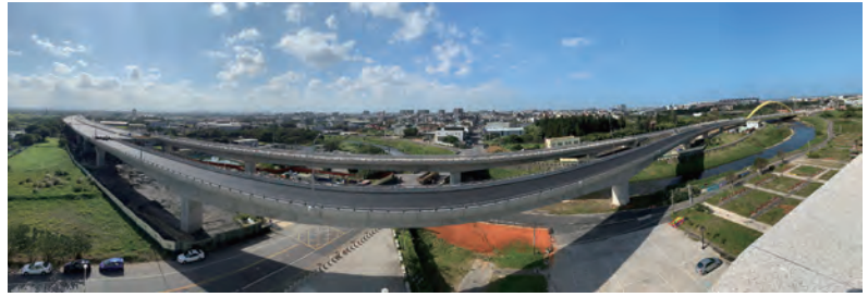
圖 3.22 第 H 72 標 跨越中華路路段懸臂工法橋梁
