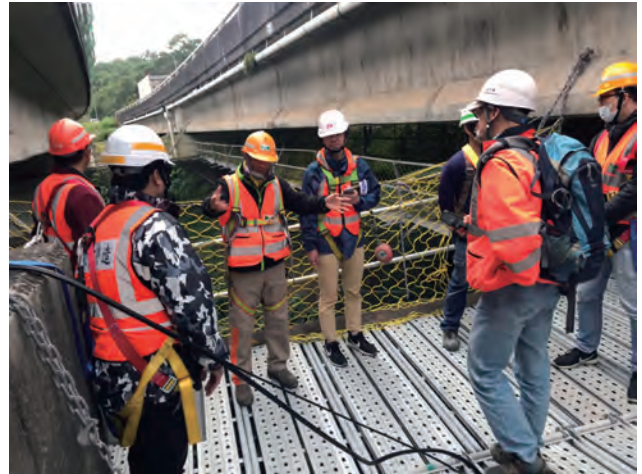
圖 3.137 第 M38D2 標 黎和里高架橋懸吊式施工架首件檢驗
