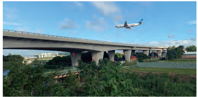
圖 3.24 第 H 72 標 主線第 3 次跨越新街溪段懸臂工法橋梁
