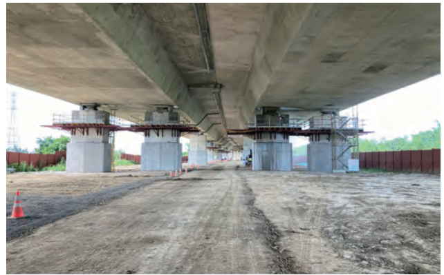
圖 3.102 第 M37G 標 施工平台搭設作業
