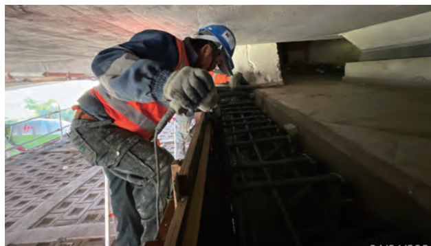
圖 3.116 第 M38A3 標 嘉南大圳北幹線一號橋橋台擴座植筋作業
