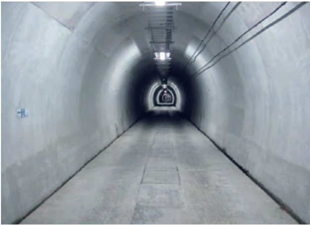
圖 4.1 國道 5 號雪山隧道導坑新設襯砌
