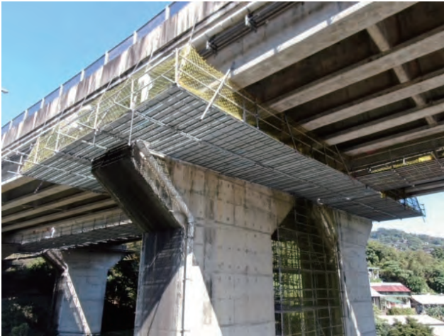
圖 3.136 第 M38D2 標 黎和里高架橋懸吊式施工架
