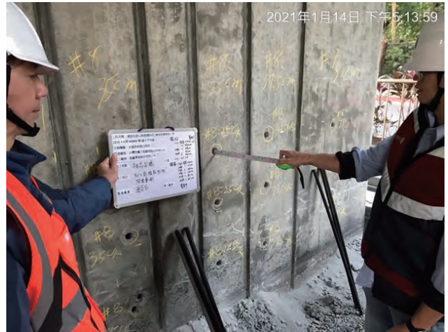
圖 3.139 第 M38D2 標 辛亥路高架橋 PW2 植筋深度查驗
