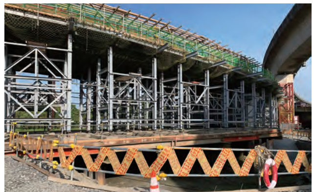
圖 3.17 改設施工構台擴大通水斷面確保支撐架底部承载力穩固
