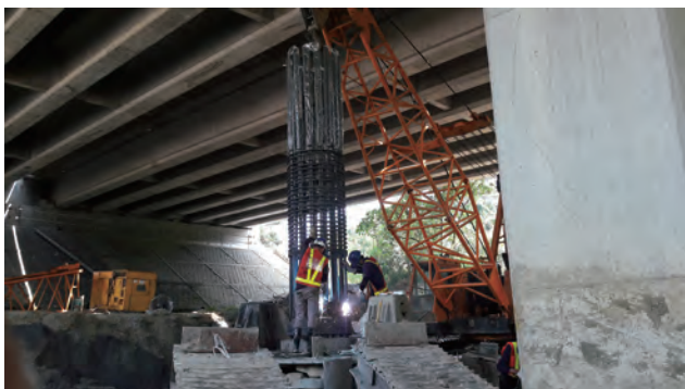
圖 3.111 第 M38A2 標 渡子頭二號橋全套管基樁施作
