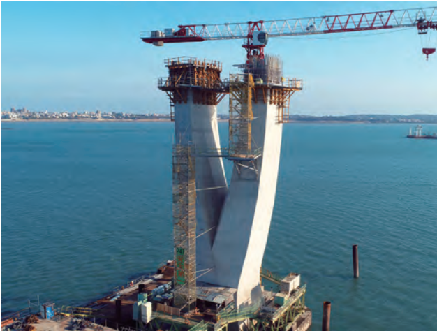
圖 3.149 第 CJ02-2C 標 主橋 P47 墩柱昇層施工
