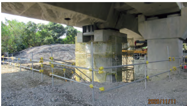
圖 3.18 國道 1 號北上往國 10 西向匝道 ( Ramp 8N ) 增設止震塊
