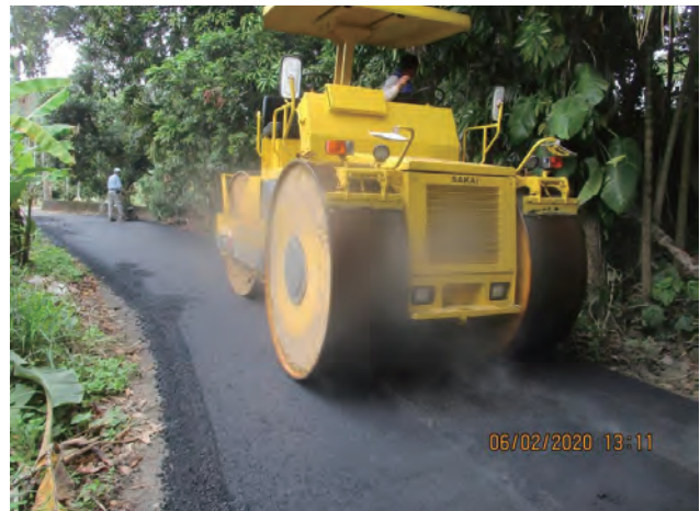
圖 3.82 第 M37B 標 仁義潭 8 號運輸道路 AC 鋪築
