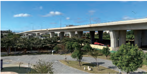
圖 3.23 第 H 72 標 主線合併段場鑄逐跨工法橋梁
