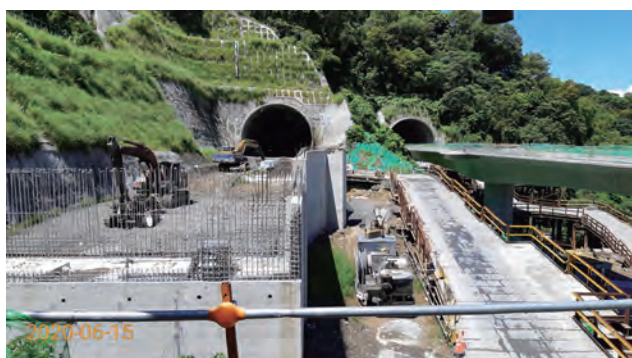
圖 3.48 第 C712 標 豐原 2 號隧道西口開挖邊坡保護及綠化
