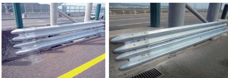
圖 6.19 護欄缺口加設金屬護欄
