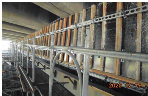
圖 3.114 第 M38A3 標 165-2 號橋增設混凝土止震塊作業
