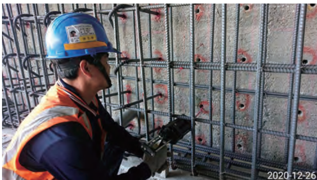
圖 3.115 第 M38A3 標 嘉南大圳北幹線一號橋橋台擴座植筋作業
