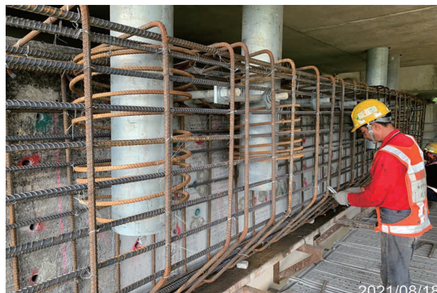
圖 2.94 第 M37D 標 名間高架橋 P2 增設剪力樺施工
