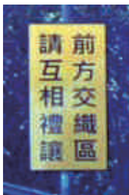
圖 5.38 服務區停車區與集散道路匯流地點設置停讓標誌成果
