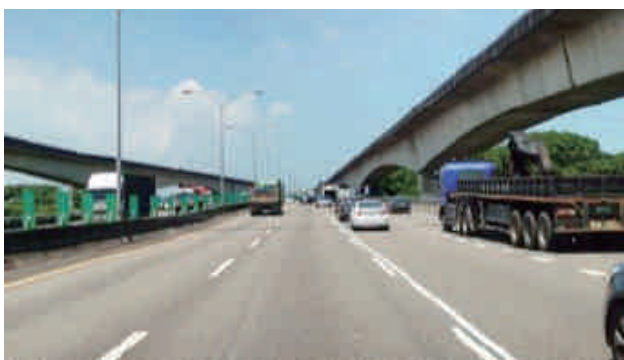
圖 5.4 國道 1 號圓山南入槽化線鼻端起劃設 10 公尺雙白實線，再接續劃設 90 公尺單邊禁止變換車道線
