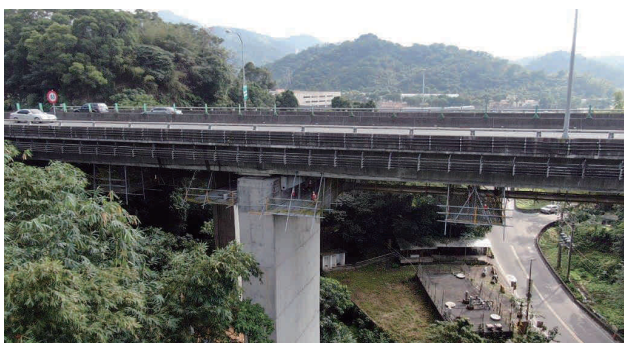
圖 2.75 第 M38D2 標 石壁坑工區懸吊施工架
