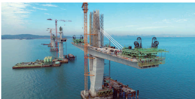
圖 2.84 第 CJ02 - 2C 標 深槽區主橋段預鑄節塊吊裝及外置預力施工
