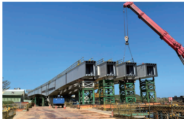
圖 2.37 第 H72 標 EBU5 鋼箱梁橋梁吊裝
