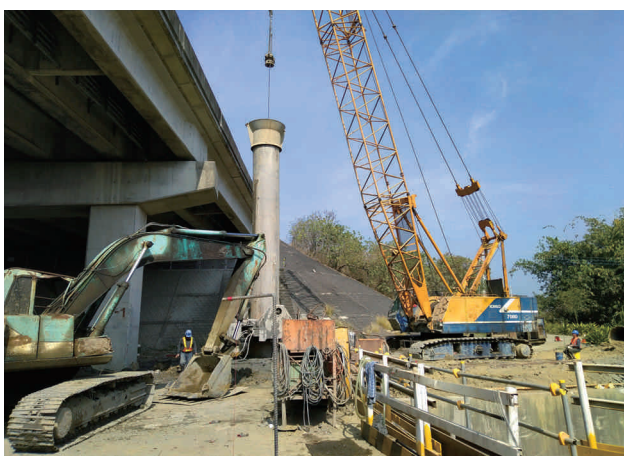
圖 2.66 第 M38A3 標 柳營二號排水橋全套管基樁施工
