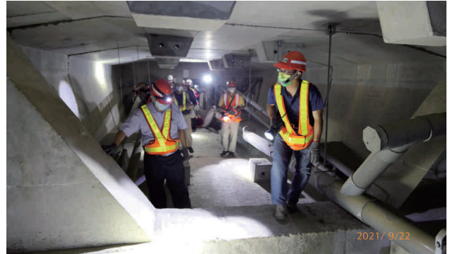
圖 3.4 橋梁檢測作業 2 - 箱型梁內部檢測
