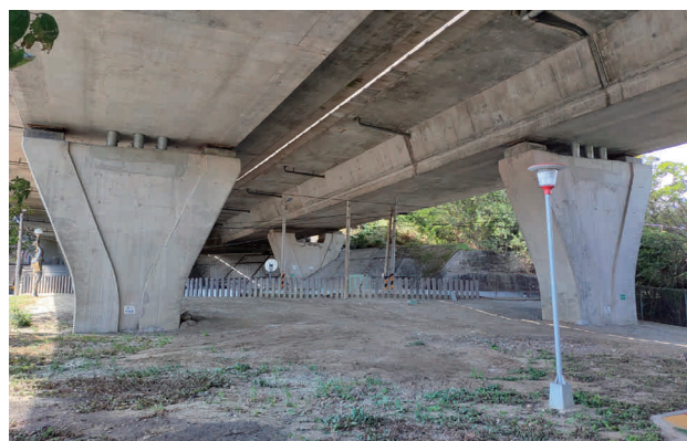
圖 2.92 第 M37F 標 國道 3 號外埔二號高架橋增設剪力樺
