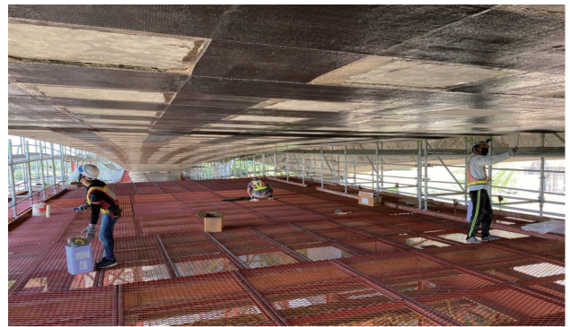
圖 2.71 第 M38C 標 烏溪一號河川橋箱梁外部 PN3 ~ PN4 CFRP 黏貼
