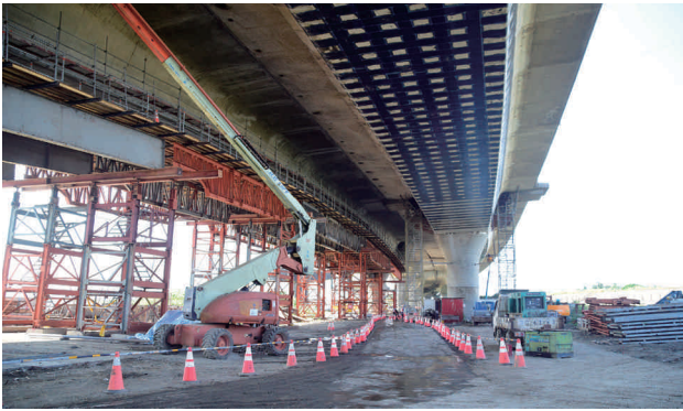
圖 2.68 第 M38B 標 烏溪一號橋上構 CFRP 貼片施工
