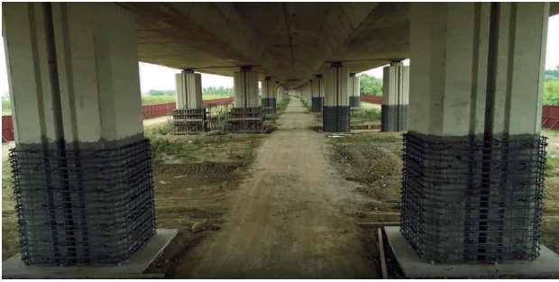
圖 2.77 第 M81 標 國道 8 號 5k + 784 ~ 10k + 294 墩柱混凝土包覆施作
