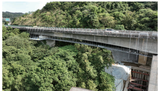
圖 2.72 第 M38D1 標 第十號橋 懸吊式施工架施作
