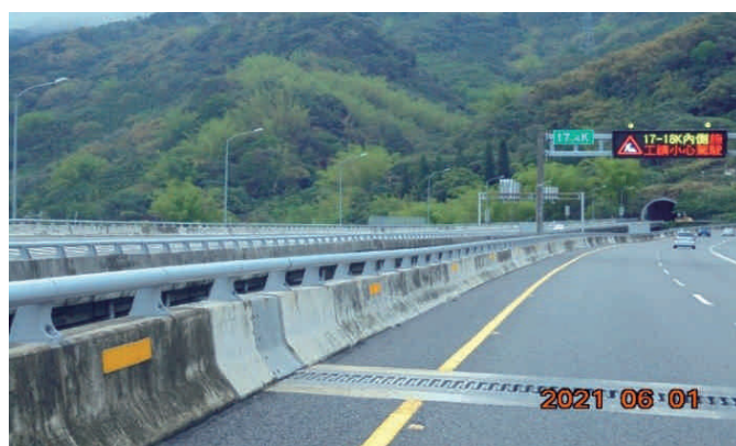
圖 5.8 國道 6 號東向國姓一號隧道，護欄反光導引板延伸
