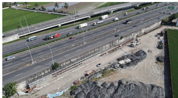
圖 2.35 第 M16 標 西螺交流道穿越橋南側新設擋土牆空拍照片
