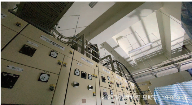
圖 2.55 第 E711 標 C713 標工區豐原 3 號隧道西口機房動力電纜布設
