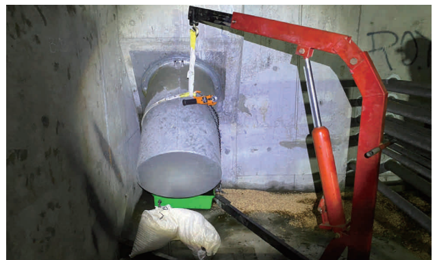
圖 3.6 開啟鋼纜錨蓋檢測
