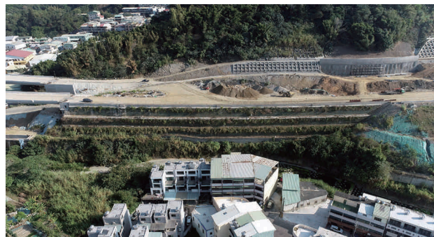
圖 2.50 第 C713 標 路堤路塹段加勁及邊坡擋土牆空拍
