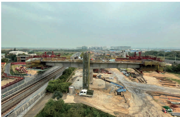
圖 2.36 第 H72 標 第二工區 WBP2 場鑄逐跨工法橋梁
