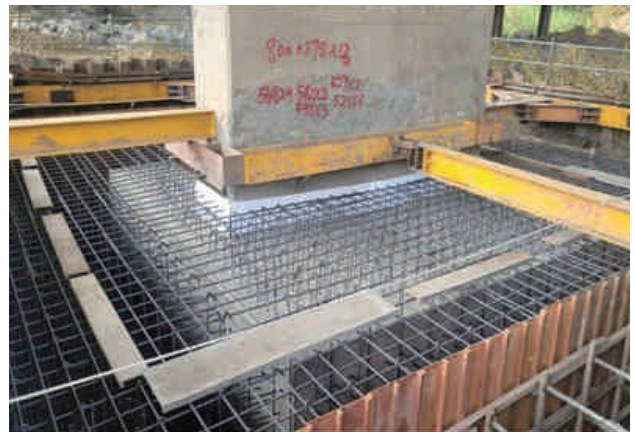
圖 2.63 第 M38A1 標 白水溪河川橋 P13 墩柱基礎補強施工
