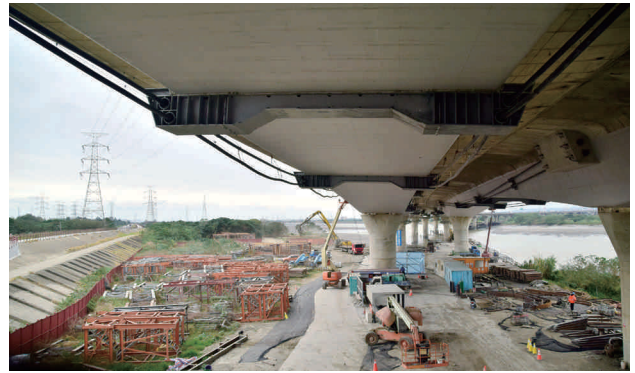
圖 2.69 第 M38B 標 烏溪一號橋上構新增外置預力施工
