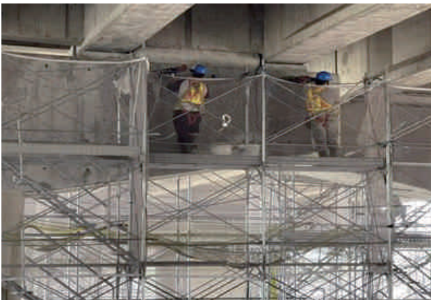
圖 2.62 第 M38A1 標 赤蘭溪河川橋 P3 墩柱帽梁對穿鋼筋洗孔作業
