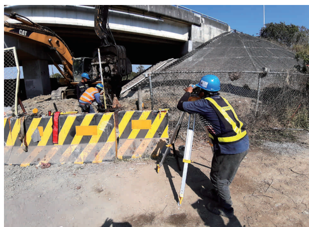
圖 2.67 第 M38A3 標 165 縣道二號穿越橋鋼管樁試驗樁施作
