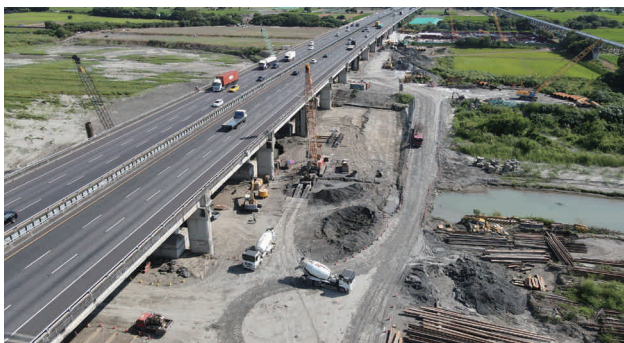
圖 2.34 第 M16 標 中沙大橋深槽區 P43R 基礎施工空拍照片
