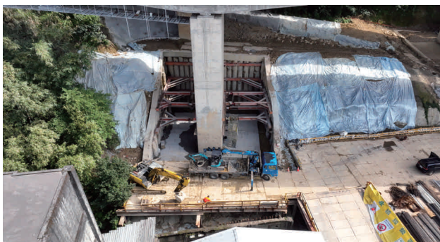
圖 2.73 第 M38D1 標 第十號橋 PS10C - 2 ( 汐萬路工區 ) 下構補強
