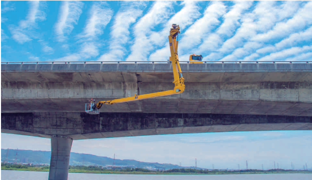
圖 3.3 橋梁檢測作業 1 - 橋檢車檢測
