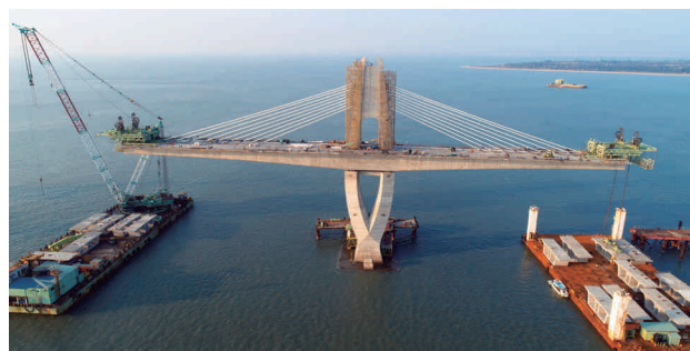
圖 2.85 第 CJ02 - C 標 金門大橋主橋段預鑄節塊吊裝及外置預力施工
