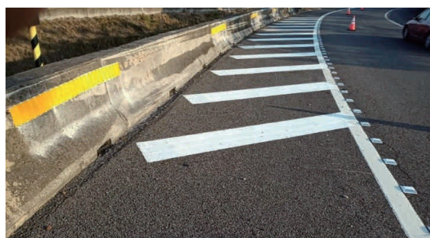
圖 5.7 國道 4 號東向台中系統出口，匝道路肩彎道增設路肩槽化線
