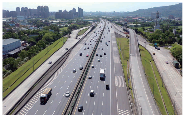
圖 3.12 關西段樹林收費站路段剛性路面加鋪成果
