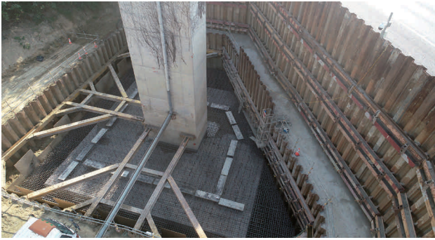
圖 2.60 第 M37G 標 新化系統 P8 基礎補強施工
