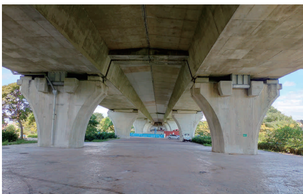
圖 2.91 第 M37F 標 國道 3 號大安溪橋增設鋼板止震裝置
