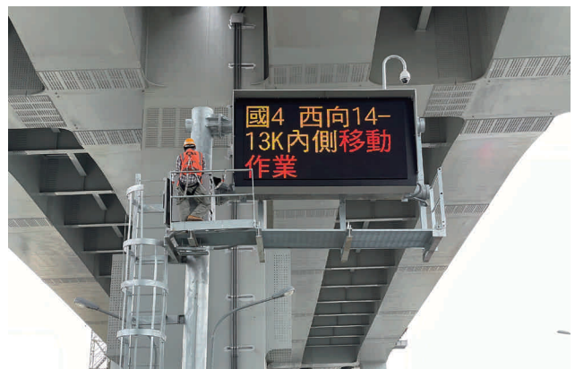
圖 2.57 第 F711 標 國豐路 CMS 顯示面板及功能調整
