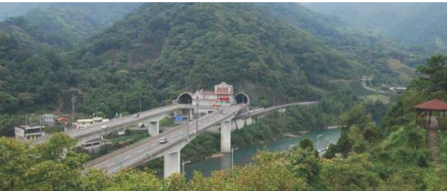
(上) 國道 5 號坪林路段採橋梁的設計縮小擾動規模。 (下) 國道 5 號雪山隧道直接以橋梁銜接隧道口，縮小擾動規模。
