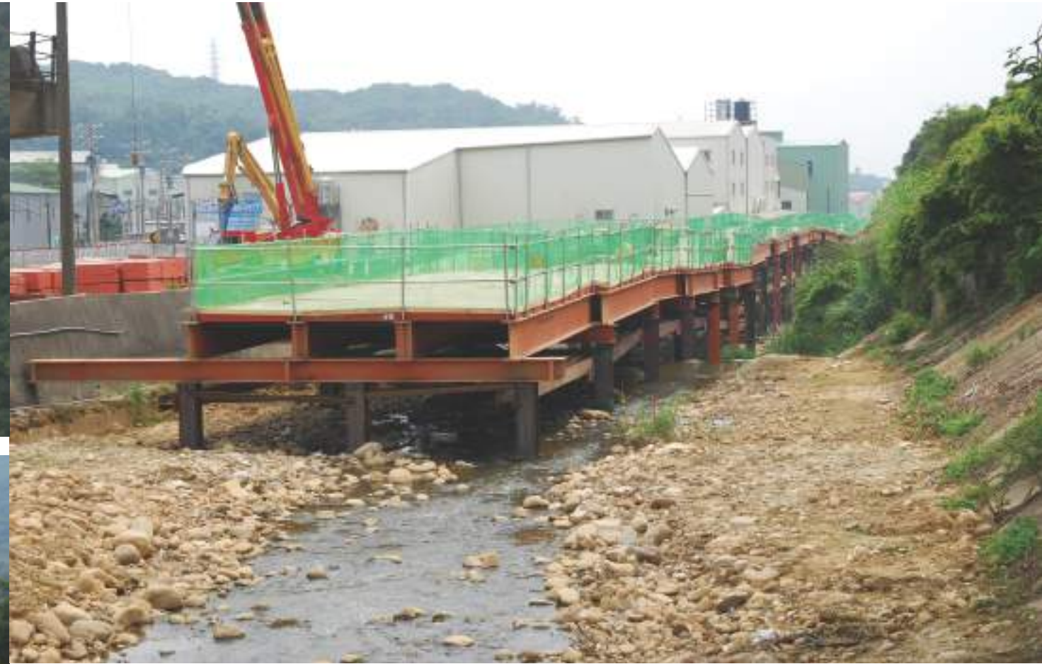
國道 1 號五股楊梅拓寬工程設置施工棧橋盡可能減少環境擾動。
