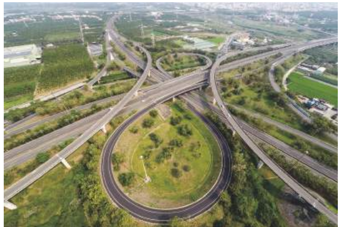
(上) 高架橋下的綠地空間。 (下) 交流道的綠地空間。
