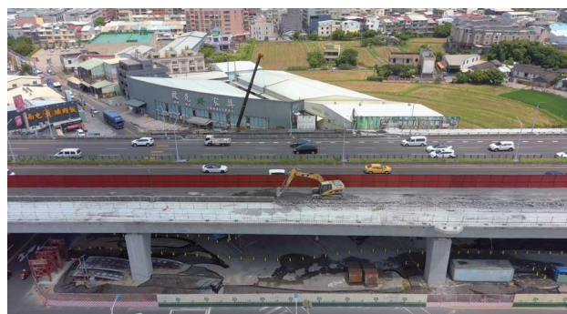
圖 2.30 第 186 標 台 74 線匝道銜接既有護欄拆除施工
