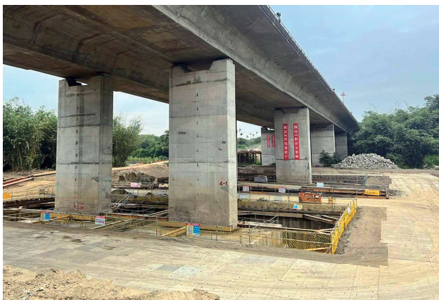
圖 2.65 第 M38A1 標 六重溪河川橋 P4 基礎施工
