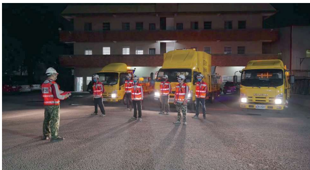
圖 3.13 國道路面整修工程夜間施工
