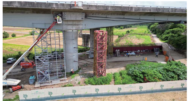
圖 2.79 第 M38C 標 烏溪一號橋外置預力施拉作業
