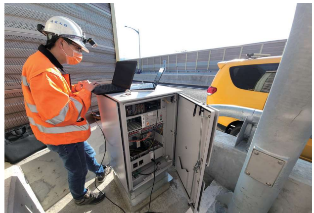
圖 2.54 第 F711 標 環路線圈式車輛偵測器車輛逆行偵測驗證
