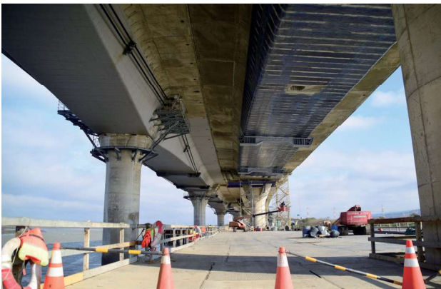
圖 2.74 第 M38B 標 烏溪一號橋 PS17 ~ PS18 橋墩之預力箱梁鋼製轉向座吊裝
