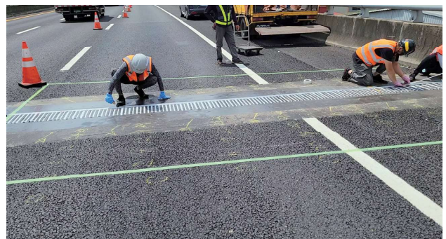
圖 3.14 伸縮縫整平改善施工
