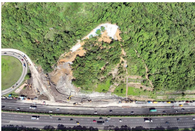
圖 3.31 國道 1 號南下 10.1k 邊坡坍滑
