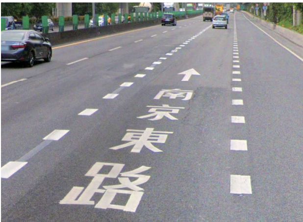
圖 5.4 國道 1 號南向汐止端 - 內湖 A 第 2、3 車道間設穿越虛線，第 3 車道每 300 公尺繪設「直行箭頭南京東路」
