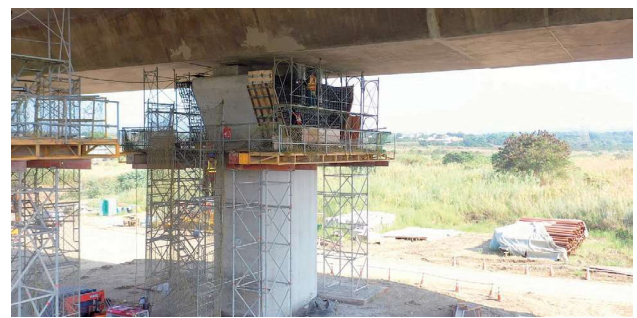
圖 2.72 第 M38A2 標 官田系統 - 官田三號橋 P6 基礎補強施工
