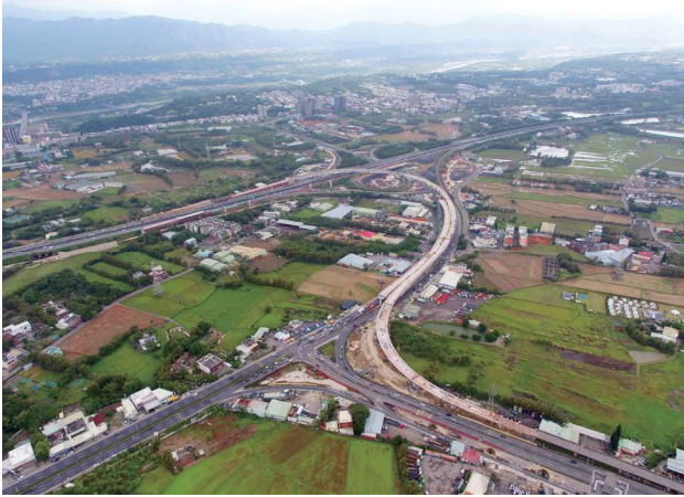
圖 2.43 第 336 標 施工全景圖
