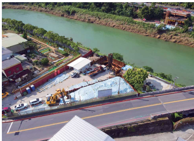
圖 2.23 第 I101S 標 P2 橋墩施工
