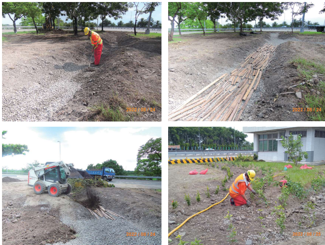
圖 3.20 竹田地磅設置灌溉型雨水花園 ( 上 ) 鋪設碎石底層 ( 左圖 ) ，鋪設廢竹材滲透層 ( 右圖 ) ( 下 ) 原生土壤回填 ( 左圖 ) ，種植在地植物 ( 右圖 )
