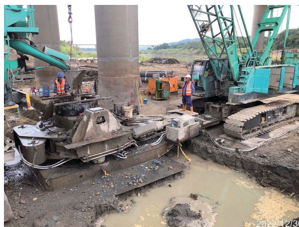
圖 2.98 第 M38G 標 23k + 847 旗山溪橋 P26 基礎全套管基樁 150cmΦ 水中混凝土澆置
