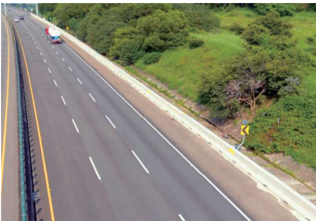
圖 5.6 國道 3 號北上大山 - 竹南路段 鋼板護欄改為 RC 護欄、增加 LED 輔 2 標誌及外側護欄增加反光浪板、導標
