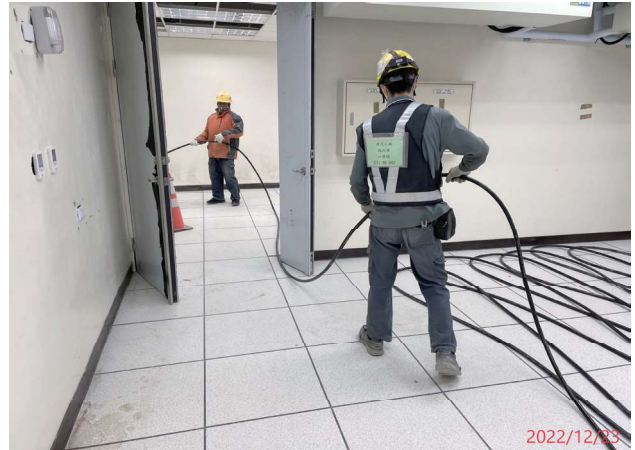
圖 2.52 第 E711 標 C712 標工區豐原 1 號隧道機房監控佈纜
