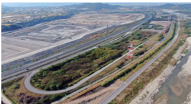
圖 2.55 第 E601A 標 國道 6 號東草屯休息站新建工程暨附屬設施配合工程
