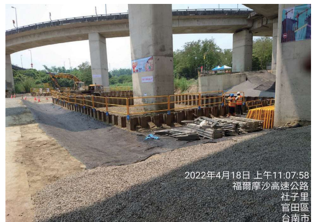
圖 2.70 第 M38A2 標 官田系統 - 官田三號橋 P6 基礎補強施工
