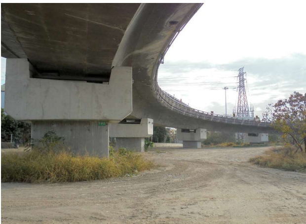
圖 2.80 第 M38C 標 第一工區臺中系統交流道上部耐震補強
