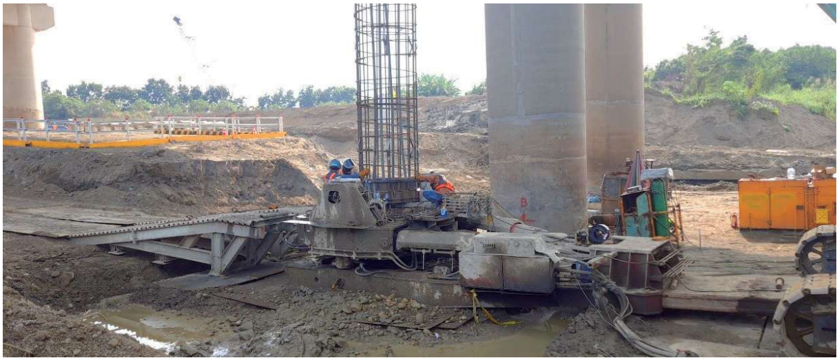
圖 2.99 第 M38G 標 23k + 847 旗山溪橋 P26 基礎全套管基樁 150cm \Phi 鋼筋籠吊放
