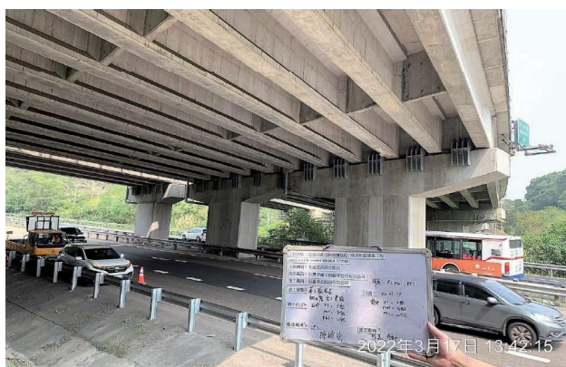
圖 2.126 第 M38D2 標 第 2 聯絡道橋 鋼止震竣工查驗
