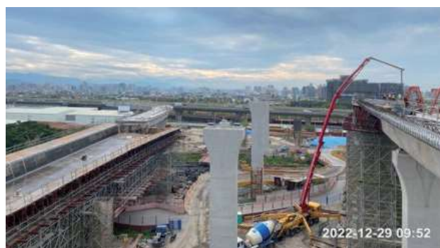
圖 2.32 第 186 標 系統匝道混凝土澆置施工
