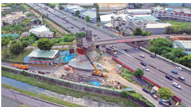
圖 2.31 第 186 標 國道 1 號跨越橋塔柱施工
