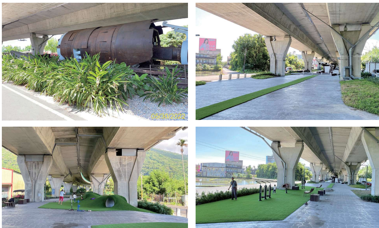
圖 3.21 國道 5 號公共藝術計畫周邊景觀改善工程 ( 上半部圖 )：灌木植栽選種綠化 ( 下半部圖 )：設置體健設施及遊憩空間供民眾使用
