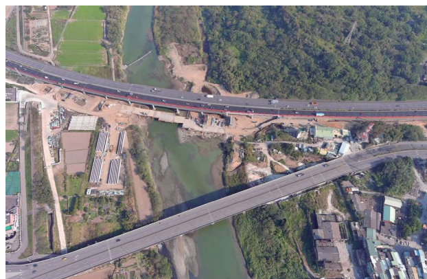
圖 2.28 第 B102S 標 整體施工
