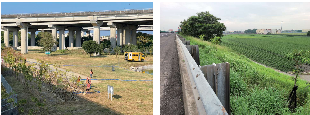
圖 3.22 斗南工務段綠美化成果 國道 1 號雲林系統苗圃以抽水設備抽取蓄水池的水澆灌苗木。( 左圖 ) 國道 1 號雲林系統苗圃所育大花紫薇移植至主線 ( 南下 237k + 100 ) 補植。( 右圖 )
