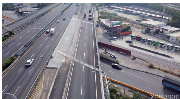
圖 2.108 第 M16 標 西螺工區施工現況
