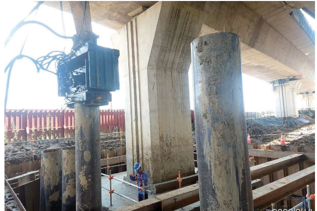
圖 2.89 第 M81 標 鋼管樁施工
