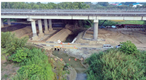
圖 2.69 第 M38A2 標 潭頂溪 P2 基礎補強施工
