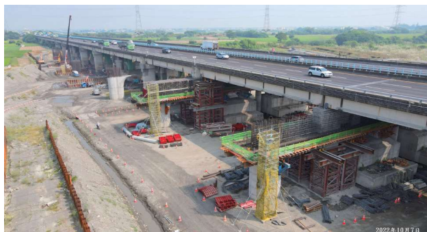
圖 2.103 第 M16 標 中沙大橋 P11 ~ P17 施工現況
