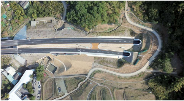
圖 2.47 第 C712 標 豐原 1 號隧道西口
