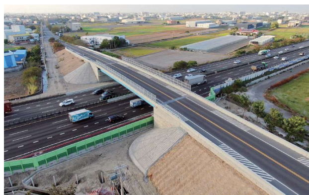
圖 2.34 第 B101S 標國道 1 號 201k + 715 花秀路跨越橋通車空拍照片
