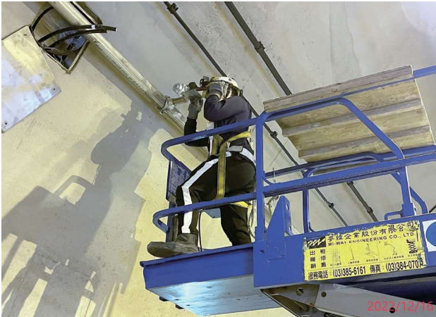
圖 2.51 第 E711 標 C712 標工區豐原 1 號隧道水霧噴頭安裝
