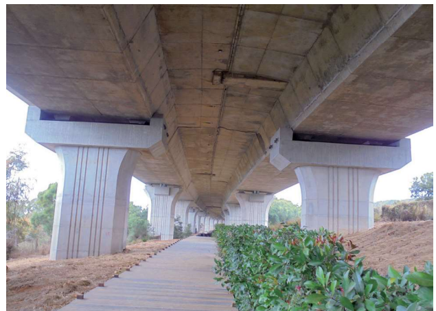
圖 2.81 第 M38C 標 第二工區沙鹿高架橋上部耐震補強
