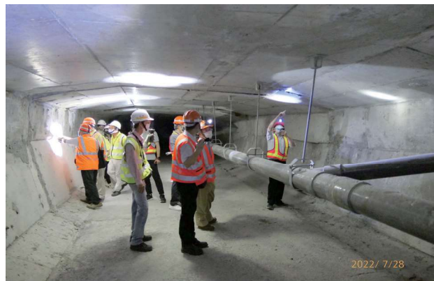
圖 3.4 橋梁檢測作業 2 - 箱型梁內部檢測
