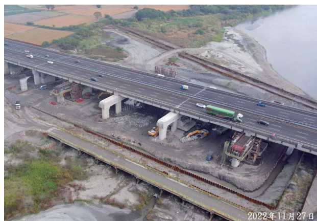
圖 2.106 第 M16 標 中沙大橋 P11 ~ P18 施工現況
