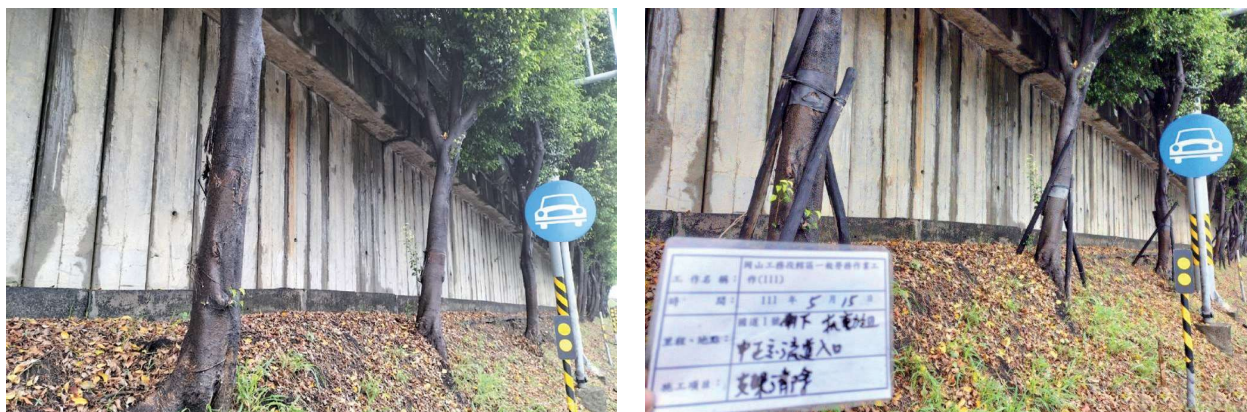
圖 3.29 國道 1 號高雄交流道喬木支架移除改善前及改善後對照
