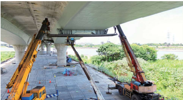
圖 2.78 第 M38C 標 烏溪一號橋外置預力轉向座吊裝施工
