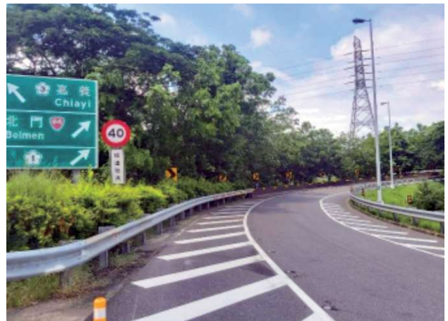
圖 5.9 國道 3 號北向官田系統出口環道（往台 84 西向出口）匝道路肩彎道增設路肩槽化線及加密反光標記
