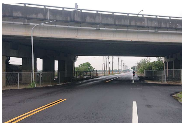
圖 2.122 第 M38A3 標 165 縣道二號穿越橋道路
