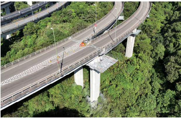
圖 2.82 第 M38D1 標 瑪東系統交流道匝道懸吊式施工架施工
