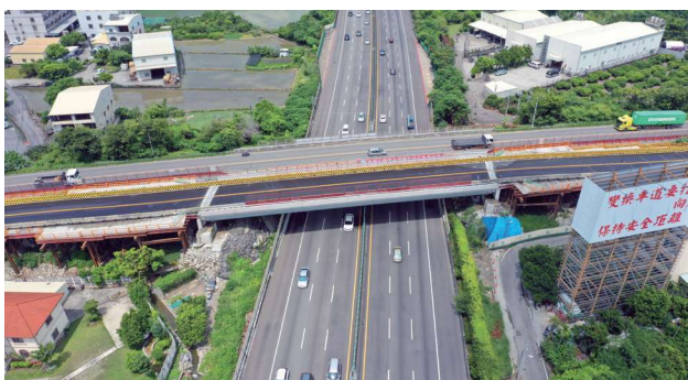
圖 2.29 第 186 標 昌平路跨越橋便橋
