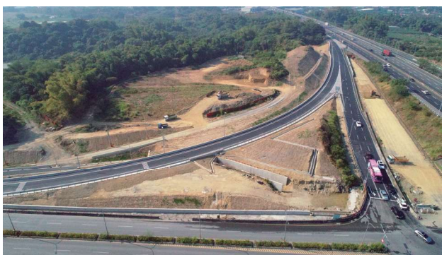
圖 2.57 第 L11 標 工區 R1、R3 匝道
