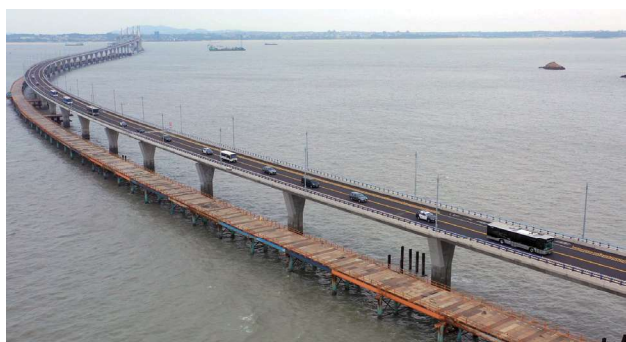
圖 2.113 第 CJ02 - 2C 標 巡禮車隊通過小金端引橋
