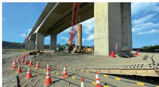
圖 2.97 第 M38F3 標 高屏溪河川橋 P7R - 4 全套管基樁鑽掘
