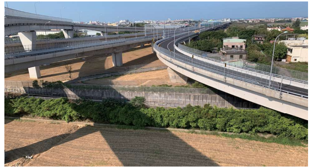
圖 2.36 第 H72 標 跨越機場捷運 ALU1 出機場匝道
