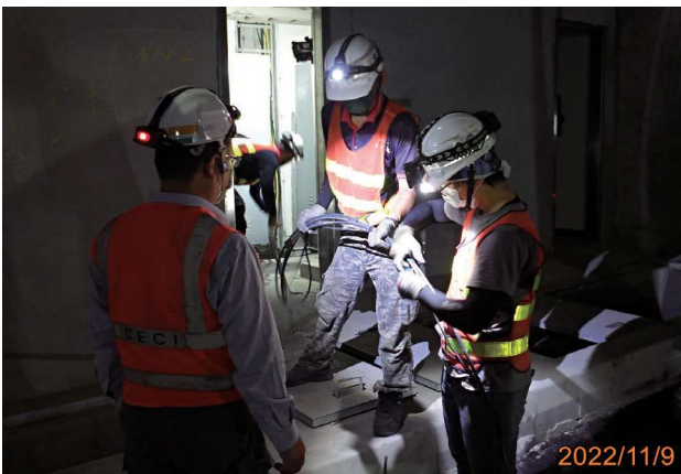
圖 2.53 第 F711 標 豐原 1 號隧道西行線交控凹槽纜線布放
