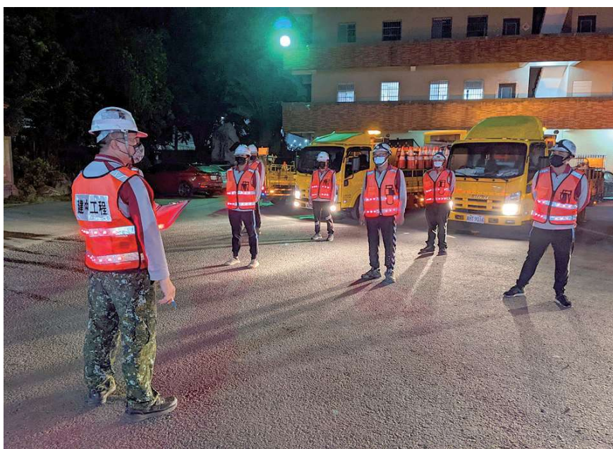
圖 3.18 施工人員穿著 LED 警示反光背心
