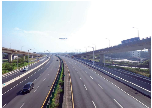
圖 2.42 第 282 標 工程拓寬完成全景照片
