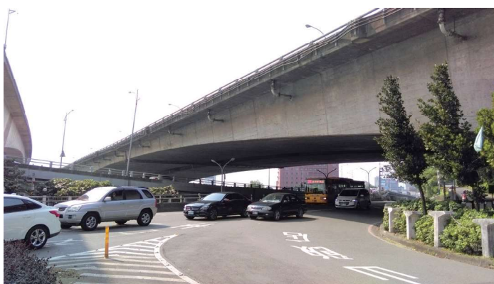
圖 2.2 國道 1 號圓山橋南下線北安路橋跨
