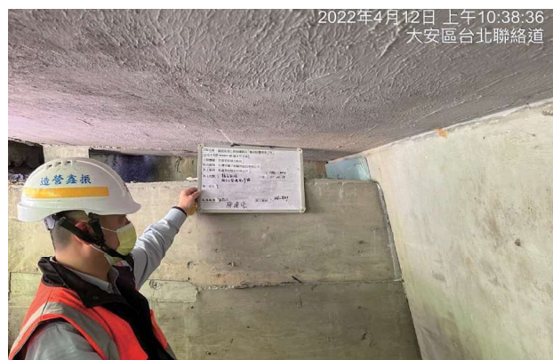
圖 2.127 第 M38D2 標 辛亥路橋 橋台止震塊竣工查驗
