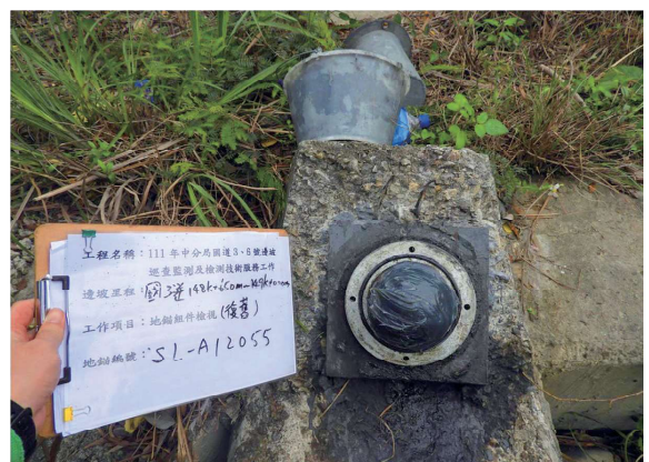
圖 3.7 錨頭防銹脂填充現場照片
