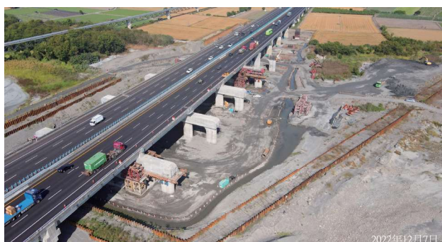
圖 2.107 第 M16 標 中沙大橋 P11 ~ P18 施工現況
