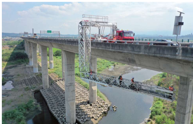
圖 3.3 橋梁檢測作業 1 - 橋檢車檢測
