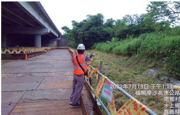
圖 2.67 第 M38A1 標 南鄉排水橋臨時構台設施
