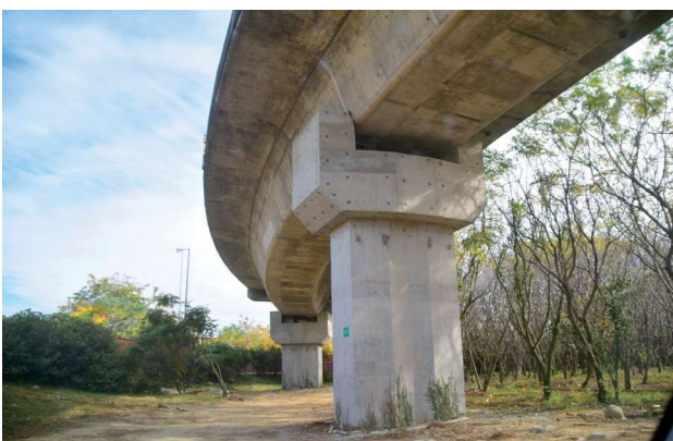
圖 2.76 第 M38B 標 快官交流道匝道四號高架橋 P404 橋墩之混凝土止震塊
