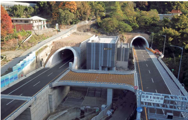
圖 2.49 第 C712 標 豐原 1 號隧道西口
