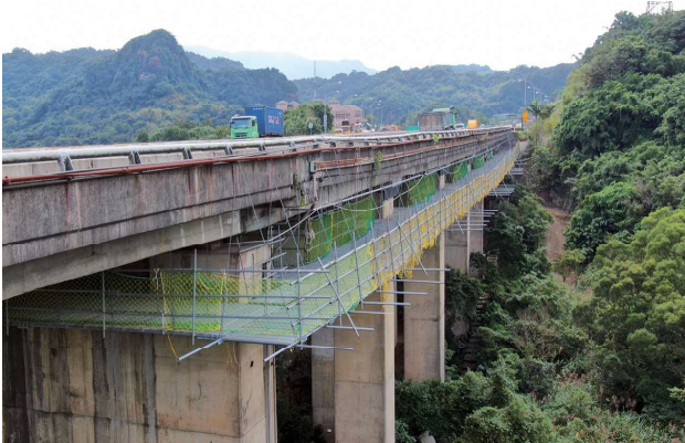
圖 2.84 第 M38D1 標 第五號高架橋南下線南段懸吊架施工
