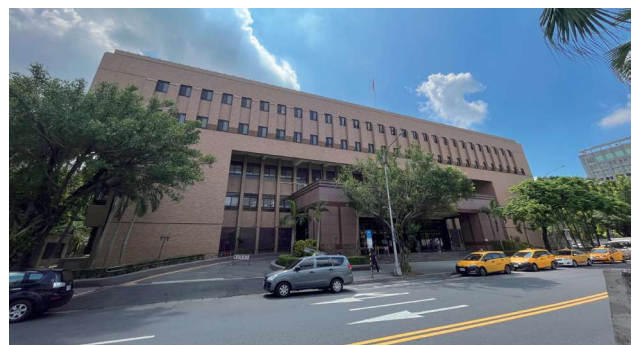
圖 2.141 司法新廈外牆更新改善接續工程 法務部大門外牆更新
