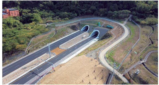
圖 2.48 第 C712 標 豐原 1 號隧道西口
