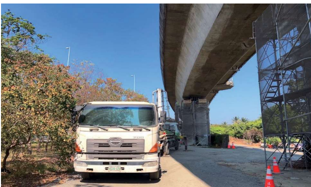
圖 2.92 第 M38FZ 標 國道 10 號鼎金系統匝道 - P6 鋼止震裝置施作
