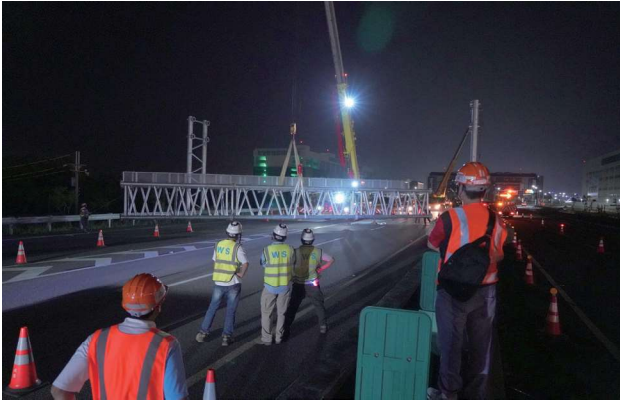
圖 2.39 第 282 標 門架吊裝施工照片
