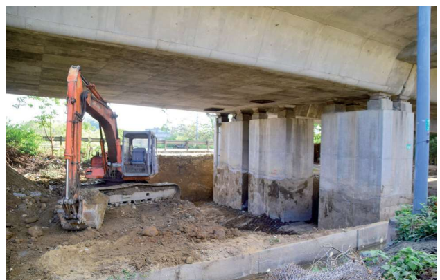
圖 2.77 第 M38B 標 快官交流道匝道一(二)高架橋 P132 橋墩進行基礎補強
