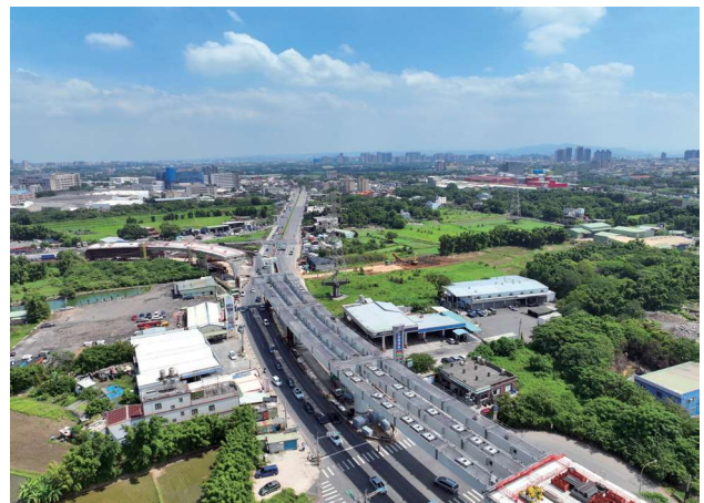
圖 2.46 第 336 標 SL1 鋼梁吊裝完成
