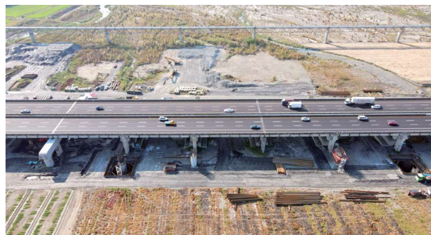
圖 2.104 第 M16 標 中沙大橋 P33 ~ P38 施工現況
