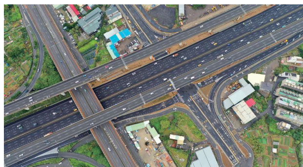
圖 2.118 第 164 標 匝道俯瞰空拍照片
