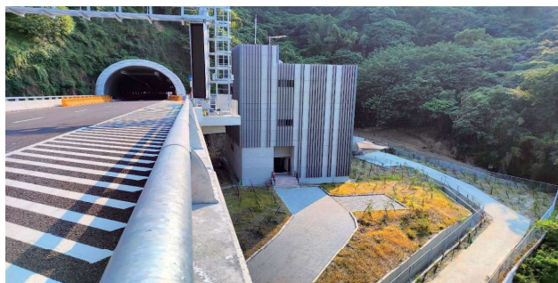
圖 2.134 第 C713 標豐原 3 號隧道西口機房
