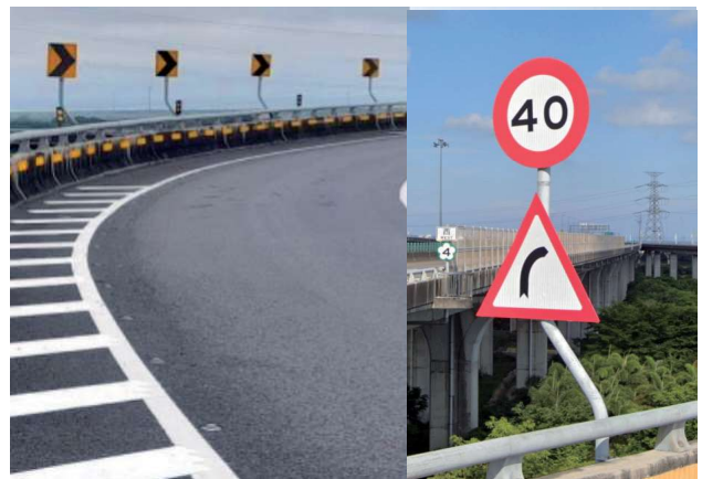
圖 5.7 國道 4 號西向中港系統出口匝道前速限牌面附牌改為「警 1」、增設白斜紋線及反光標記加密
