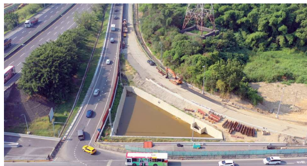
圖 2.60 第 L11 標 L4 匝道及 DS3 滯洪沉沙池
