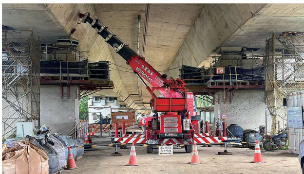
圖 2.61 第 M37G 標 烏山頭高架橋橋墩鉛心支承施工
