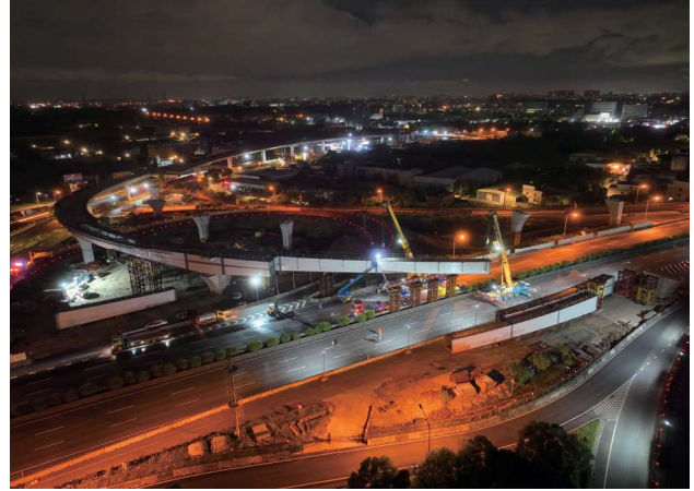
圖 2.44 第 336 標 SL1 匝道跨越國道 3 號夜間鋼梁吊裝施工
