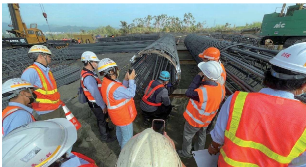
圖 2.94 第 M38F3 標 高屏溪河川橋 P7L - 1 全套管基樁首件檢驗
