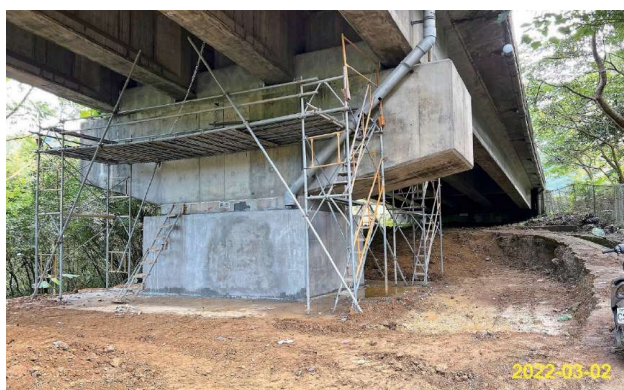
圖 2.124 第 M38D2 標 坡內坑橋 匝道 7 墩柱 P8 混凝土修飾
