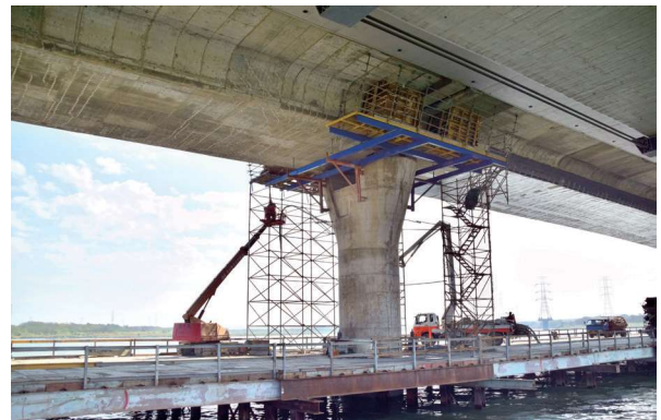
圖 2.73 第 M38B 標 烏溪一號橋 PN17 橋墩之預力箱梁新設外置預力錨碇塊施工
