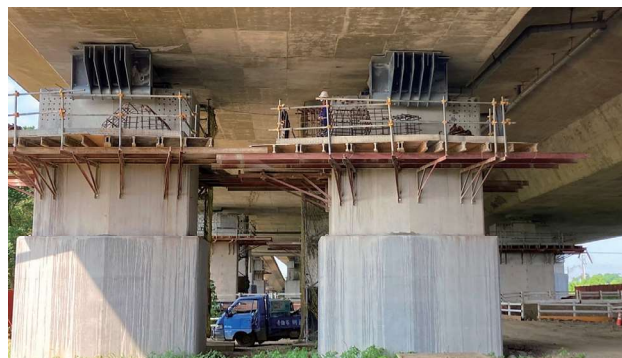
圖 2.62 第 M37G 標 烏山頭高架橋鋼止震及 RC 擋塊施工
