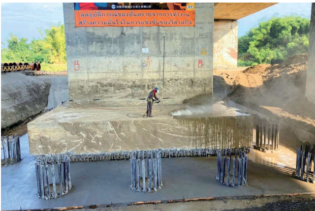
圖 2.90 第 M38FZ 標 國道 3 號 369k + 879_ 基礎水刀掃描
