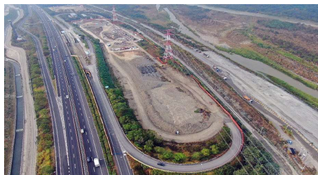
圖 2.56 第 E601A 標 國道 6 號東草屯休息站新建工程暨附屬設施配合工程
