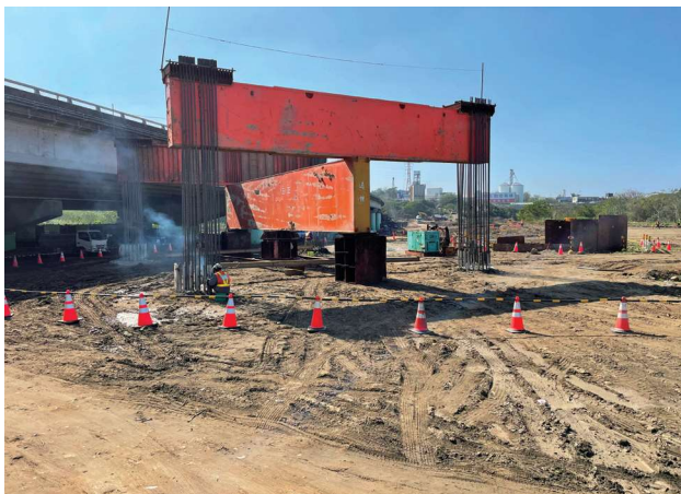
圖 2.25 第 B102S 標 P2W 基樁載重試驗錨定鋼筋鉗接施工
