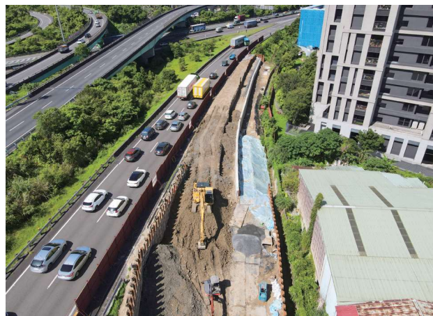
圖 2.24 第 I101S 標 匝道擋土牆施工
