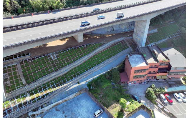
圖 2.85 第 M38D1 標 第十號高架橋汐萬路工區水土保持施工
