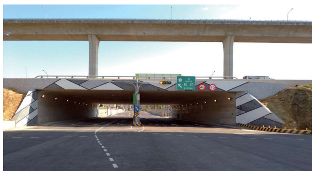
圖 2.117 第 164 標 蘆興南路箱涵完成照片
