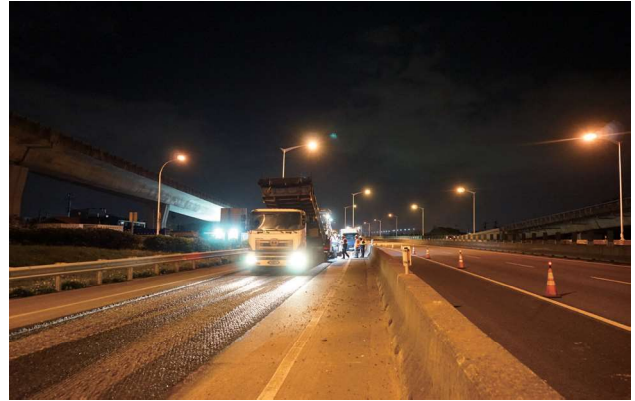
圖 2.40 第 282 標 L3 匝道 0 + 000 - 157 DGAC 路面鋪築施工照片
