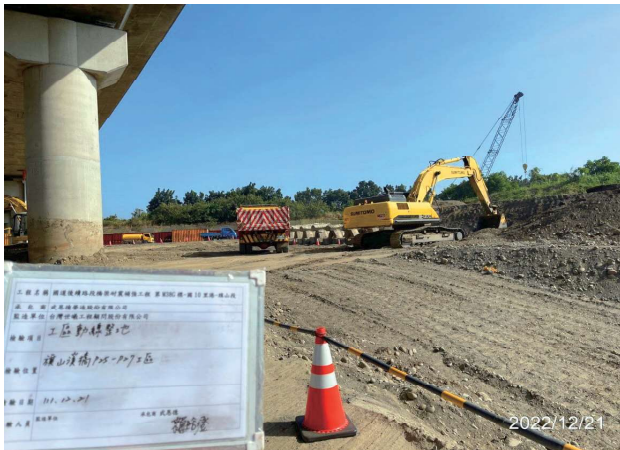
圖 2.100 第 M38G 標 23k + 847 旗山溪橋東岸便道動線整地施作
