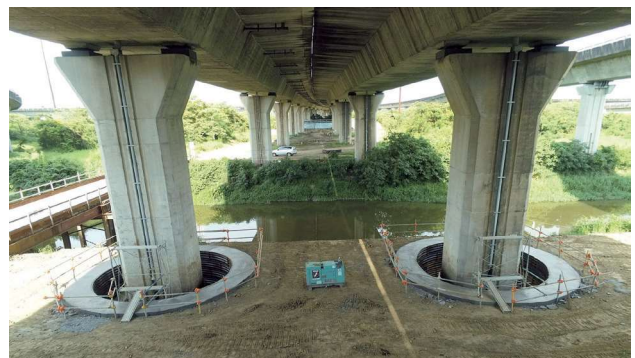
圖 2.87 第 M81 標 國 8 (5 ~ 10k) P18 墩柱基礎施工
