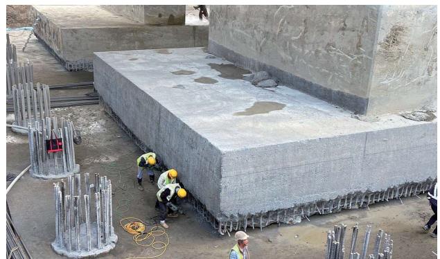
圖 2.93 第 M38FZ 標 國道 3 號二仁溪 P10 基礎角隅打除
