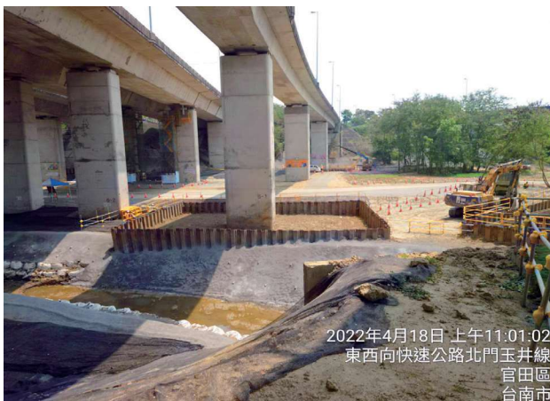
圖 2.71 第 M38A2 標 潭頂溪 P2 基礎補強施工
