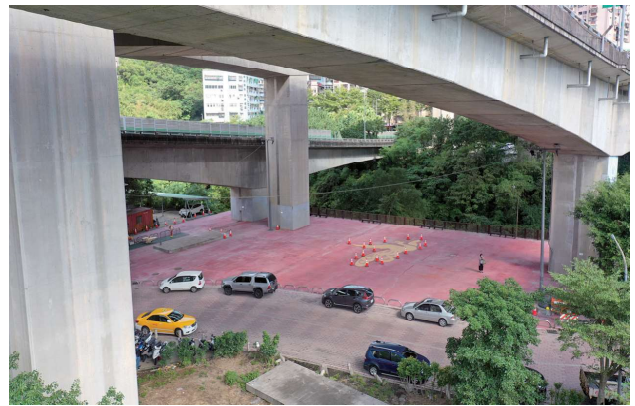
圖 2.83 第 M38D1 標 基金交流道一號高架橋 PR1 - 6 墩柱基礎補強完成及防災廣場復舊
