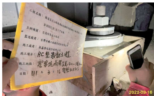
圖 2.125 第 M38D2 標 密婆坑橋 防落裝置 RC 承座澆置
