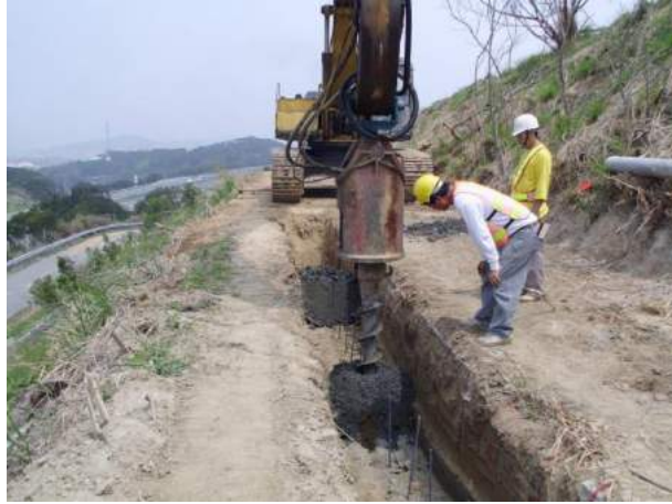
圖 3.3.3-5 微型樁工法
