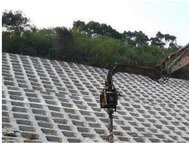
圖 3.3.3-6 型框護坡工法
