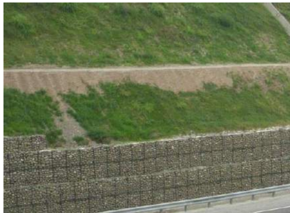
圖 3.3.3-1 箱籠擋土牆工法
