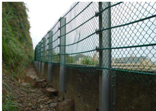
圖 3.3.3-12 攔石柵（網）工法
