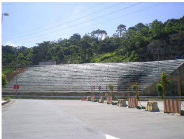
圖 3.3.3-2 加勁擋土牆工法
