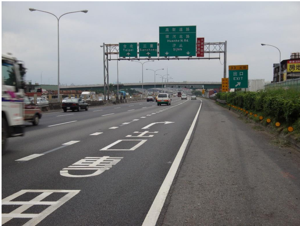
圖 3.2-9 國 1 北上五股至五股轉接道設置出口專用車道範例
