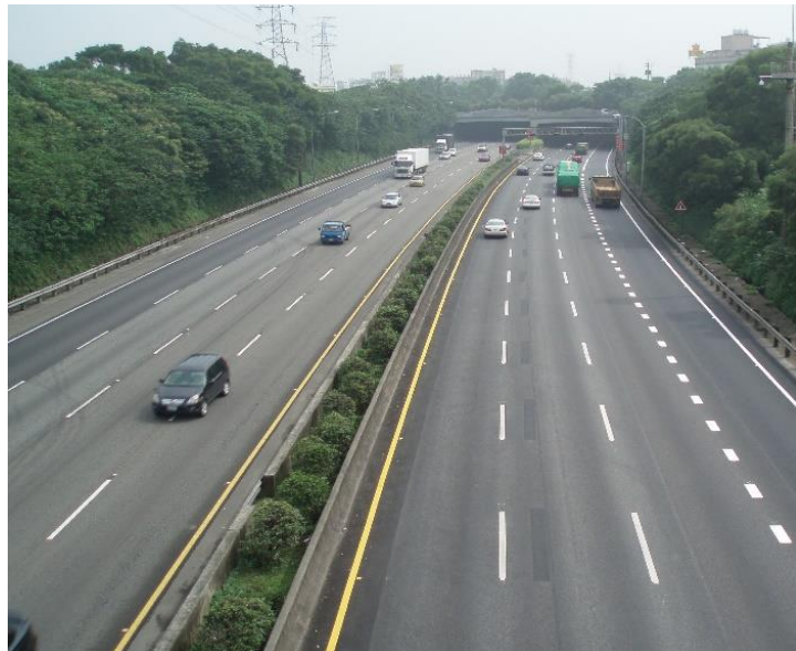
圖 3.2-4 國道 3 號大溪至埔頂隧道出口北上路段闢設輔助車道
