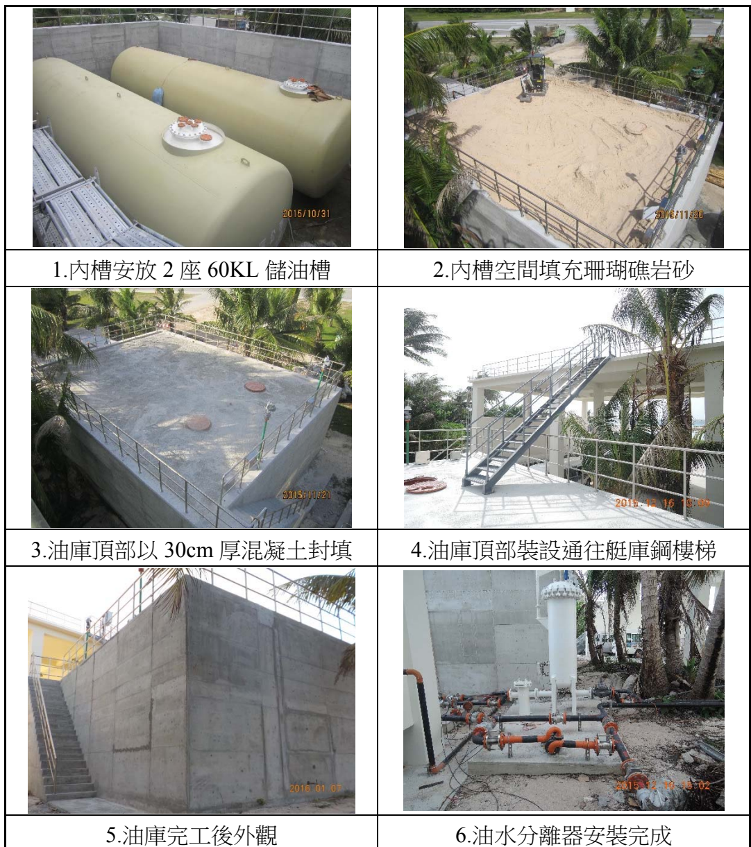
圖 1-118 碼頭區油庫工程施工照片
