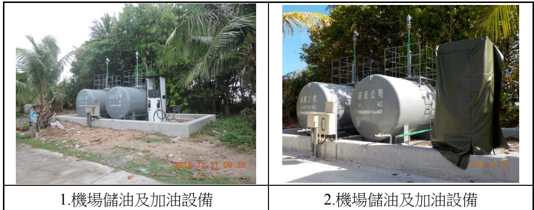
圖 1-110 機場儲油及加油設備工程施工照片
