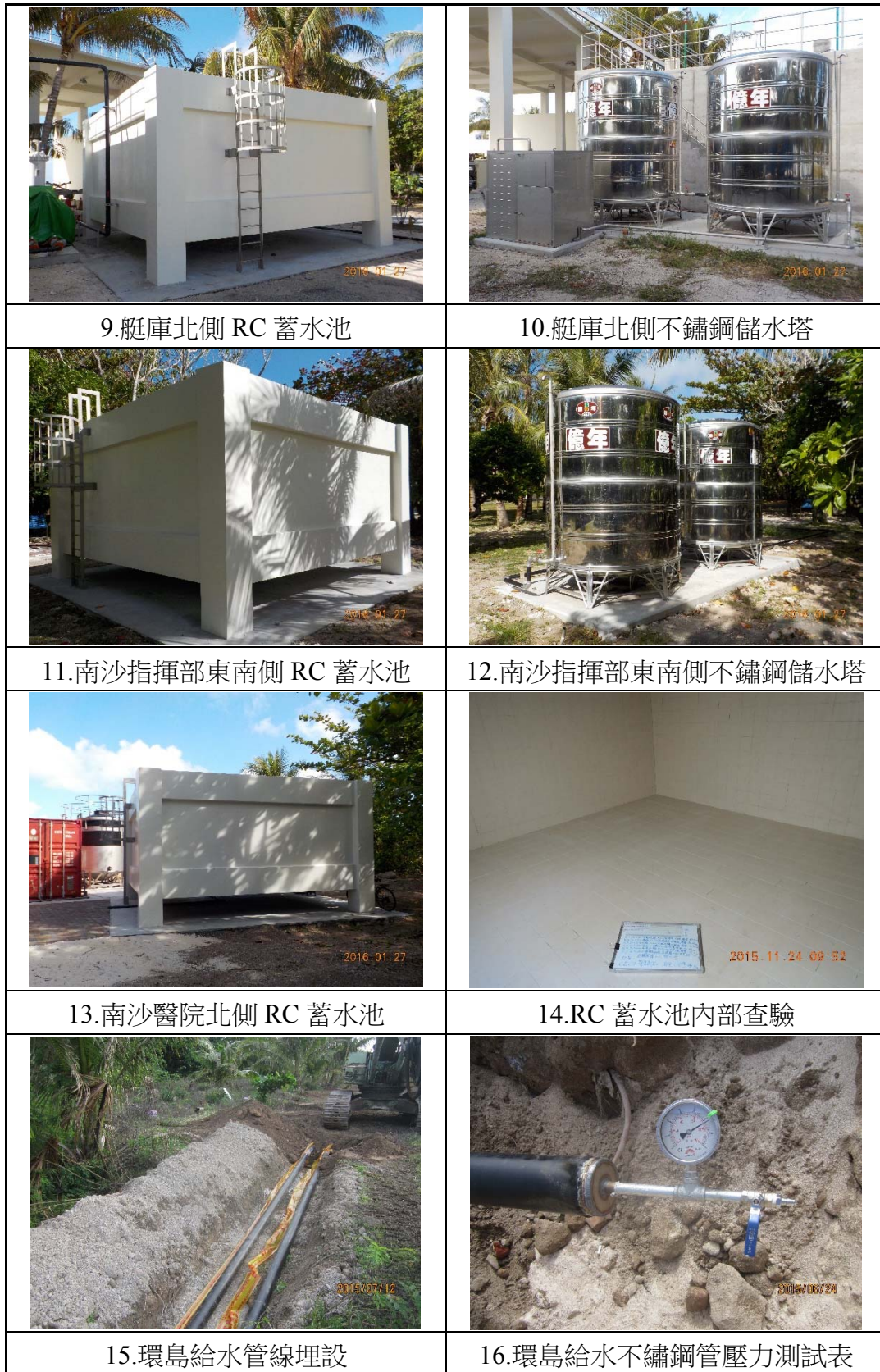
圖 1-123 環島給水系統工程施工照片(2/2)
