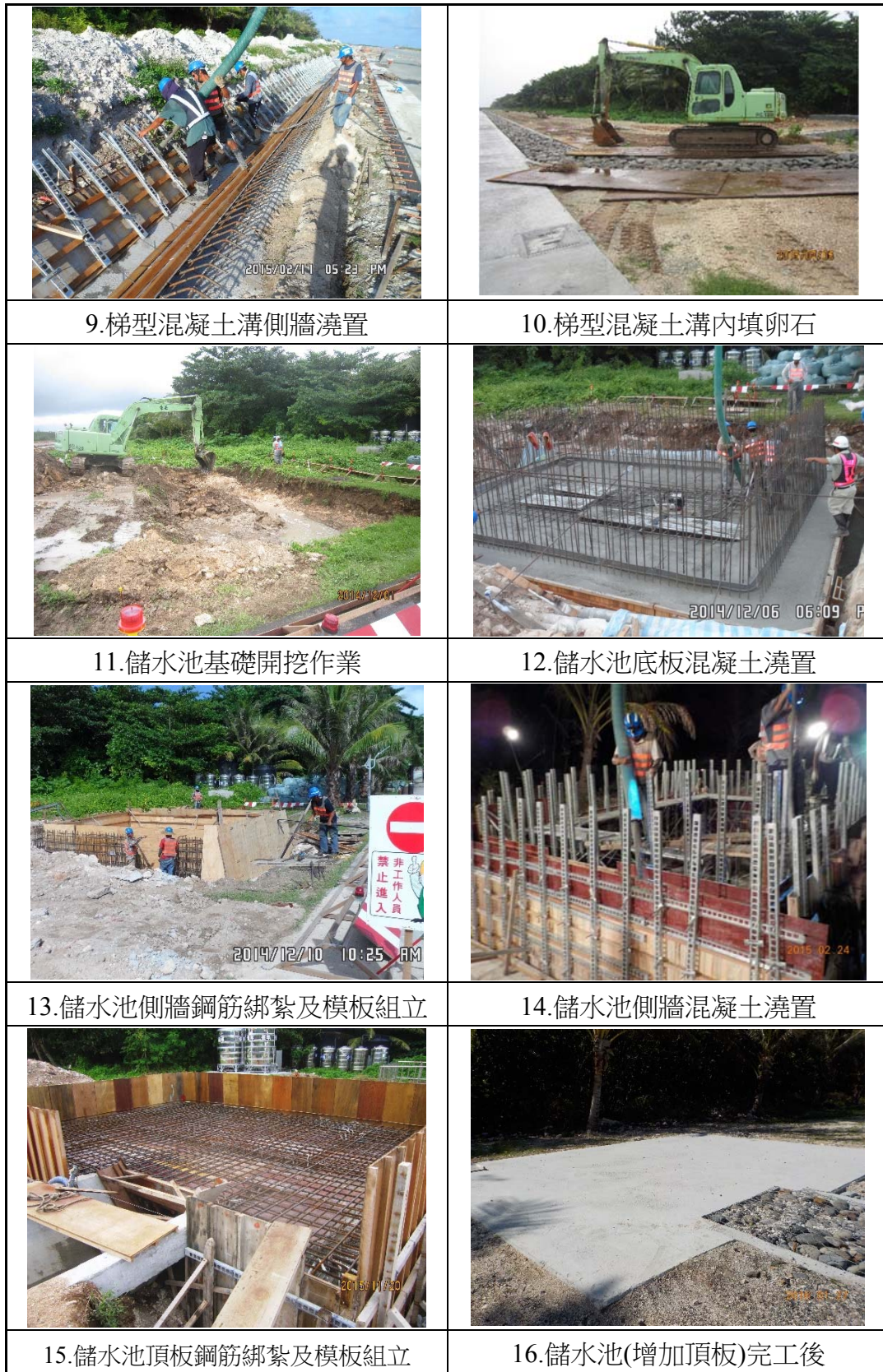
圖 1-104 機場道面排水工程施工相片(2/2)
