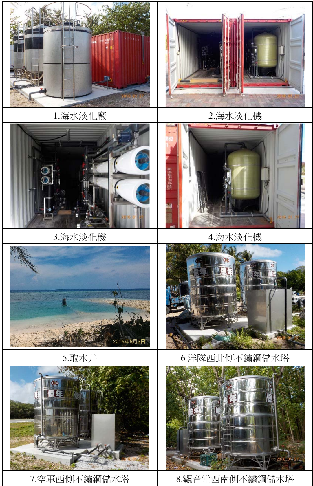
圖 1-123 環島給水系統工程施工照片(1/2)
