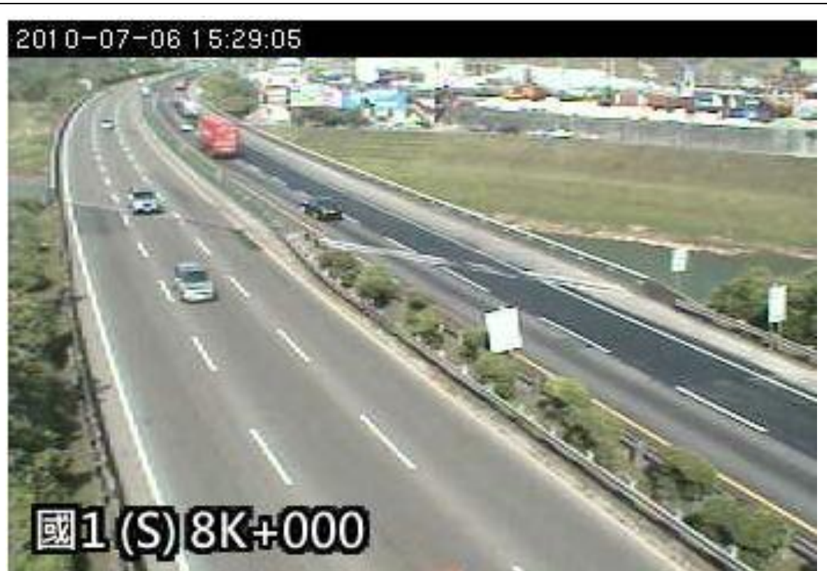
99.07.06_15:29_國1_8 KM_設在南向側 CCTV 畫面
