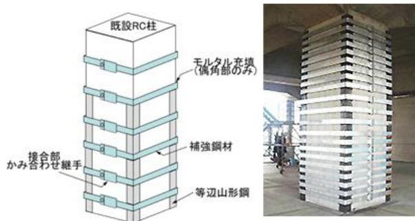
RP (リブプレート) 耐震補強工法
