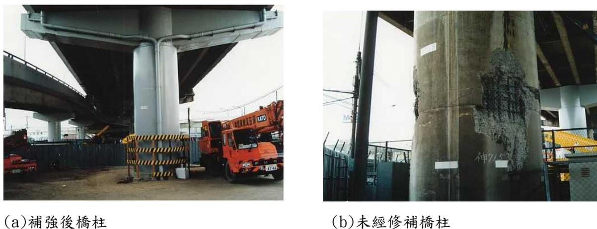
圖 1. 橋梁耐震補強效益的比較(1995 年阪神地震分析)
