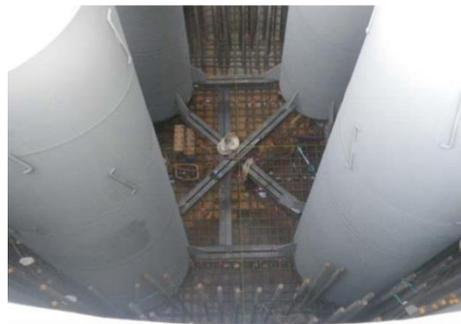
写真-1 鋼管基部の基礎接合部
