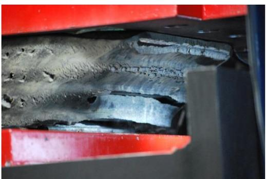
圖十三. 臭氧對於橡膠支承座的損害
