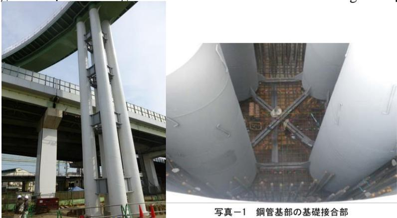
写真-1 鋼管基部の基礎接合部
