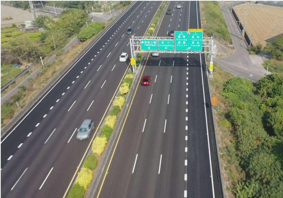
附圖 1 彰化至員林段交通工程改善工程改善後照片(南北雙向均為 3+1 輔助車道)
