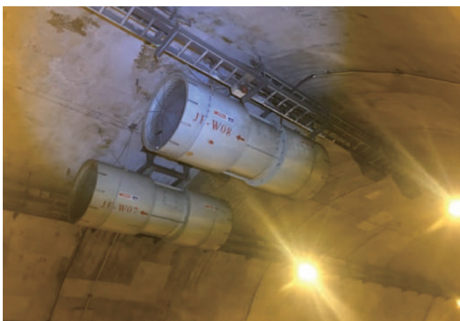
圖 1.3-10 隧道頂拱噴流式風機
