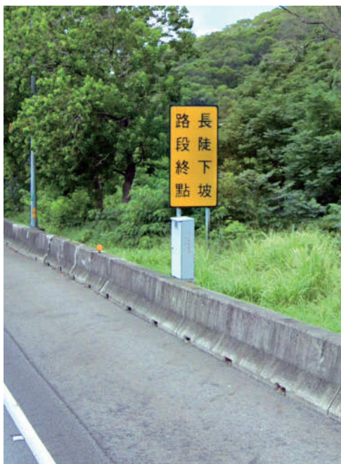
圖 3.4-11 「長陡下坡路段終點」告示牌
