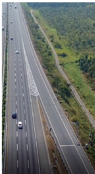
圖 1.3-2 高速公路入口匝道
