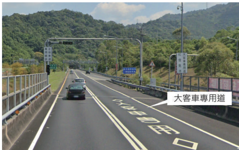
圖 1.3-5 國道 3 號銜接國道 5 號大客車專用道
