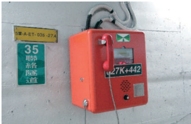
圖 1.3-19 緊急電話 (人行 (車行) 聯絡隧道)
