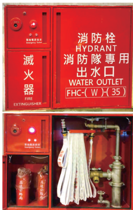
圖 1.3-16 消防栓箱上設有警示燈、通報按鈕、消防泵啟動開關及指示燈，栓箱內含消防水帶及水霧兩用型瞄子及手提式乾粉滅火器
