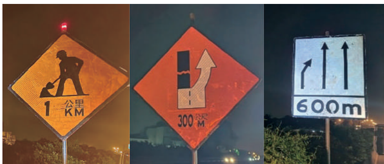
圖 3.6-12 施工預告相關標誌
