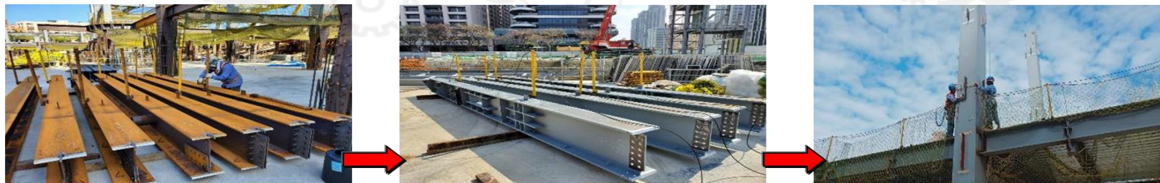
鋼樑於地面預組立柱及安全母索，降低高架作業危害
