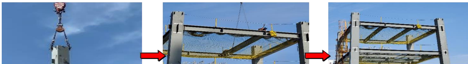
鋼柱使用半自動脫鉤器，降低施作人員高架作業風險
