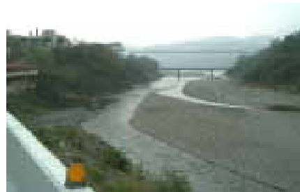
▲利用道路線型引導駕駛視線欣賞台 27 沿線老濃溪景觀
