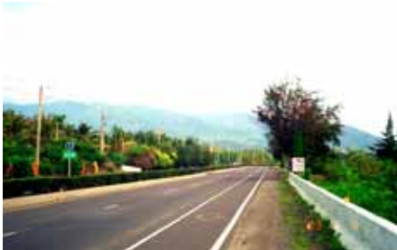
現況 11. 台 1 線屏東縣路段 李麗雯 攝
