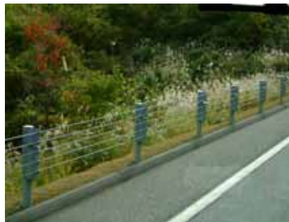
現況 8. 日本美作町沿線道路 郭瓊瑩 攝
