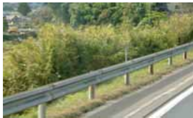
現況 3. 日本美作町沿線道路 郭瓊瑩 攝
