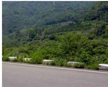
現況 17. 台 1 線屏東縣路段 李麗雯 攝
