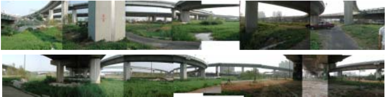
圖 6.2.13 鼎金系統交流道現況照片-東面現況(上)。西面現況(下)
