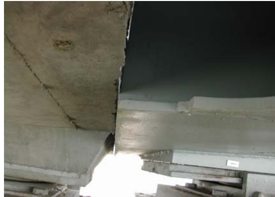
匝道六 PR6-8 墩柱 RC 箱梁與鋼梁下翼板幾近抵觸
