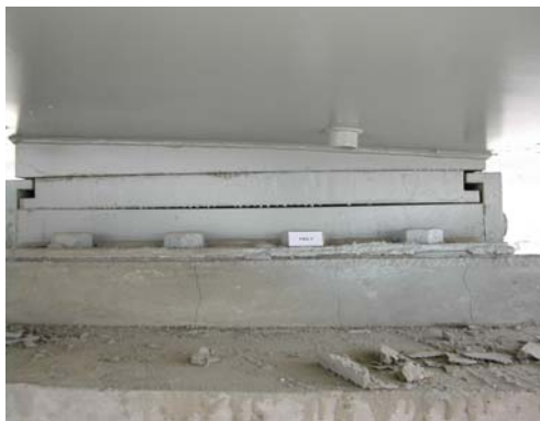
PR8-9 墩柱鋼梁盤式支承無收縮混凝土橫向龜裂情形 (近距離照片)
