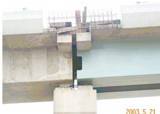
PR8-9 墩柱鋼梁盤式支承無收縮混凝土橫向龜裂情形 (近距離照片)
