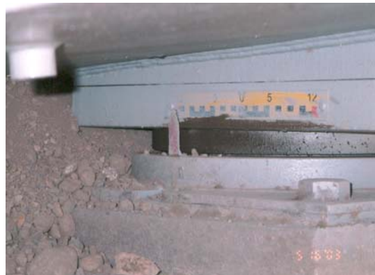
AR6-1 橋台左側鋼梁盤式支承往前滑動約 13cm 情形
