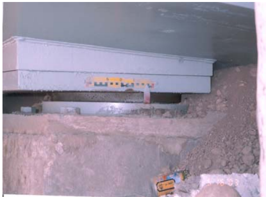
AR6-1 橋台右側鋼梁盤式支承往前滑動約 9cm 情形
