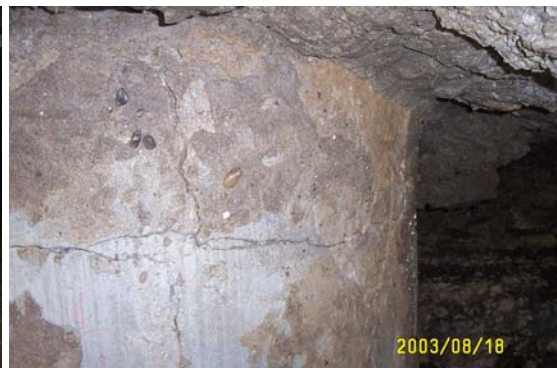
PR8-7 基樁受損情形
