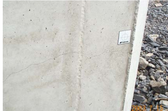
PR6-11 墩柱裂紋現況，裂紋寬度約 0.2mm
