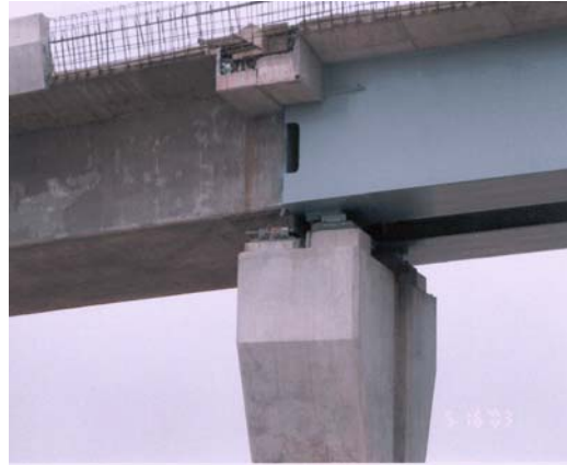
PR8-7 墩柱右側鋼梁盤式支承往南滑出約 23cm 情形
