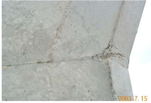
PR6-11 墩柱裂紋現況，裂紋寬度約 0.2mm
