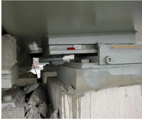
PR8-7 墩柱右側鋼梁盤式支承往南滑出約 23cm 情形
