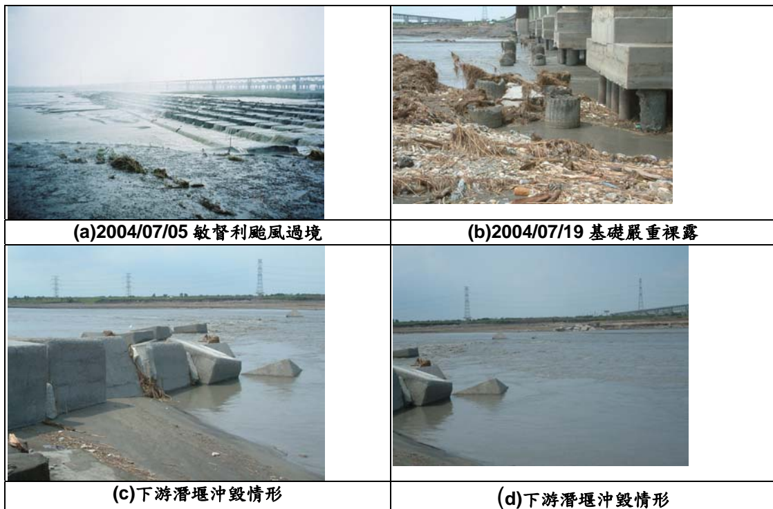
圖 6.52 中沙大橋下游潛堰沖毀情形
