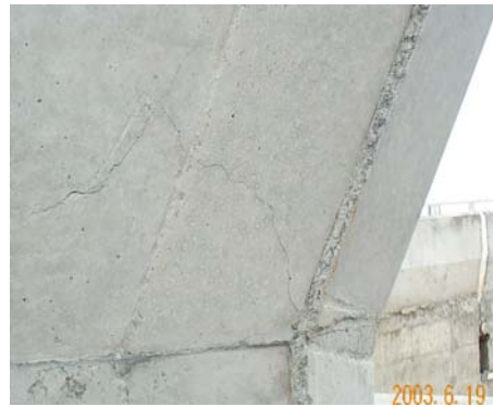
匝道 8 高架橋 PR8-9 墩帽（北側）之斜向裂紋
