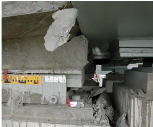
PR8-7 墩柱 RC 箱梁右側調坡塊受鋼梁擠壓進入 3cm 之破損情形
