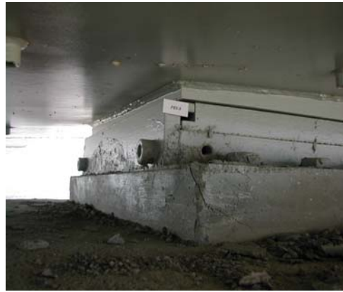
PR8-7 墩柱 RC 箱梁右側調坡塊受鋼梁擠壓進入 3cm 之破損情形
