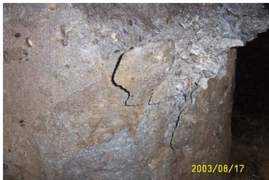
PR6-8 基樁受損情形
