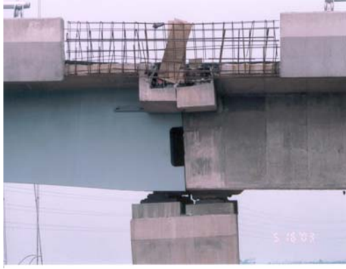
匝道六 PR6-8 鋼梁與 RC 箱梁上翼板相抵觸
