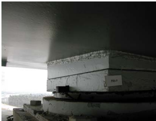
匝道六 PR6-9 墩柱右側鋼梁盤式支承已滑出約 8cm 情形
