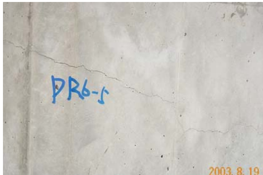
匝道 6 高架橋 PR6-5 墩帽上有二道裂縫，寬約 0.4mm
