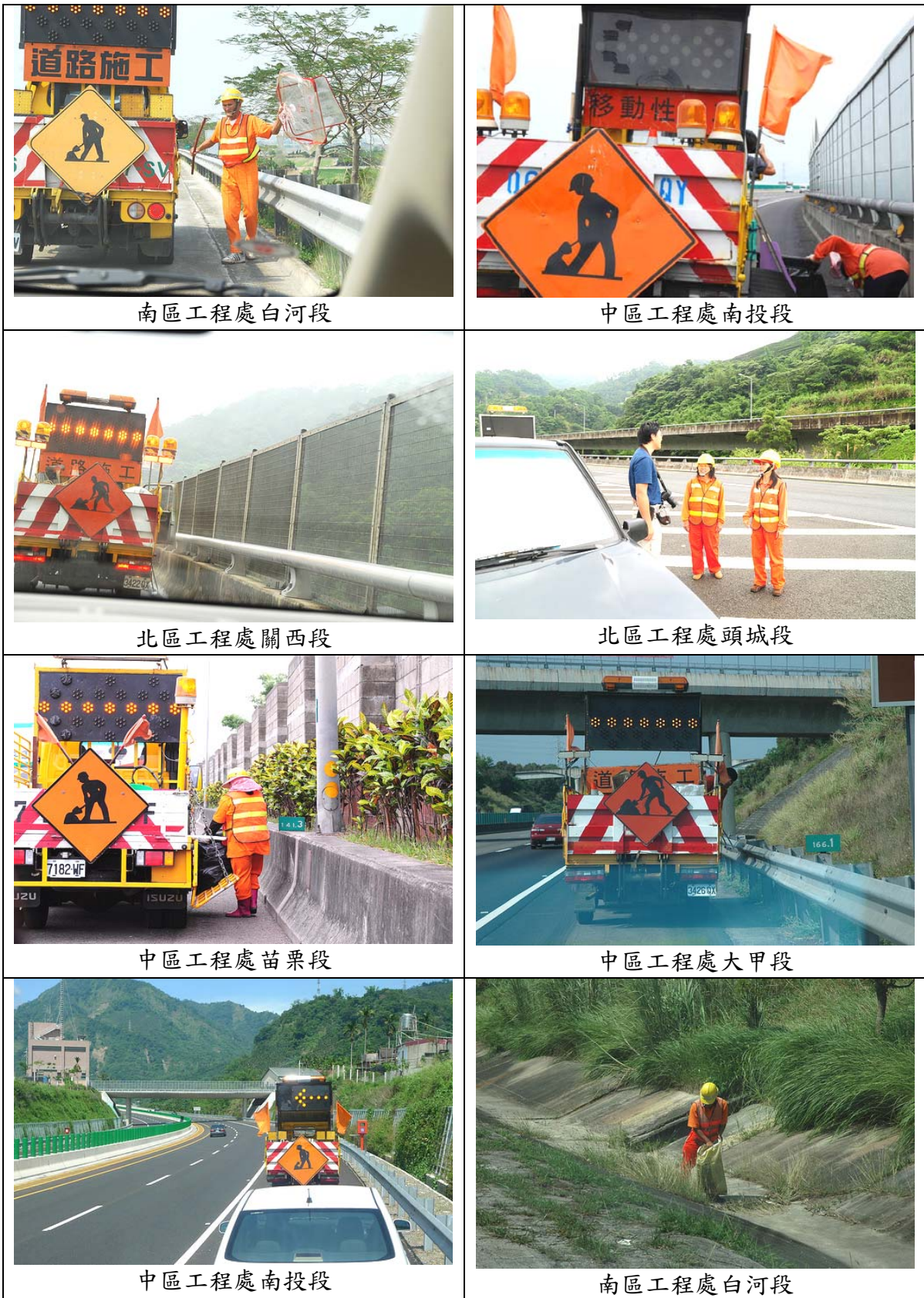
圖 6.2.1-2 路容清潔和事故處理人員協助道路致死調查試驗操作
