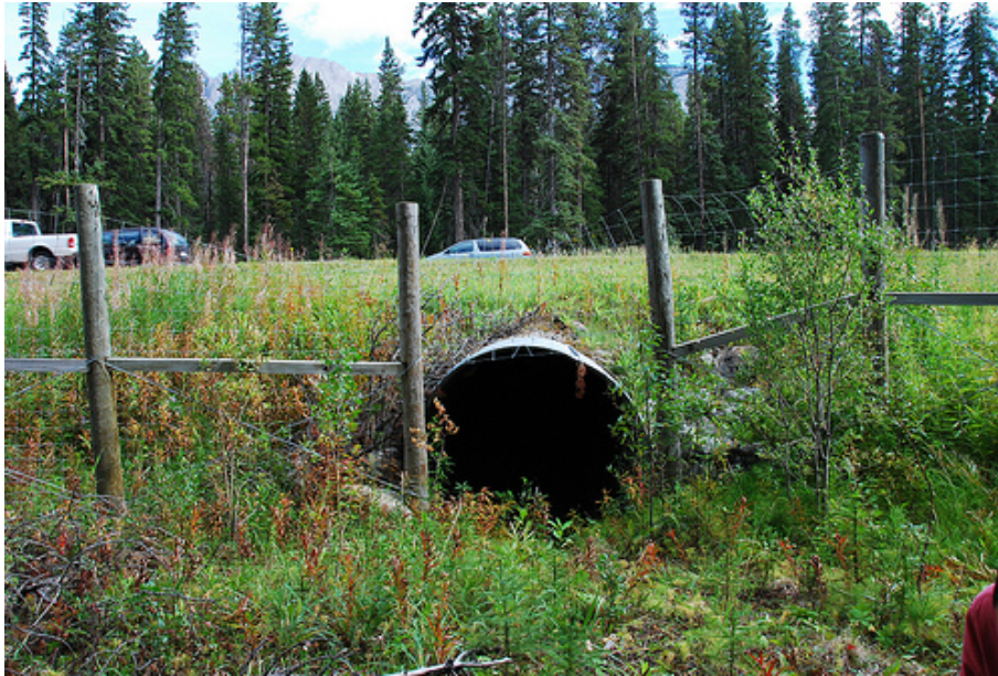
圖 6.2.3-2 加拿大 Banff 國家公園高速公路下方的穿越式動物通道和兩側的隔離網(攝影 蘇維翎)
