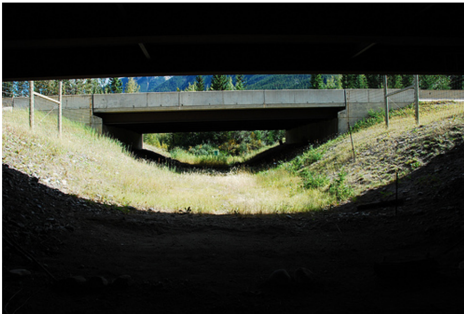
圖 6.2.3-1 加拿大 Banff 國家公園高速公路下方的穿越式動物通道和兩側的隔離網(攝影 蘇維翎)
