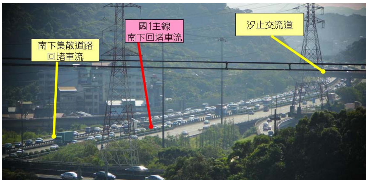
圖 5.1-5 南向集散道路容量不足，尖峰時段回堵情形
