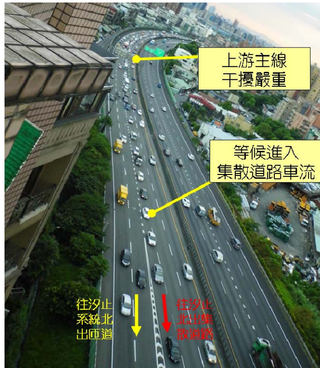
圖 5.1-6 北上方向集散道路於下午尖峰回堵車流影響主線示意圖
