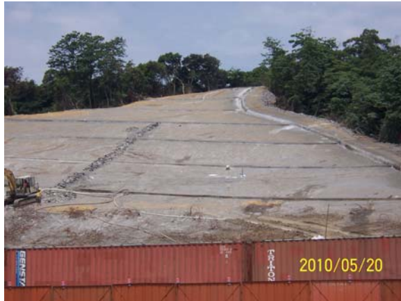
施工中的坡面排水
