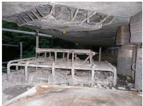
盤式支承墊更換情形(二)
