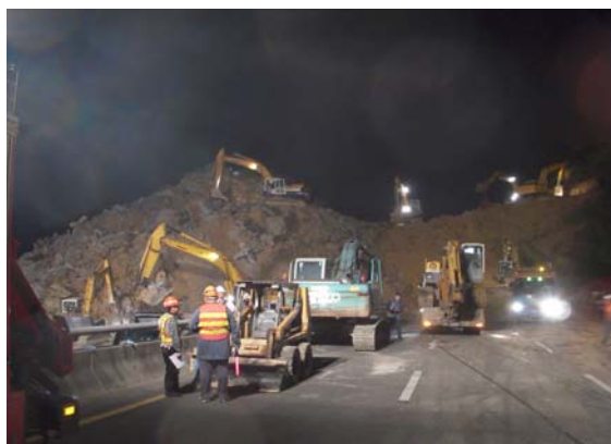
99 年 4 月 25 日晚間北端作業情形
