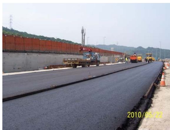
鋪面作業情形
