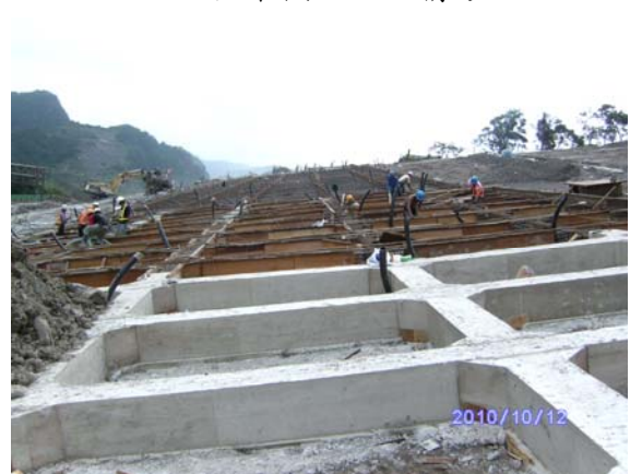
大格梁完成情形
