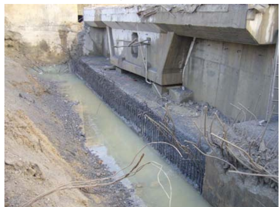
橋台背牆鋼筋綁紮作業
