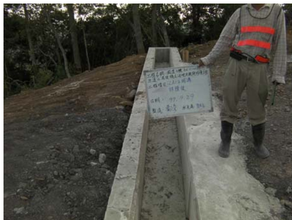
排水溝完成情形
