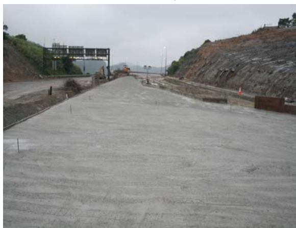
路基處理作業情形
