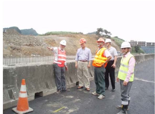
世曦公司向部長報告施工情形
