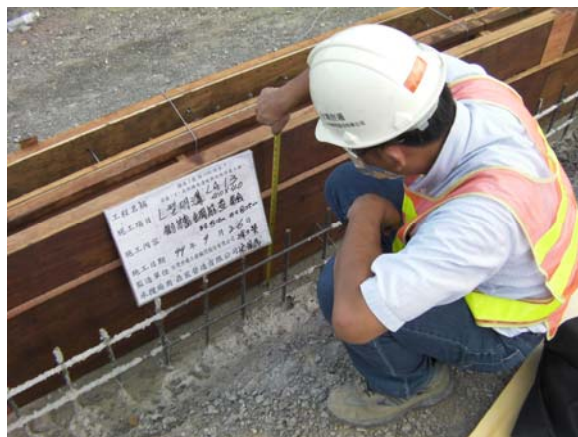
排水溝模板組立情形
