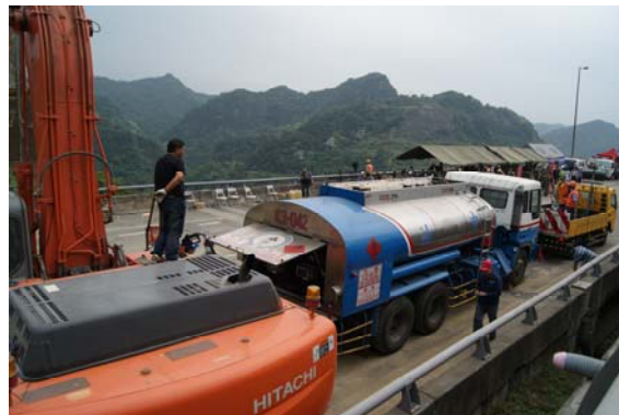
機具連續開挖由中油油罐車協助加油
