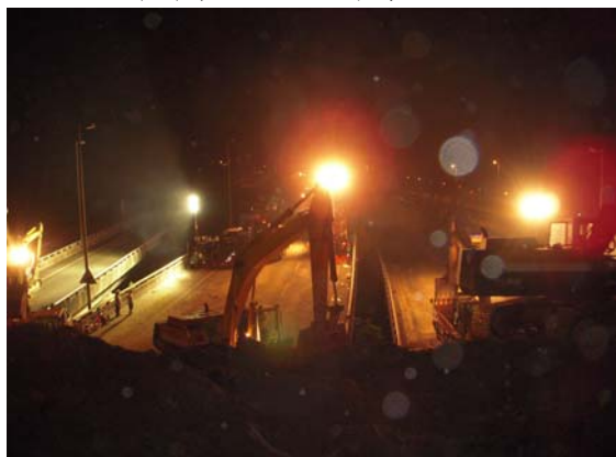
北端作業情形
