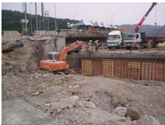
橋台背牆模板組立作業
