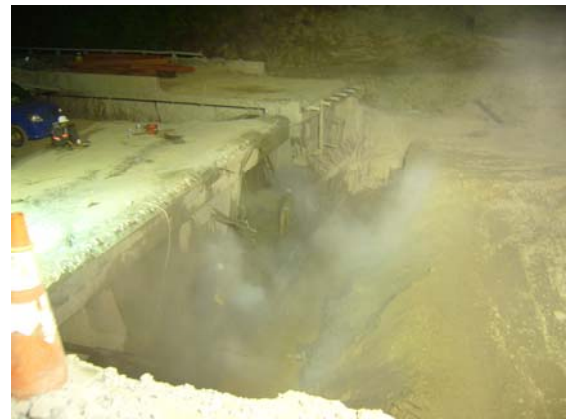
橋台背牆水刀清除作業
