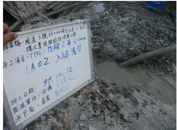
地錨固定端灌漿作業情形
