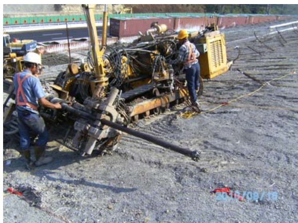
水平排水管作業情形
