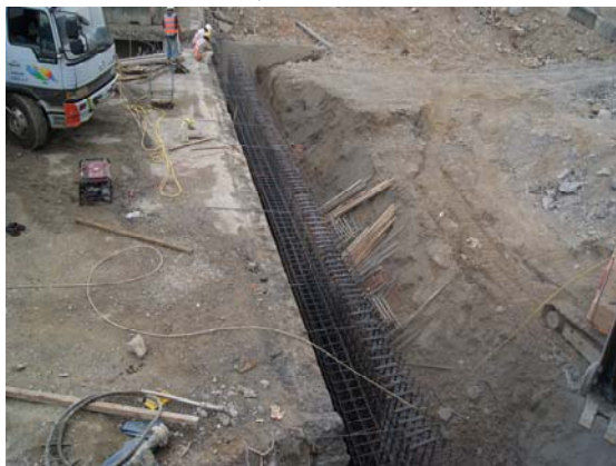
橋台背牆水刀清除完成
