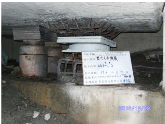
盤式支承墊更換情形(三)
