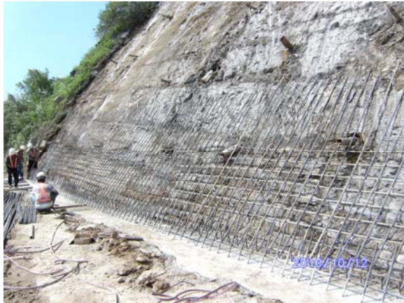
幕牆面板鋼筋組立情形(一)
