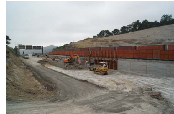
擋土牆牆身完成情形
