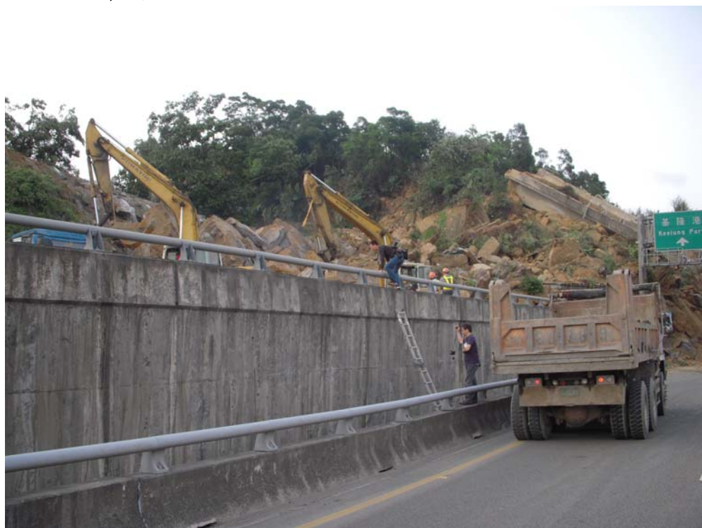
機具動員抵達現場立即挖土方(圖二)
