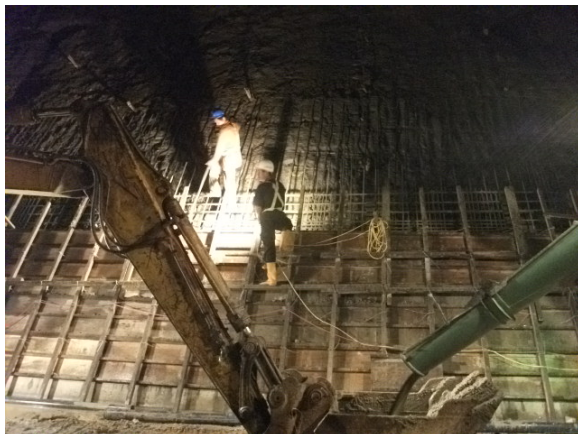
幕牆面板混凝土澆置情形
