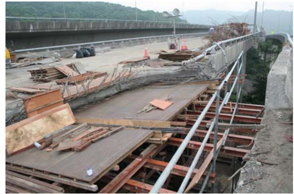
橋面版模版組立作業
