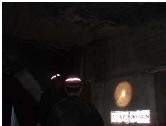
99.04.30. 設施損壞勘查情形(一)
