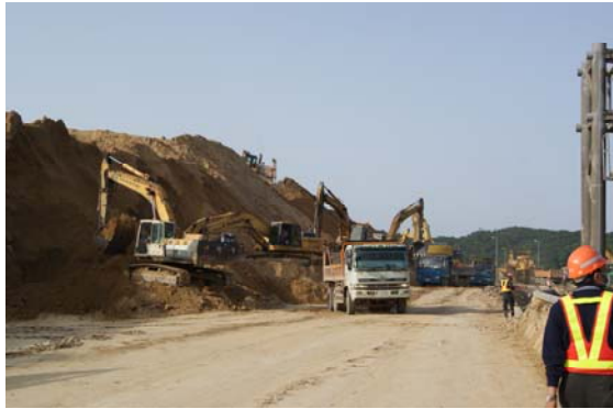
南下便道開通加速開挖速度
