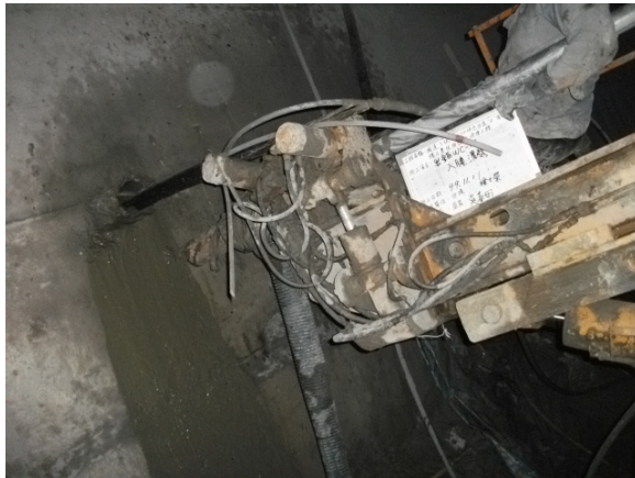
地錨鑽孔作業情形
