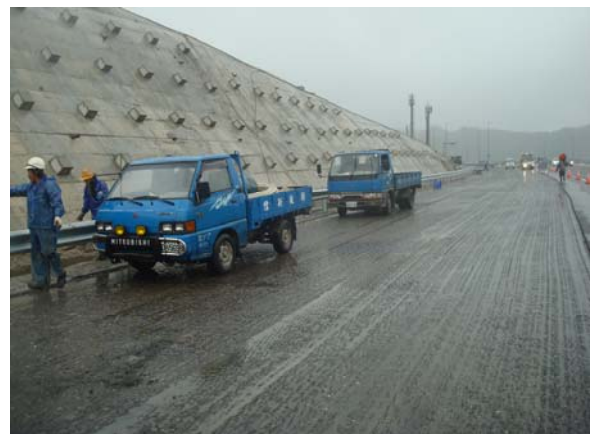
幕牆面板完成後情形
