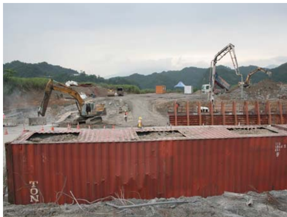
貨櫃牆設置作業情形
