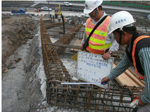
大格梁鋼筋組立情形
