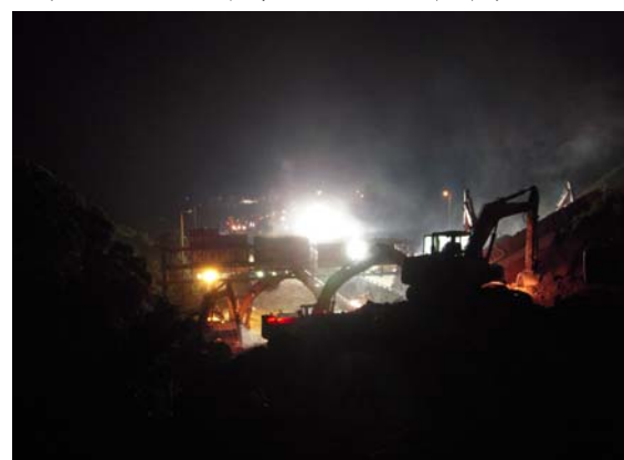
南端作業情形
