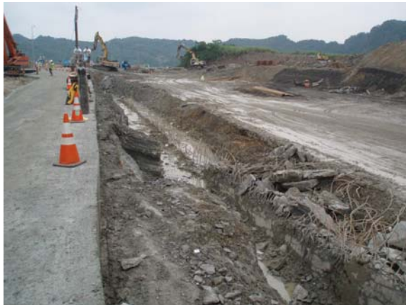
擋土牆基礎開挖情形
