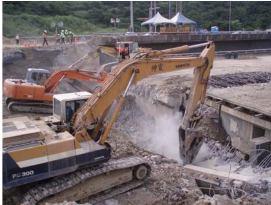
橋台背牆敲除作業
