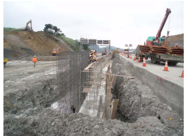
擋土牆牆身鋼筋組立情形
