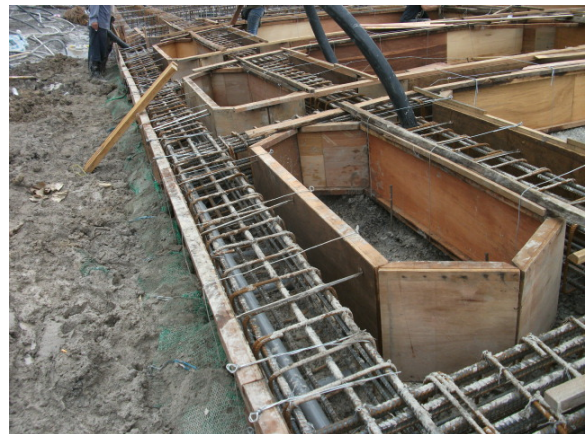
大格梁模版組立情形
