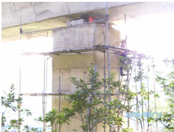
盤式支承墊更換情形(一)
