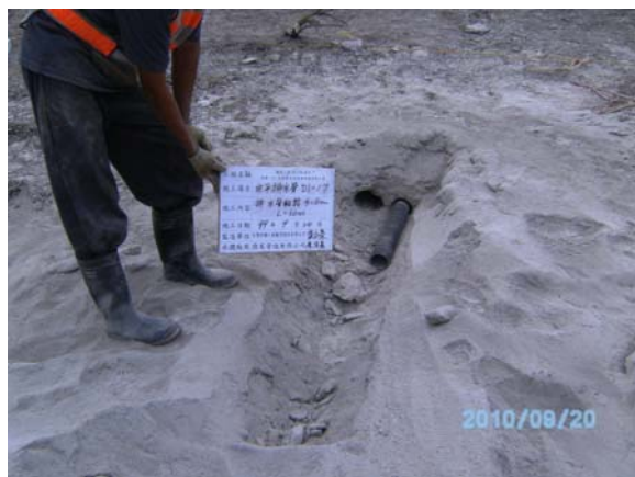
水平排水管完成情形
