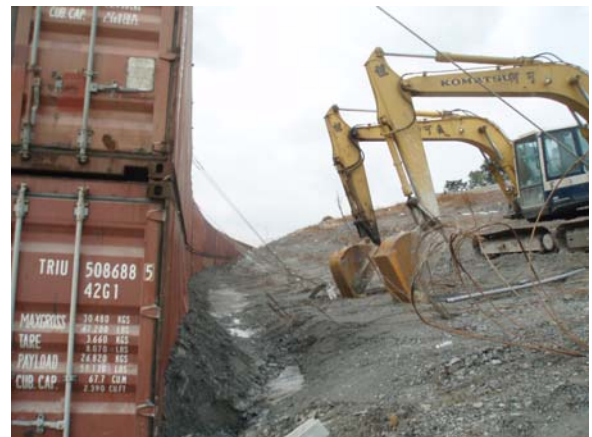
貨櫃牆鋼纜固定情形
