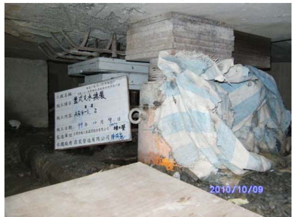
盤式支承墊更換情形(四)
