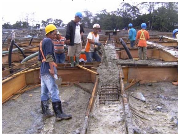
大格梁混凝土澆置情形
