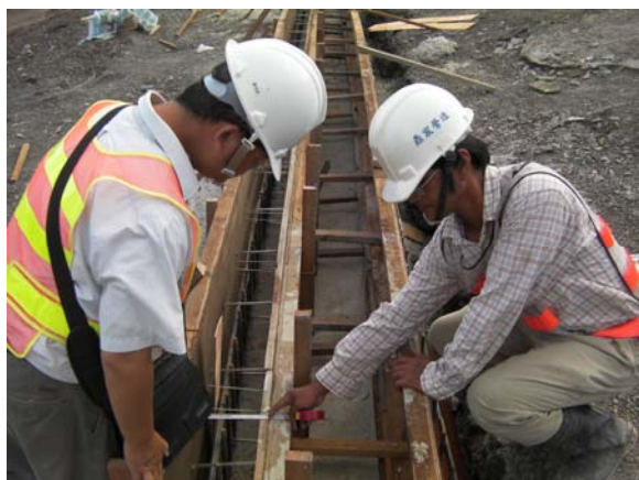
排水溝模板組立情形
