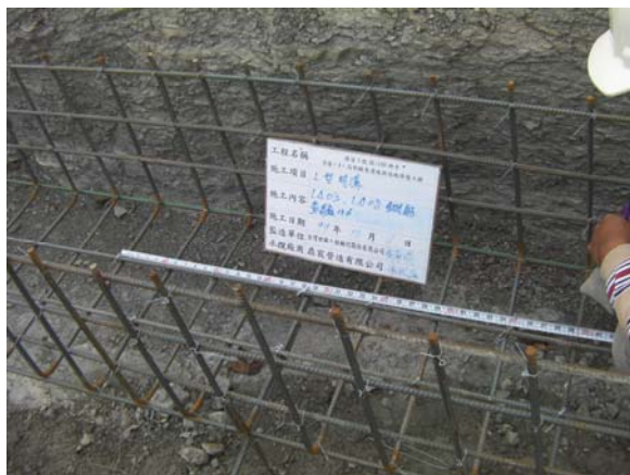
排水溝鋼筋組立情形
