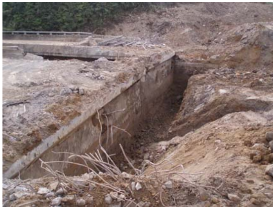
開挖檢視橋台受損情形(一)
