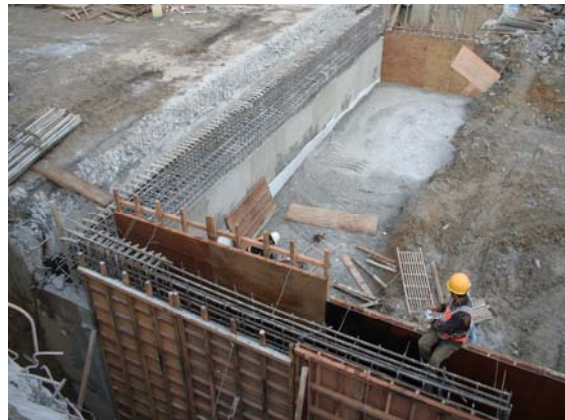
橋台背牆第一昇層完成
