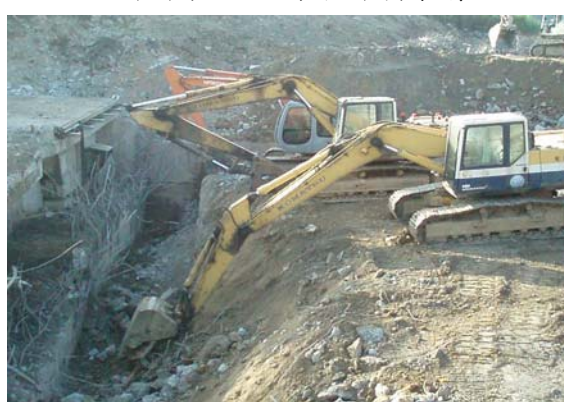
威盛營造開挖北上橋頭進橋板
