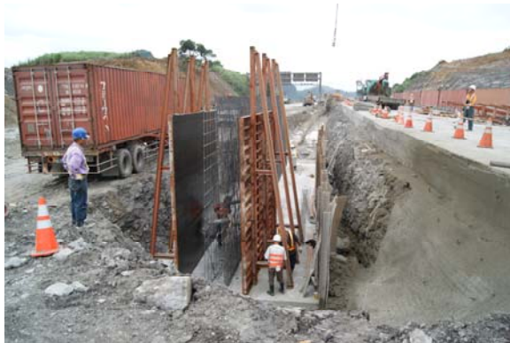
擋土牆牆身模板組立情形
