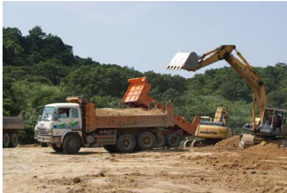
國道3號北上 7K+300 棄土堆置場
