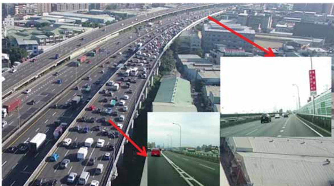
圖 4.1-1 國道 1 號五楊高架與五股轉接道匯流處改善情形
