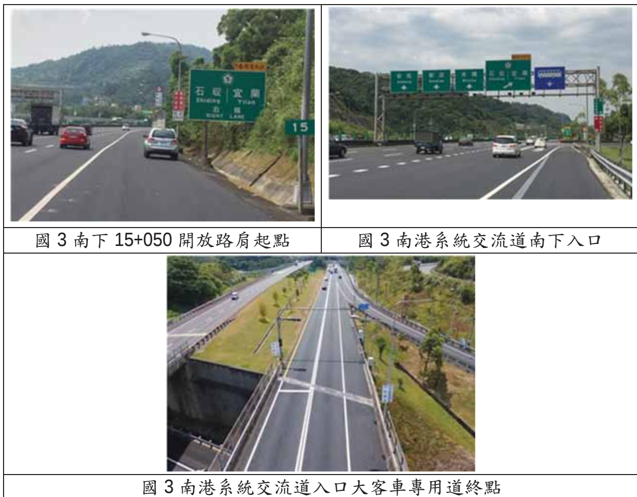
圖 4.1-12 國道 3 號南下 15+050、南港系統交流道南下入口、大客車專用道改善情形
