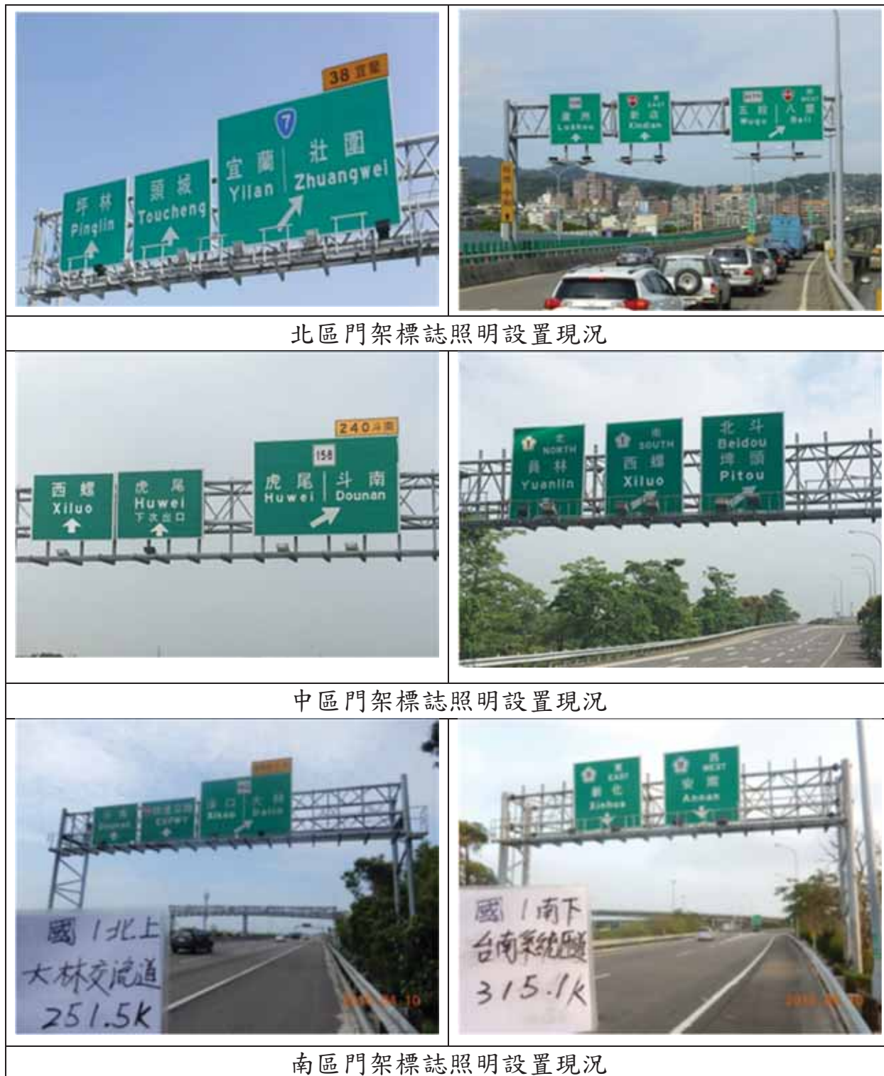
圖 4.1-13 北區、中區、南區門架標誌照明設置現況
