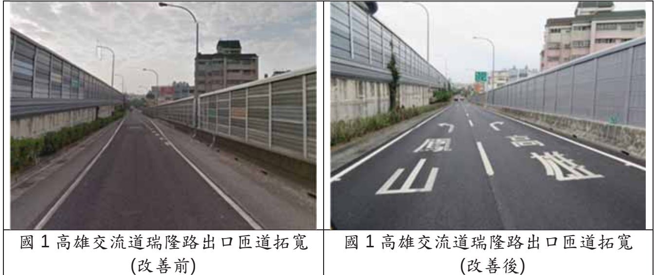
圖 4.1-10 國道 1 號高雄交流道瑞隆路出口改善情形
