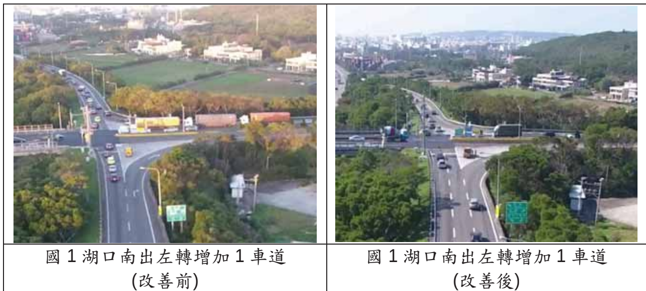
圖 4.1-6 國道 1 號湖口交流道南下出口匝道改善情形
