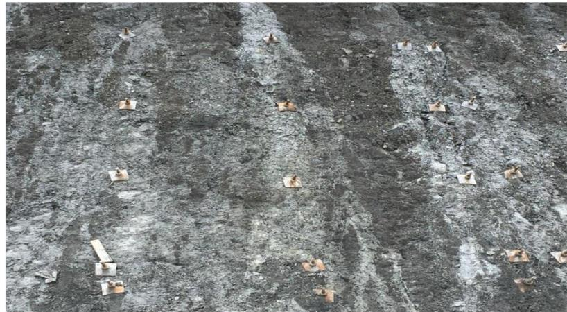
路塹段B6岩栓打設確認依圖說施工
