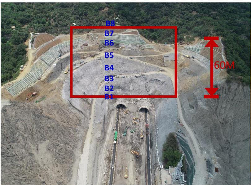
調整隧道口上方土方先行降挖加速隧道上方B區土方降挖作業，並加設相關保護措施。
