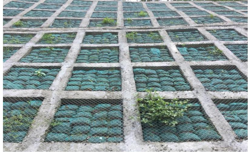
格梁護坡客土植生確認依圖說施工
