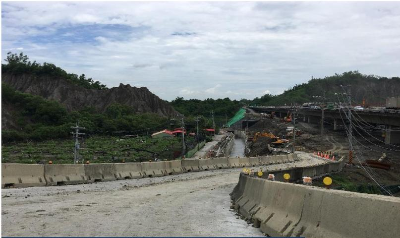
設置混凝土路面及RC護欄防墜
