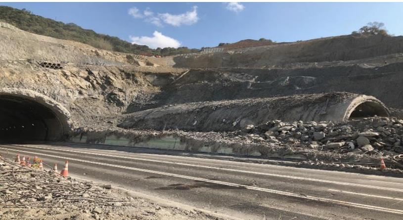
配合隧道頂拱拆除，施工需於夜間封閉高速公路雙向主線，作業前召開各項工作確認會議。
