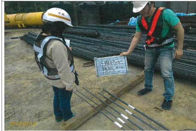
M01-010-014 鋼筋取樣(C713-M01-003)
