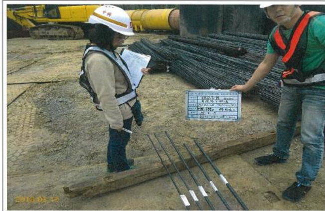
M01-010-014 鋼筋取樣(C713-M01-003)
