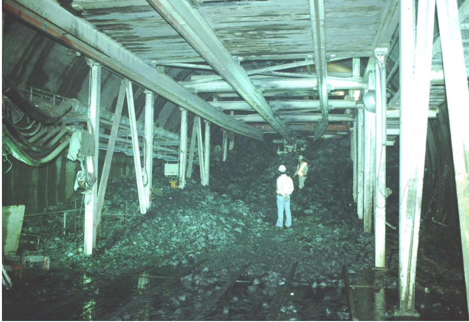
照片 4.1 雪山隧道南下線 TBM 第 2 次先進工法頂導坑開挖之先撐鋼管樁及臨時支撐
