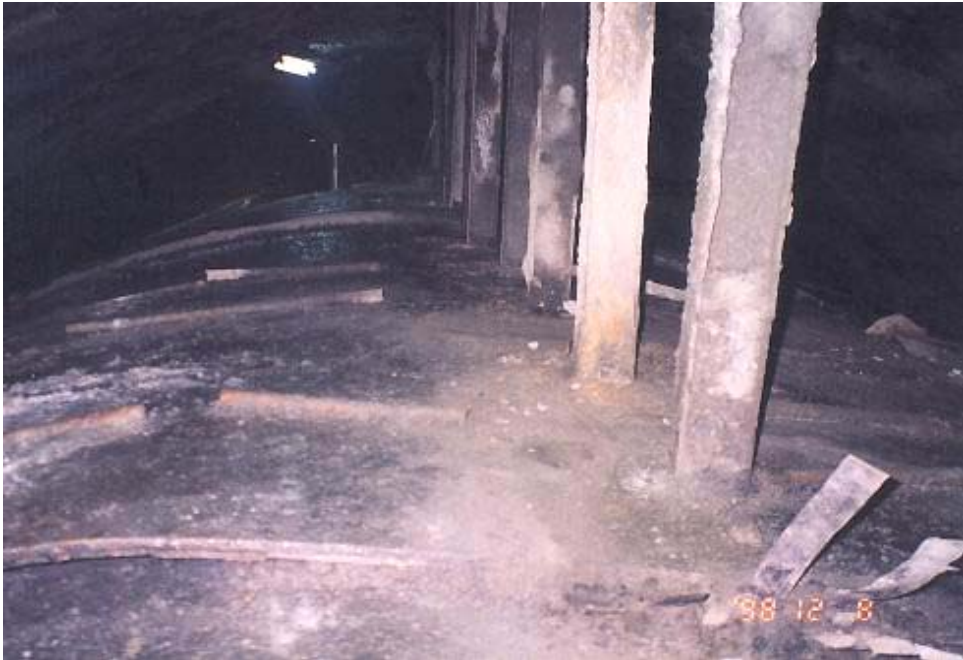
照片 6 雪山隧道南下線第 1 次頂導坑以 TBM 開挖下半斷面前所構築混凝土撐腳座
