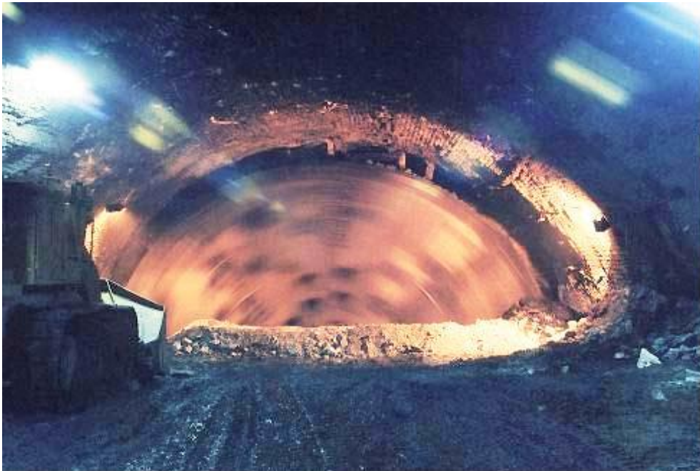
照片 5.1 雪山隧道南下線第 2 次頂導坑往前開挖之碴料藉由後方 TBM 進行出碴
