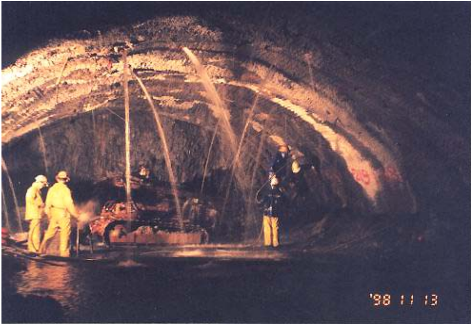
照片 5.1 雪山隧道南下線第 2 次頂導坑往前開挖之碴料藉由後方 TBM 進行出碴
