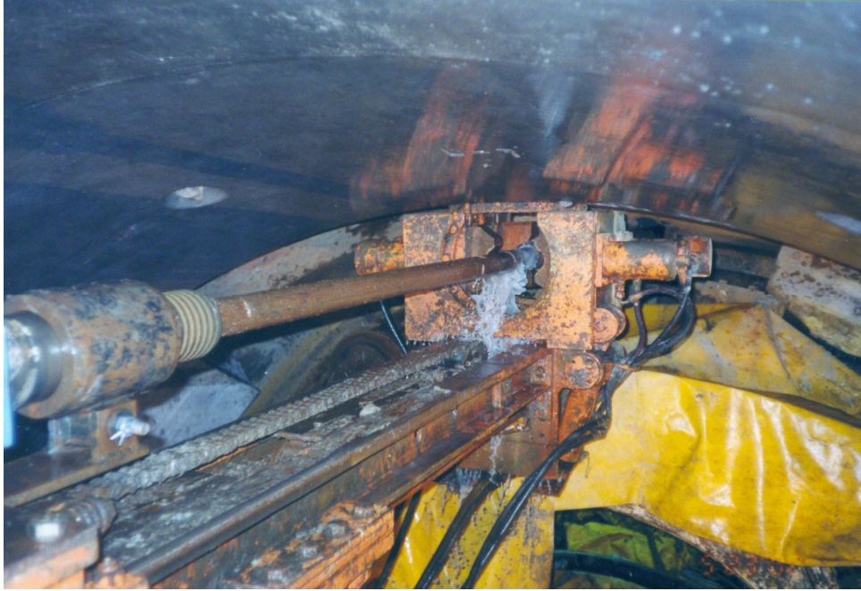
照片 3.1 雪山隧道導坑 TBM 於里程 39k+079 受困
