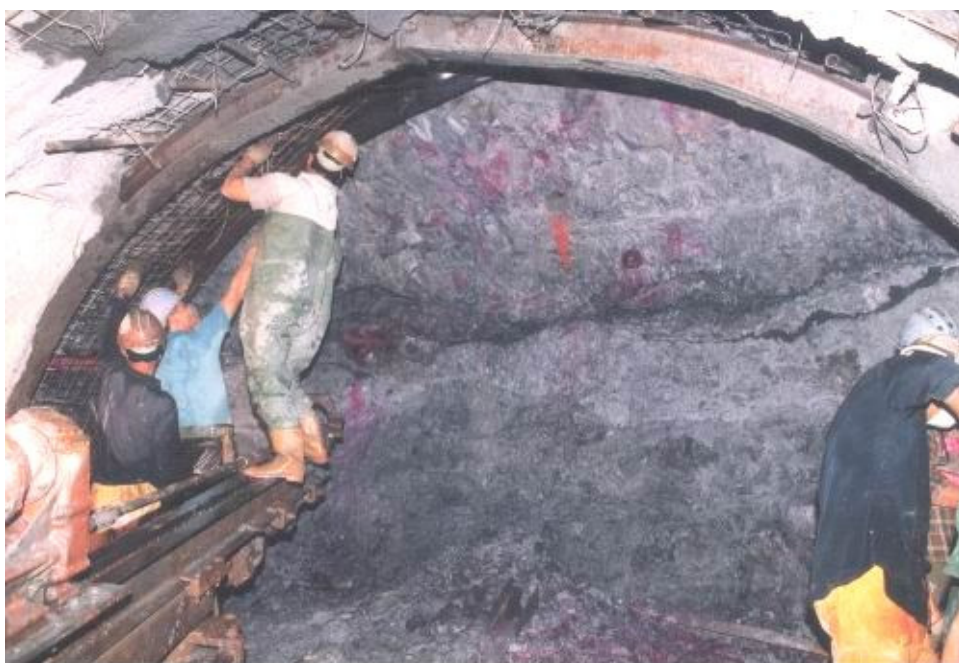
照片 8 雪山隧道導坑鑽炸法開挖利用酚酞噴灑於裸露面檢視灌漿成效
