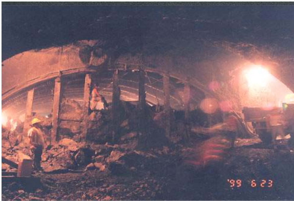
照片 4.1 雪山隧道南下線 TBM 第 2 次先進工法頂導坑開挖之先撐鋼管樁及臨時支撐
