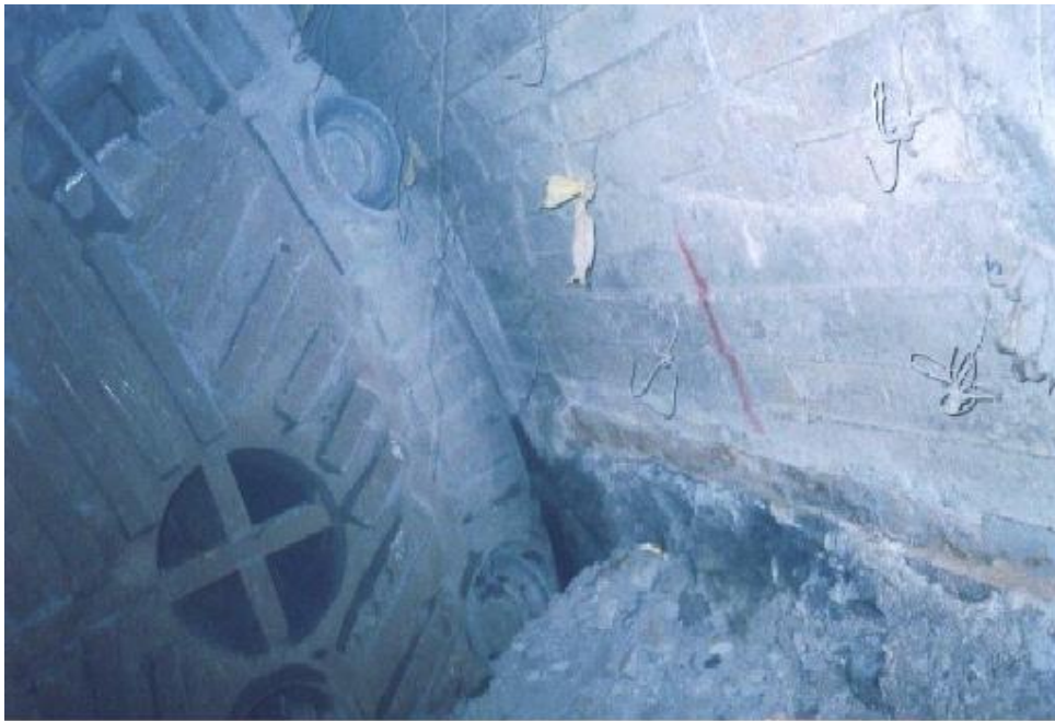
照片 6 雪山隧道南下線第 1 次頂導坑以 TBM 開挖下半斷面前所構築混凝土撐腳座
