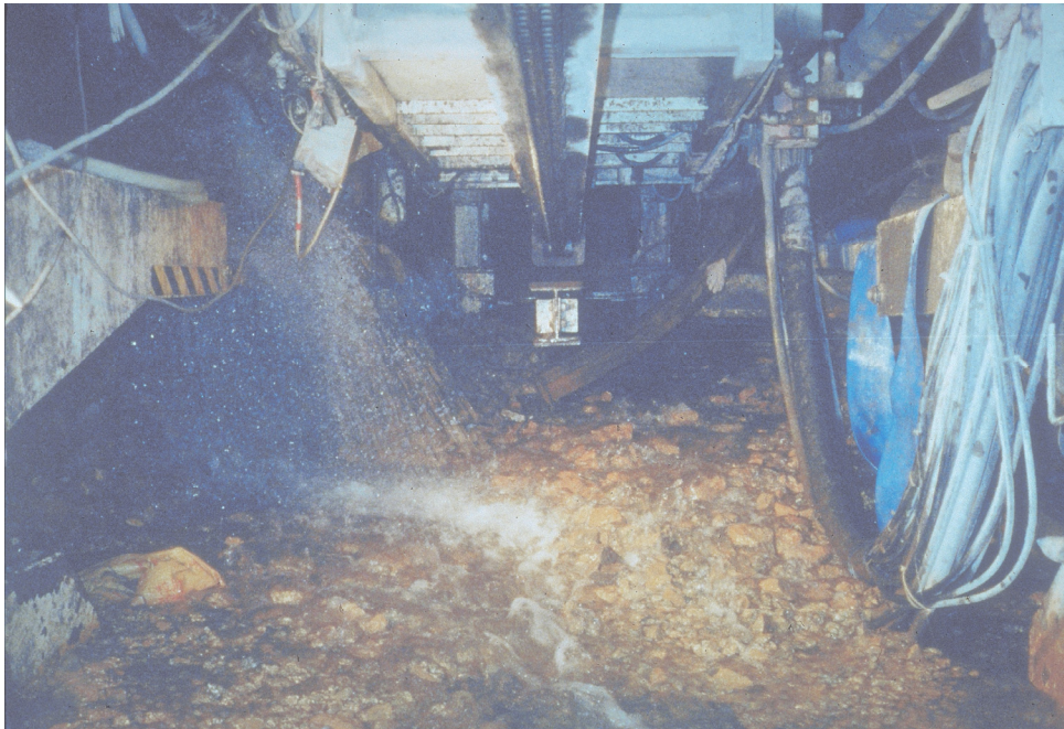
照片 3.1 雪山隧道導坑 TBM 於里程 39k+079 受困
