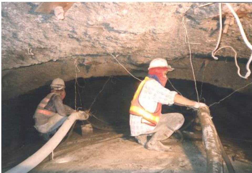
照片 7 雪山隧道南下線頂導坑以 TBM 開挖下半斷面之噴凝土背填粒料
