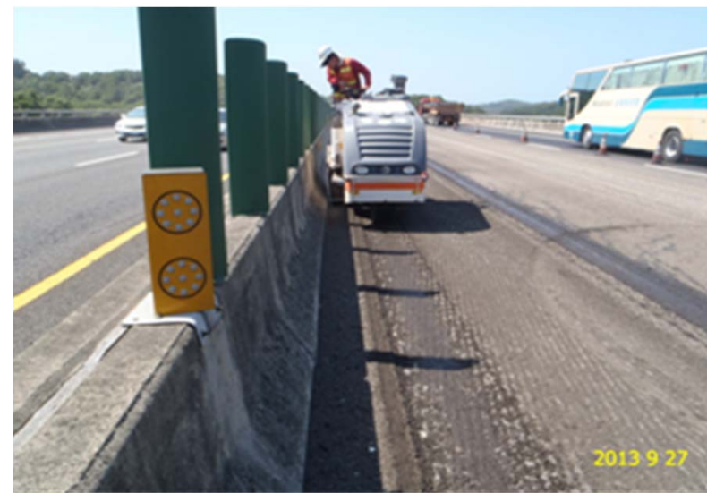
護欄邊緣使用小型刨除機
