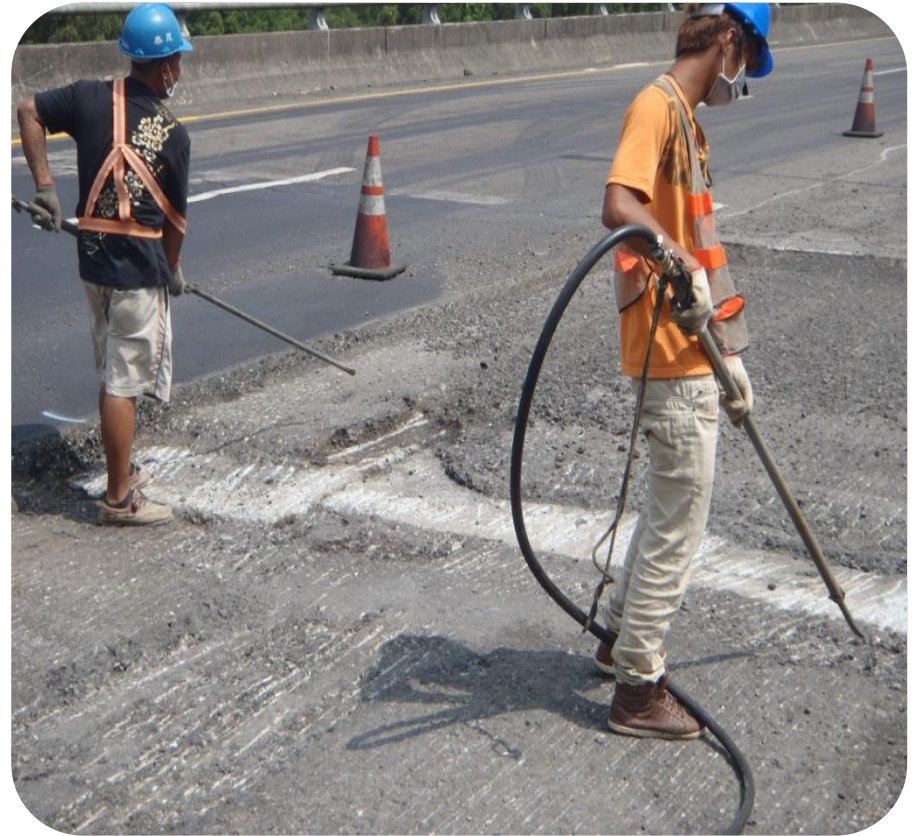
刨除後以空壓機清理裂縫
