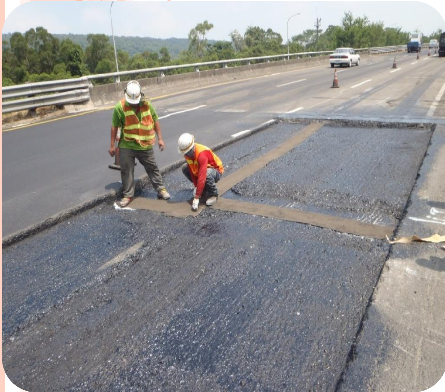
玻璃纖維瀝青貼布施工
