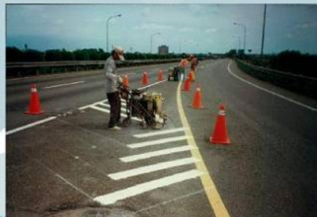
88年斗南-豐原入口匝道繪設槽化線工程
