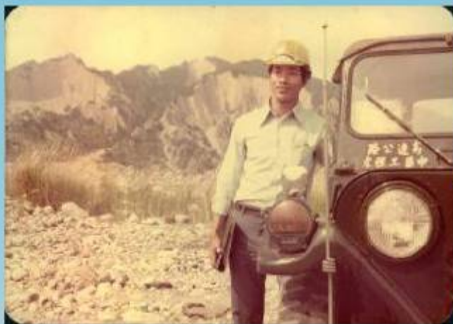
64年8月攝於大安溪底火炎山下 (第一工務段60標軍方協建)
