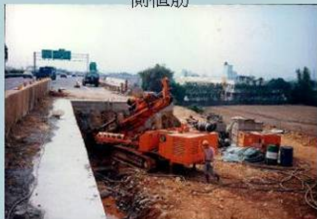
86年1月14日地錨鑽孔施工，該處即為現在的178K+850青海路車行箱涵
