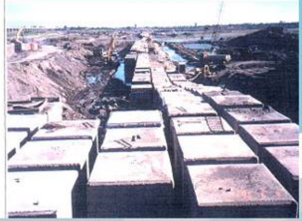
固床工場鑄混凝土塊施工情形
