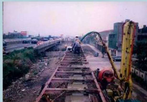
88年南下澆置混凝土
