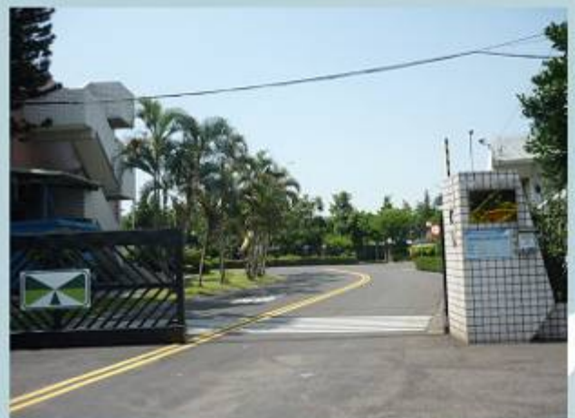
原魚池已拆除改建通道及守衛室
