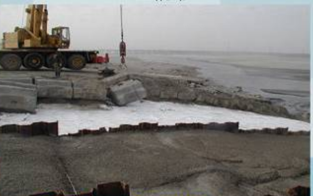
227K+800右側潛堰護坦緊急搶修工程蜂巢塊擺設情形
