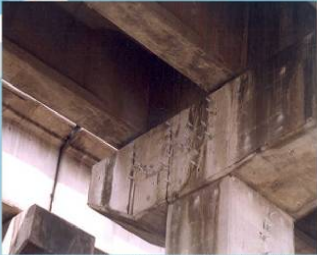
88年中沙大橋耐震維修補強（第二期工程）帽梁裂縫以注射器注射環氧樹脂
