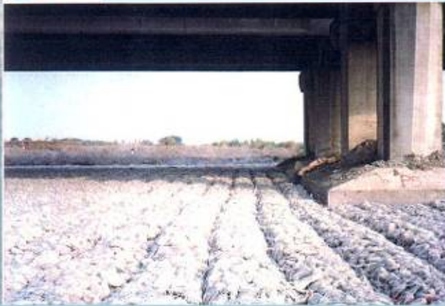
85年中沙大橋橋墩保護及增設下游 潛堰工程橋墩上下游鋪設蛇籠
