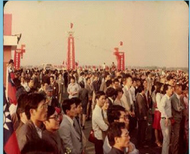
67年10月31日高速公路全線通車典 禮盛況於中沙大橋北端
