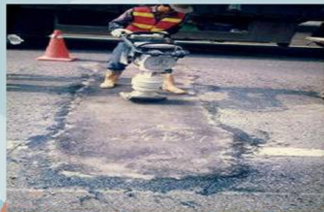
88年234k+621N 橋面AC脫落坑洞修補
