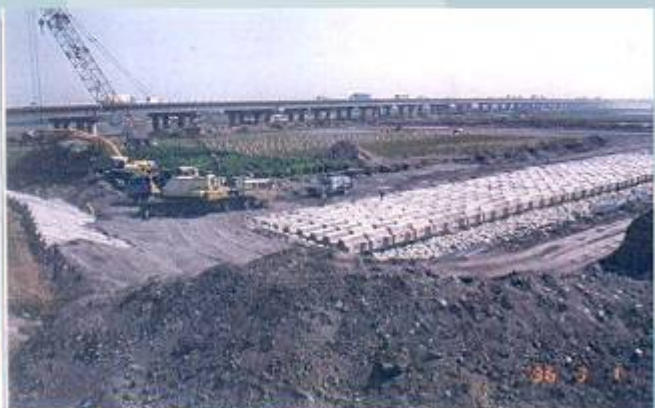
固床工混凝土塊下游吊放蜂巢塊情形
