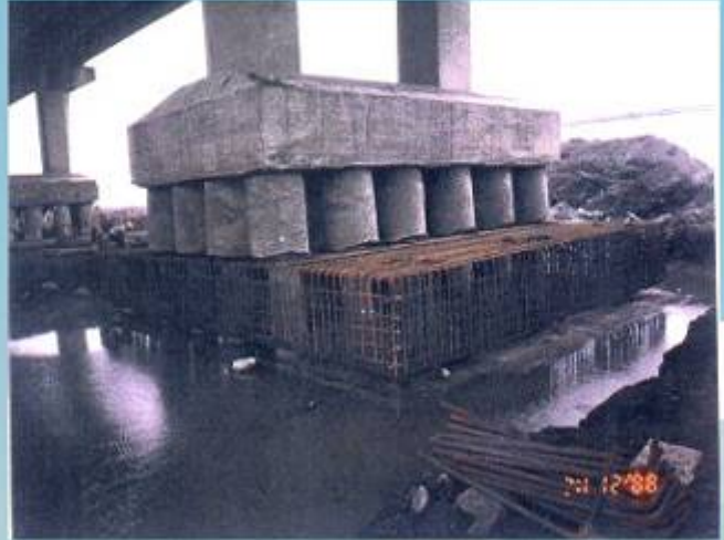
下層樁帽鋼筋排設情形
