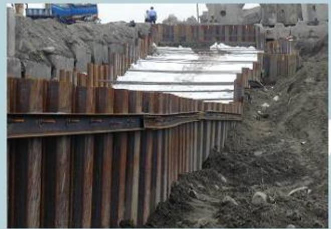
227K+800右側潛堰護坦緊急搶修工程鋼板樁施工完成
