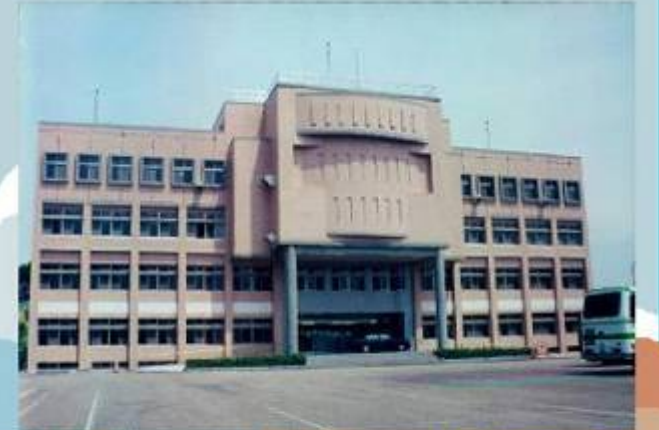
中工處交控大樓新建後建築物
