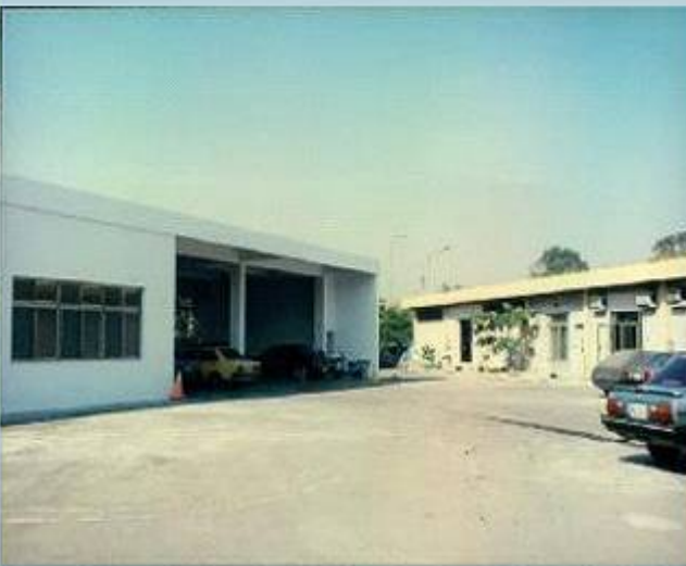
中工處職務宿舍未改建前原貌
