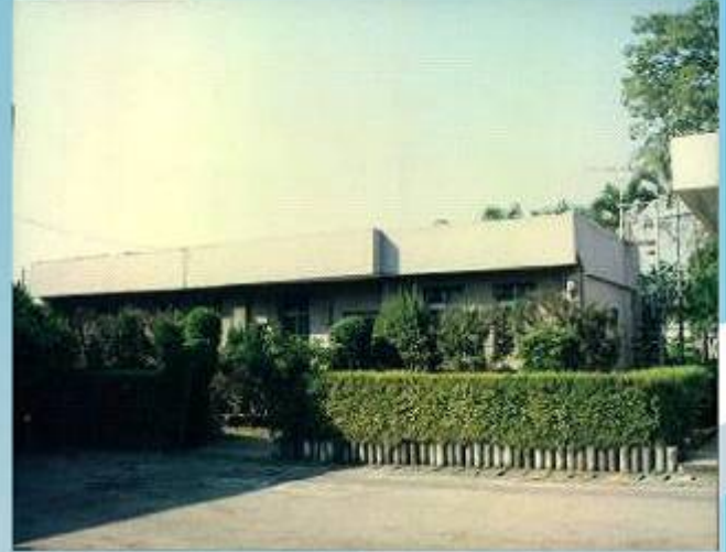
中工處職務宿舍未改建前原貌
