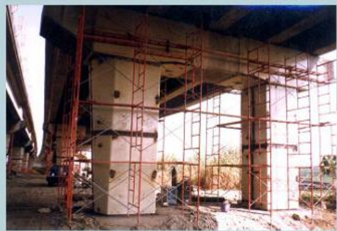
包覆鋼板組立完成
