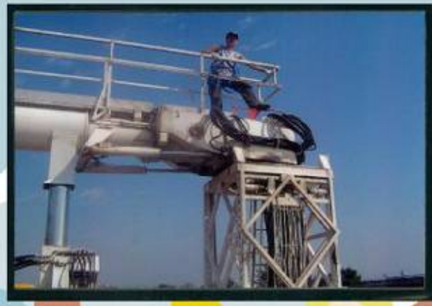
橋檢車作業(林文信先生提供照片)
