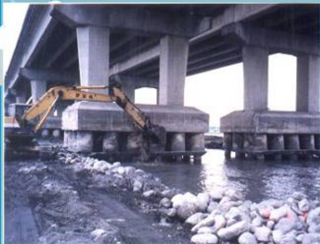
85年賀伯颱風災害於橋墩刷深處進行卵石拋置情形
