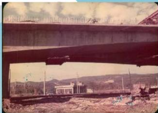
66年王田交流道跨越橋 (台1線及海線鐵路) 施工照片
