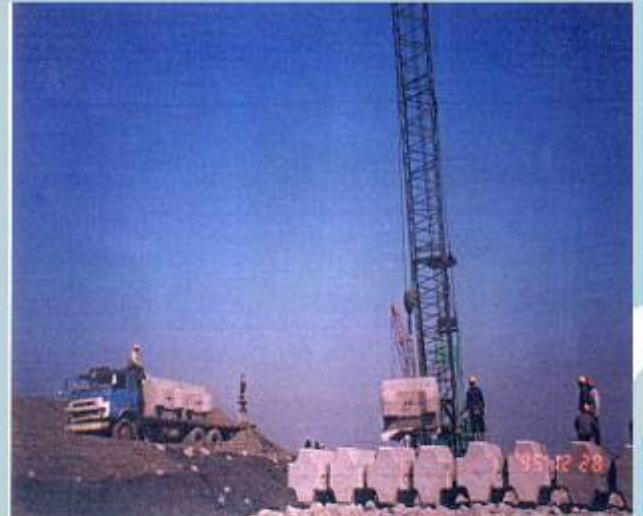
固床工混凝土塊下游吊放蜂巢塊 情形
