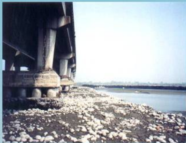
中沙大橋卵石拋置完成面
