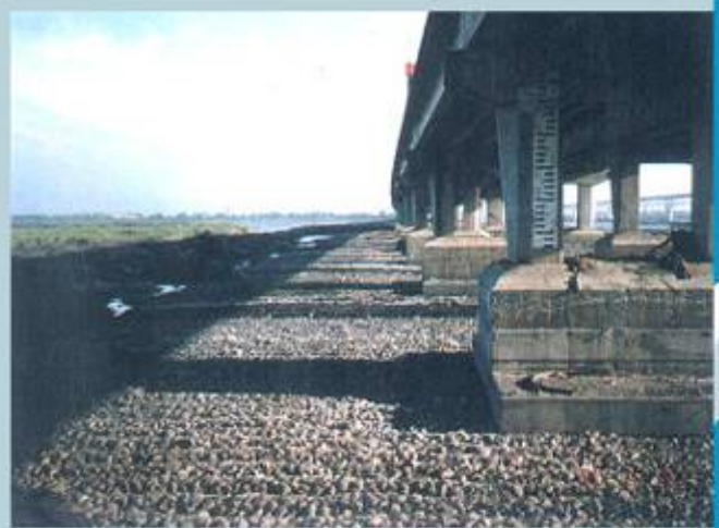
基礎補強及蛇籠鋪置完成面
