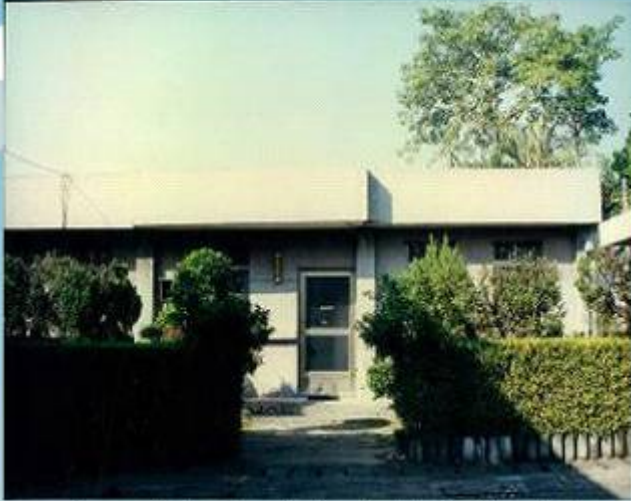
中工處職務宿舍未改建前原貌
