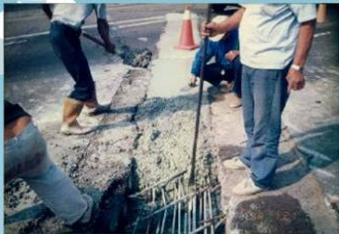
87年南下外側橋樑銜接修復
