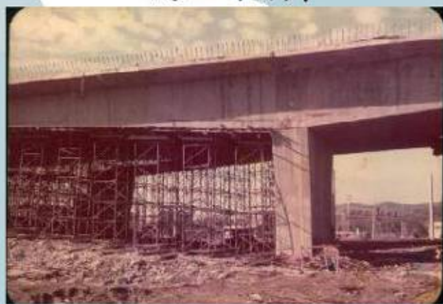
王田交流道跨越 台1線及海線鐵路
