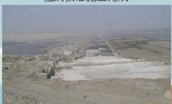
227K+800右側潛堰護坦緊急搶修工程完成情形
