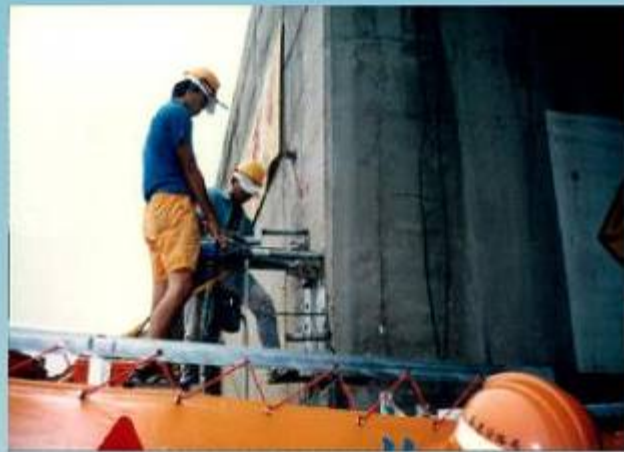
451標豐原台中段拓寬工程，85年9月23日在國道一號176K光明路橋側植筋
