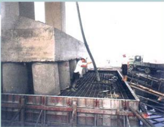
樁帽混凝土澆置情形
