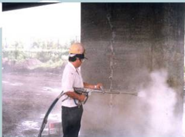
混凝土表面以水刀打毛
