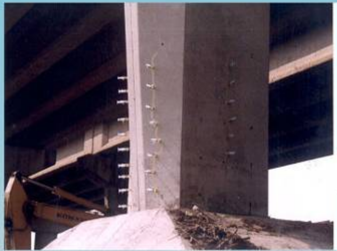
柱裂縫以注射器注射環氧樹脂
