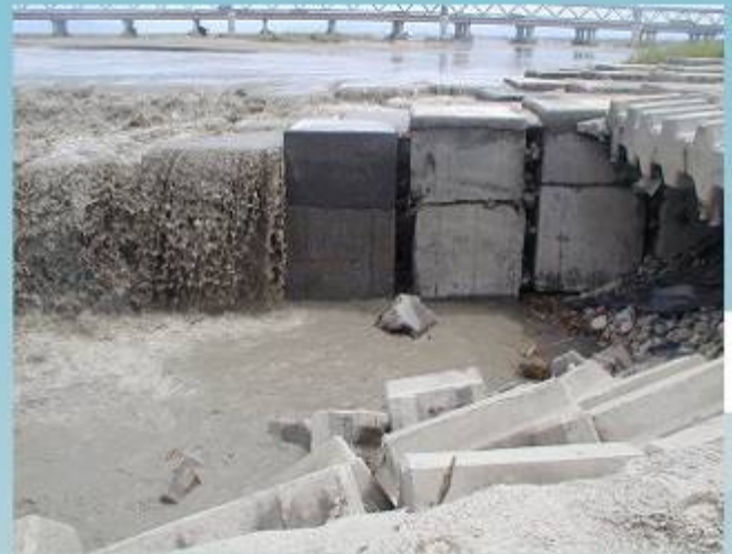
納莉颱風造成潛堰下游蜂巢塊沖毀情形
