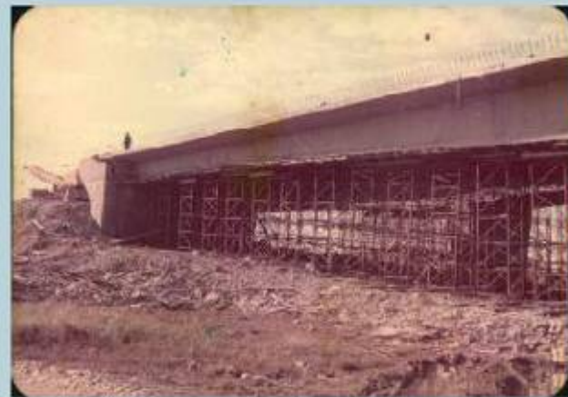
王田交流道施工
