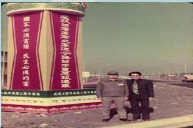
66年12月31日高速公路豐原交流道 入口與施工部隊517營營長合攝
