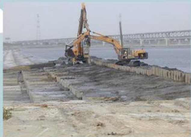
227K+800右側潛堰緊急截水工程施工情形
