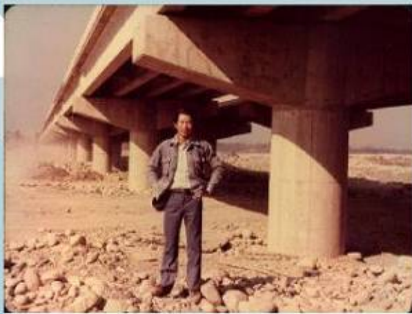
67年2月21日攝於施工中的 大甲溪橋下
