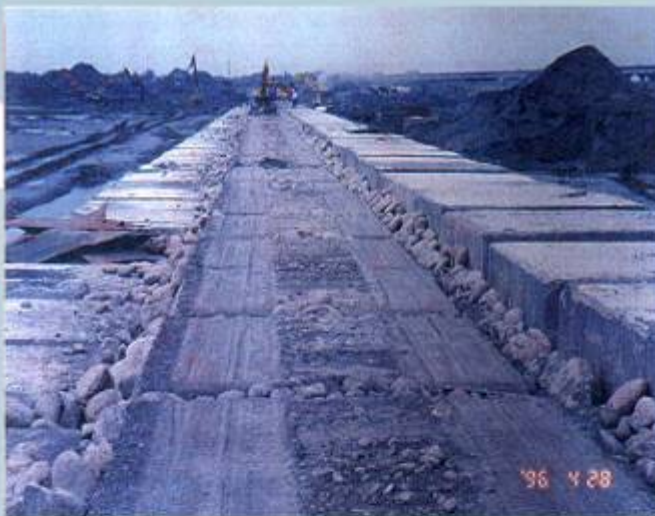
固床工場鑄混凝土塊隙縫回填卵石
