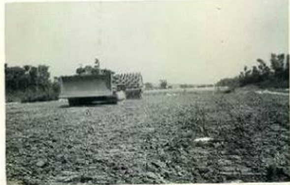
65年60A標羊腳滾 (後見四輪者為膠輪壓路機)
