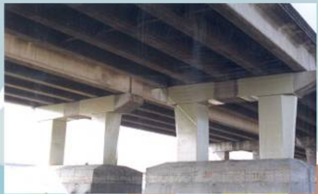
梁柱鋼板補強完成面
