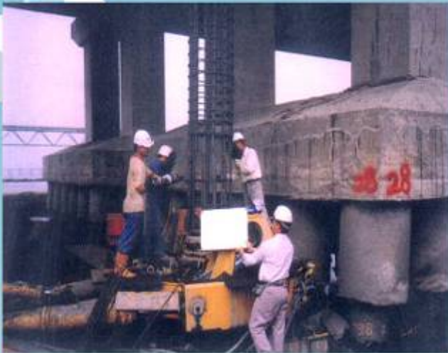
87年中沙大橋耐震維修補強（第一期工程）混凝土基樁吊放鋼筋籠
