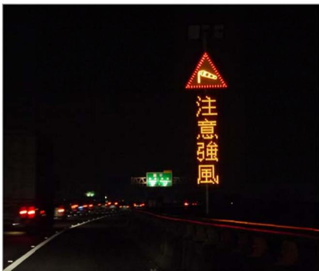
風力偵測器全時監測當風速達6級強風立即無線啟動LED注意強風警示標誌,提醒用路人行經強風路段注意側風對行車安全的影響及降低行車速度。
