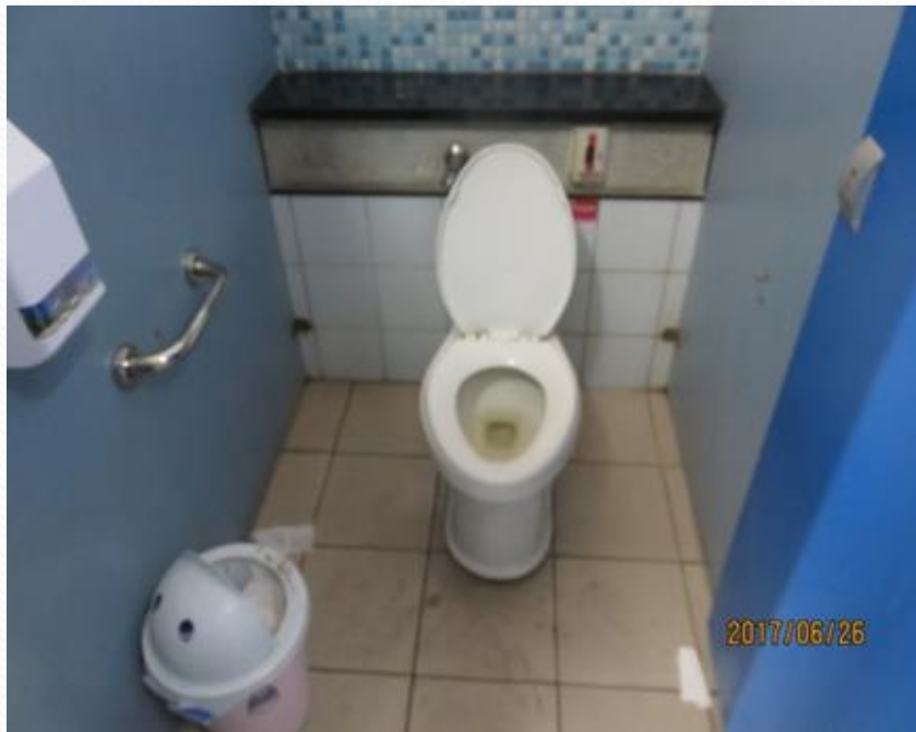
安全扶手-座式廁間
