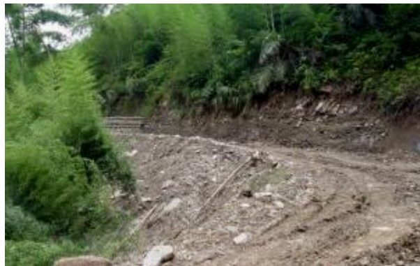
施工便道闢設過大
