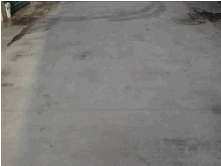
施作良好無裂縫情形
