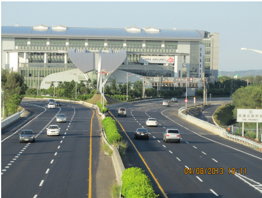
10207-H22-完工照片(國2往機場方向俯視近照)
