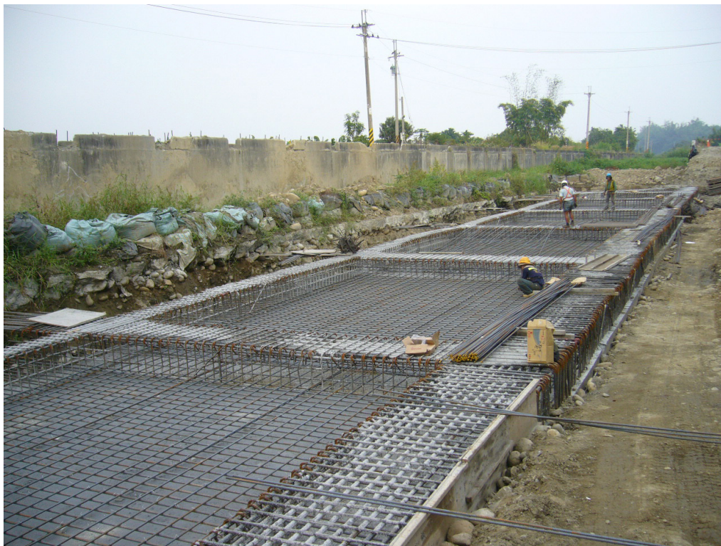
第D34標工程枋寮導水路R3箱涵第一階段底板施工情形
