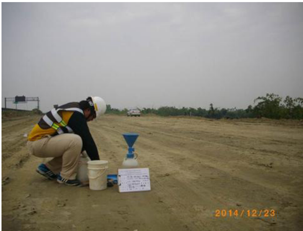
第D14標工程R1匝道路堤滾壓
