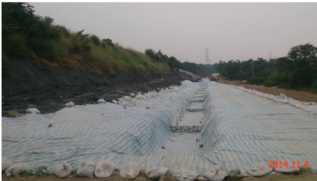
第D14標工程南工區臨時水土保持設施
