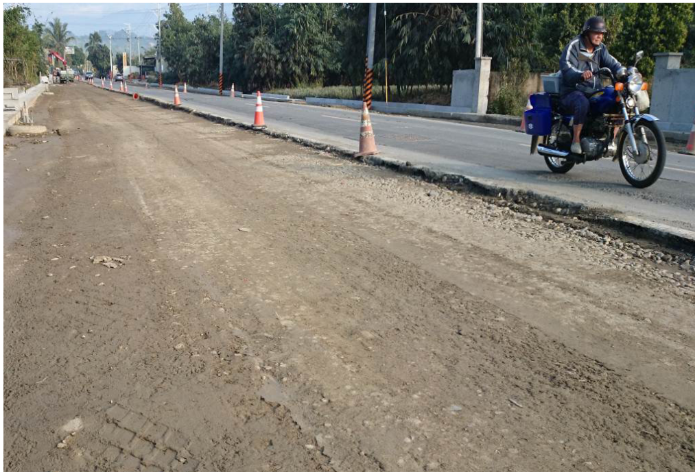
第D14標工程158甲級配鋪築
