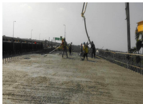
第D14標工程斗六大圳四之二號橋 第四跨底腹版施作
