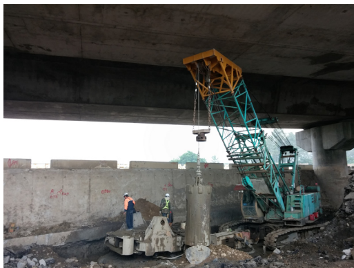
第D34標工程國道主線橋下低淨空 全套管基樁鑽掘施工
