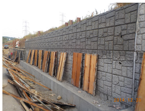
第D34標工程R3匝道擋土牆拆模 施工情形
