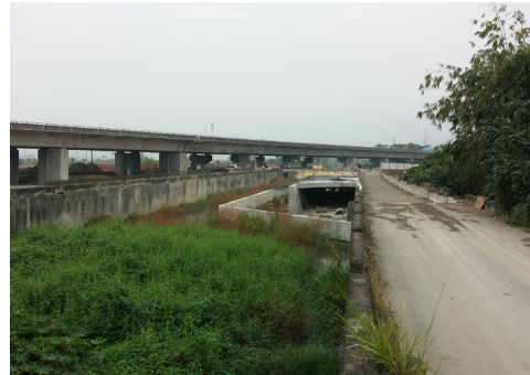
第D34標工程枋寮導水路L3箱涵施工中改水路情形
