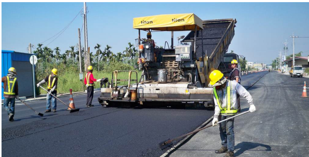
第D14標工程149甲線AC鋪築
