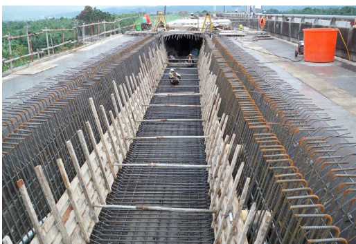
第D14標工程斗六大圳四之二號橋 第四跨頂版RC澆置
