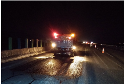
第D34標工程國道主線夜間交維路面刨鋪
