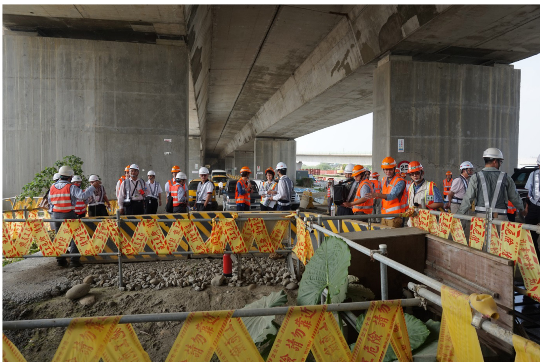
104年度增設南雲交流道工程環境影響評估追蹤考核現場勘察
