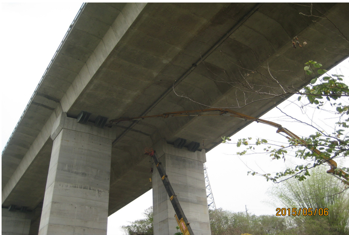
田寮2號高架橋P25鋼板止震裝置施作
