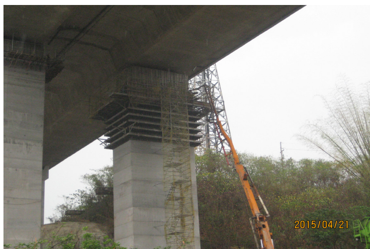
田寮2號高架橋P25L墩柱包覆混凝土澆置
