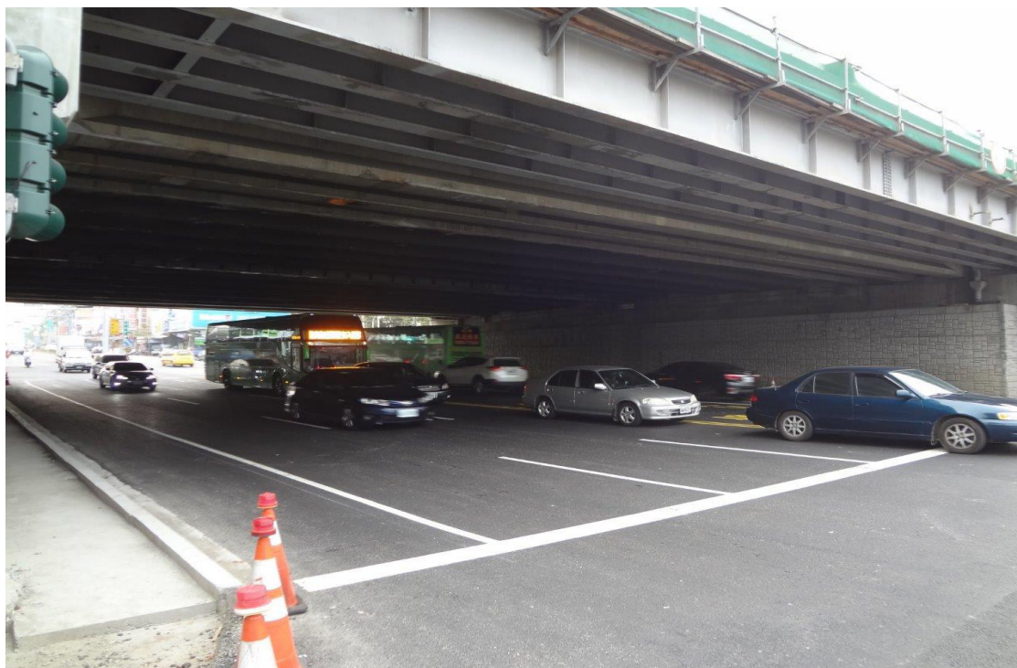
縣道180穿越橋拓寬完成
