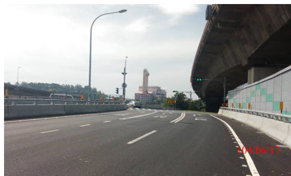
新增匝道銜接鼎力路口端
