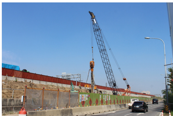
匝道L1 PC板樁施工
