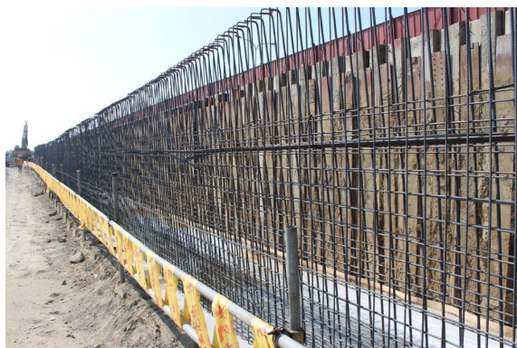
匝道L1 擋土牆施工
