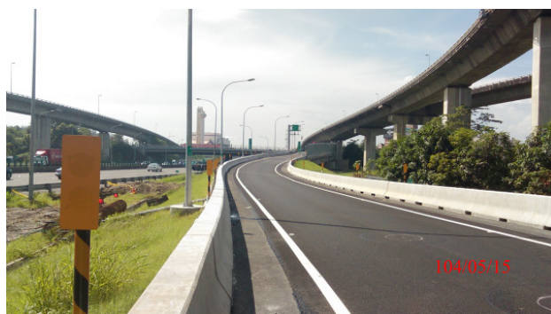
新增匝道路堤段
