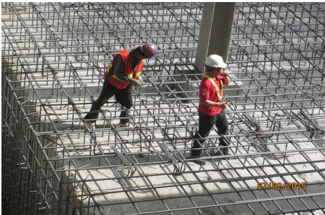
田寮2號高架橋P8R基礎鋼筋綁紮
