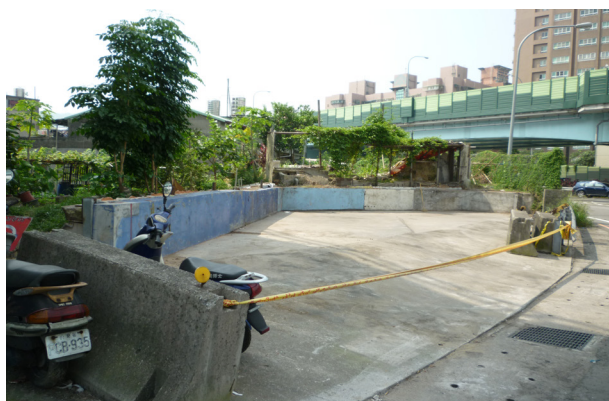
永和段412-1地號土地侵佔建物拆竣照片
