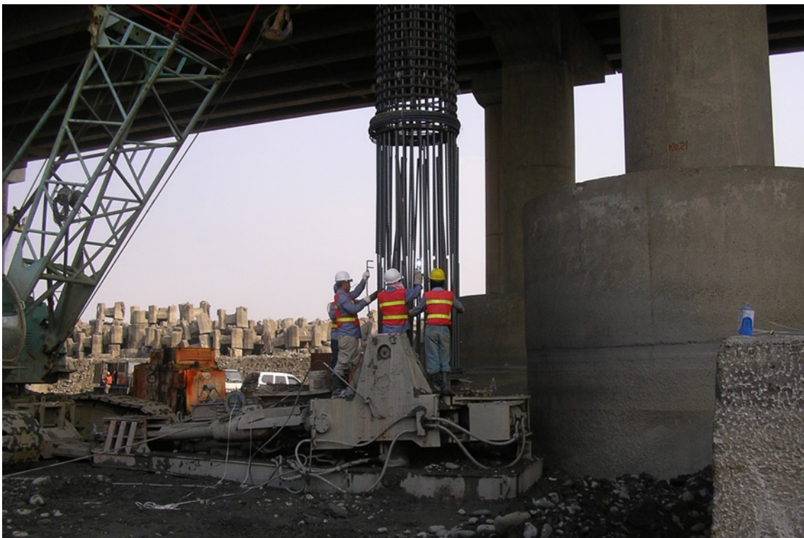
烏溪橋全套管基樁施作情形（三）第M15C標
