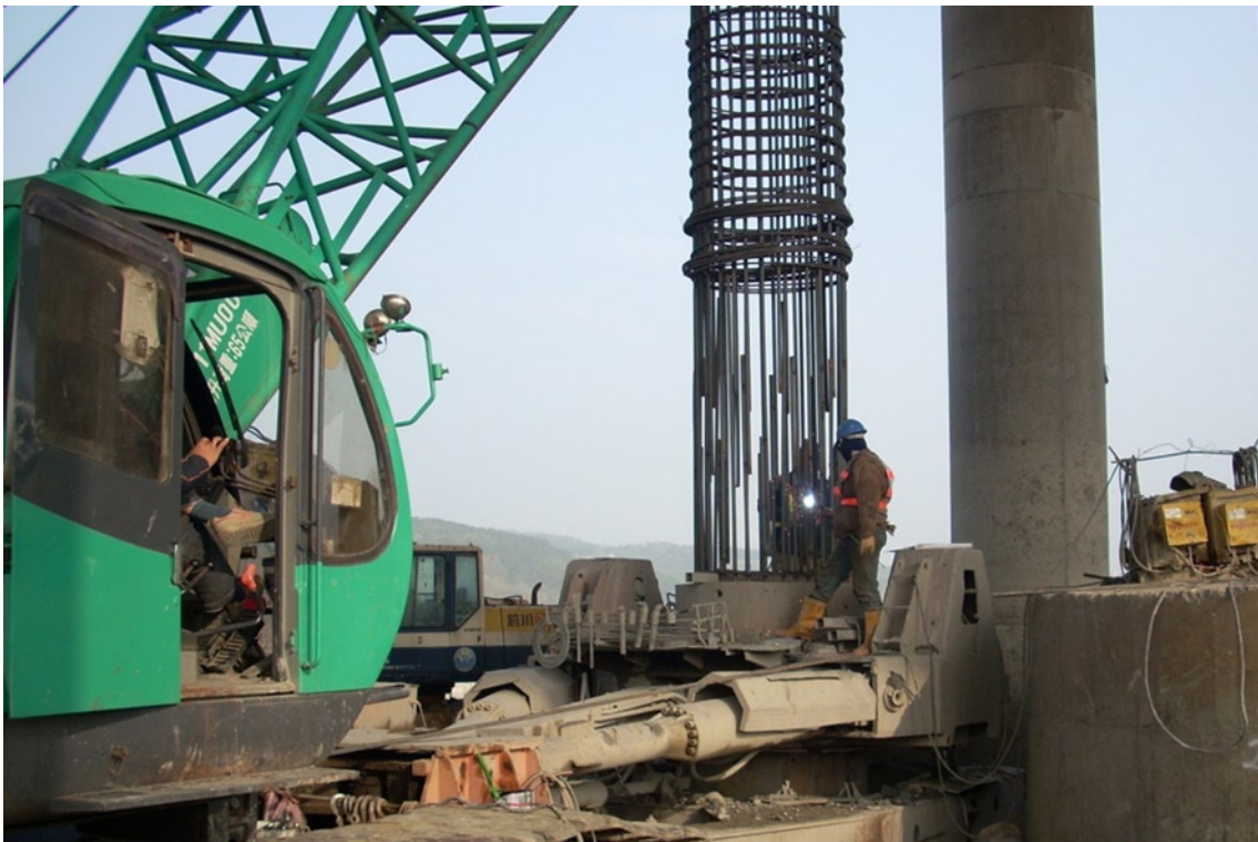
後龍溪P10全套管基樁施作
