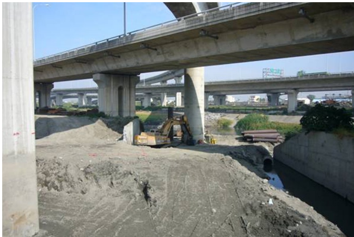
埔鹽系統交流道整地施工
