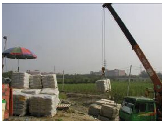
7.超細水泥進場
