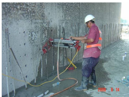
7.預力鋼棒孔位洗孔
