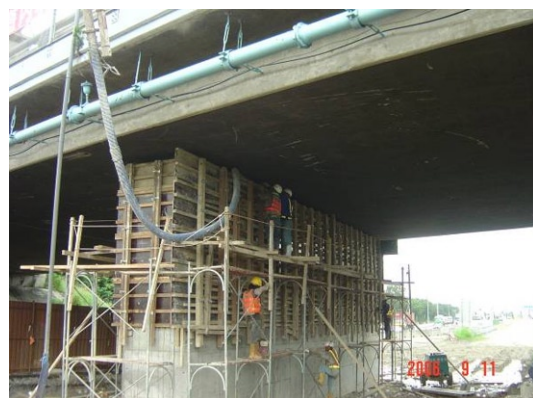
6.第二升層澆置
