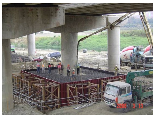
16. 自充填混凝土澆置
