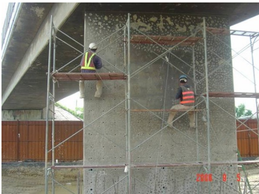
1.墩柱表面打毛
