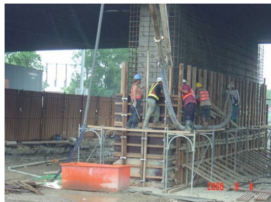
4.第一升層澆置
