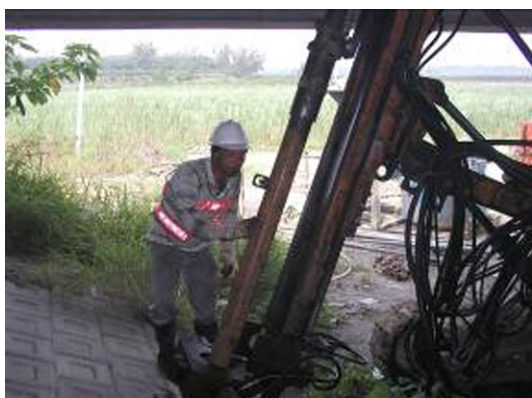
1.灌漿孔角度量測
