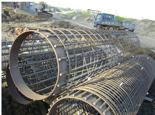
1.限高基樁施作
