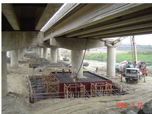
17. 自充填混凝土澆置
