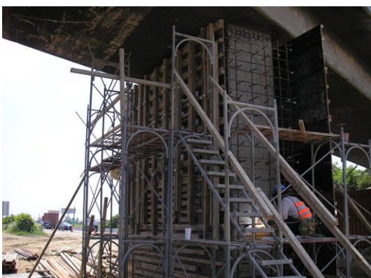
5.第二升層模板組立
