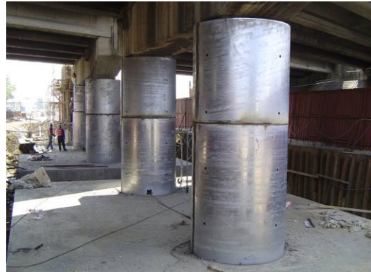
2. 鋼板包覆完成
