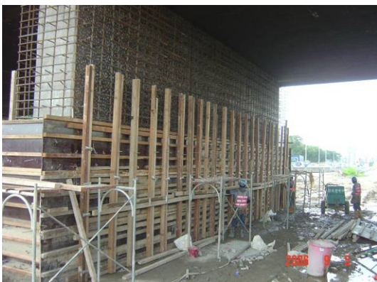
3.第一升層模板組立
