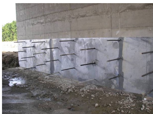
9.預力鋼棒安裝完成
