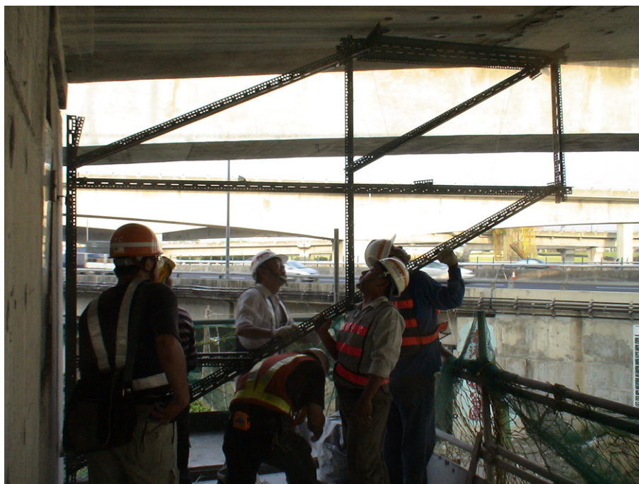
圖九.臨時樣架放樣上拖座孔位
