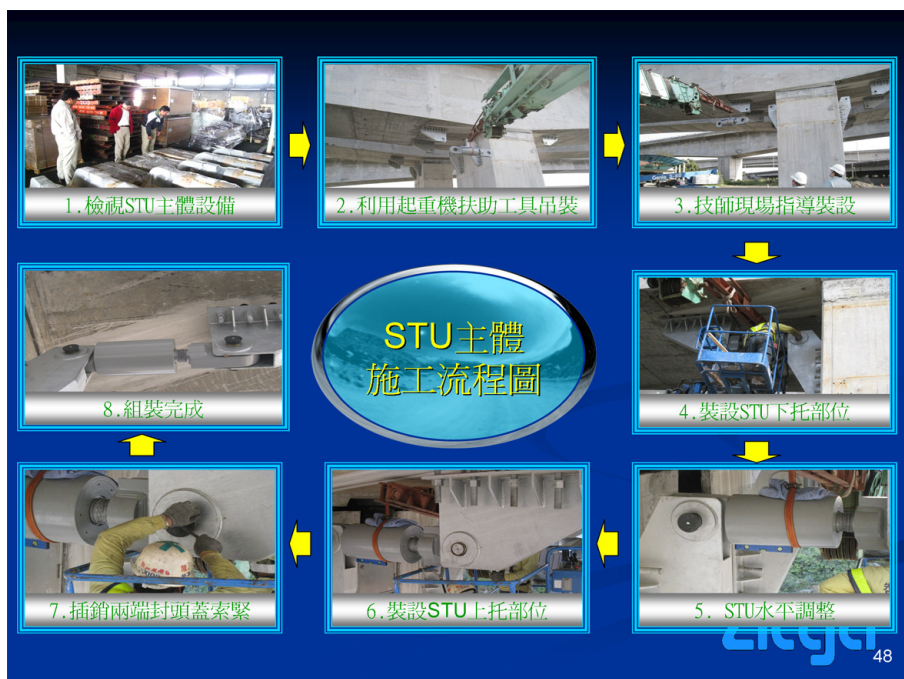
圖十四.STU本體組裝流程
