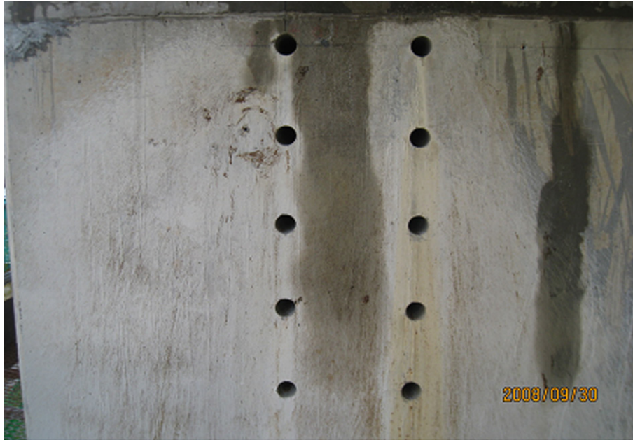
圖七.鑽孔完成情形
