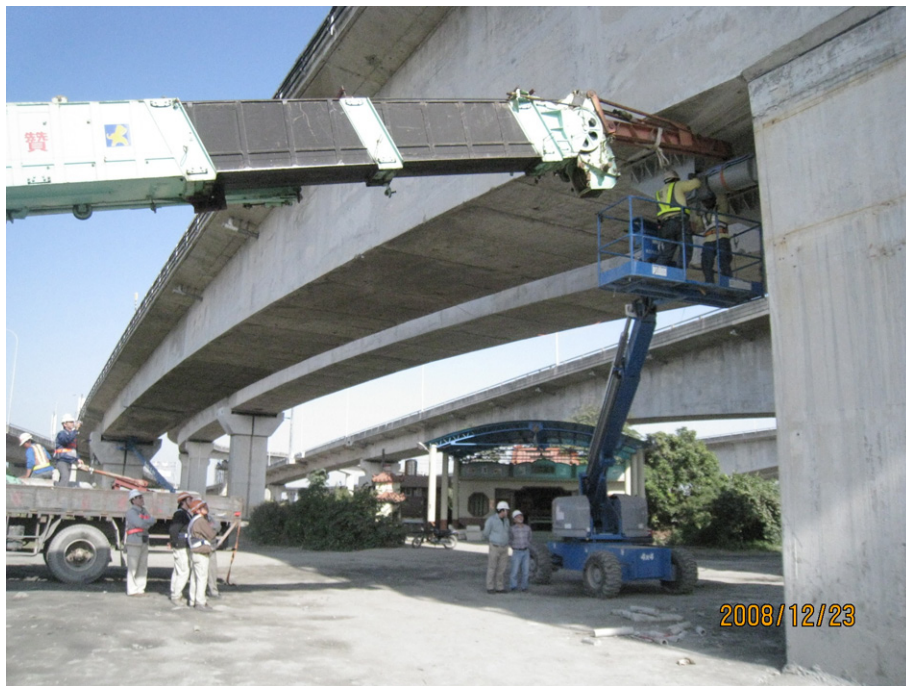
圖十二.STU本體安裝情形
