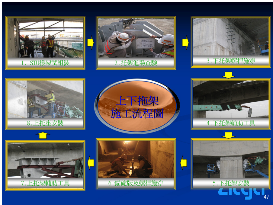
圖十二上下拖座安裝流程
