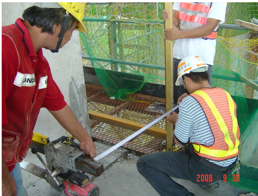
圖五.鑽機定位
