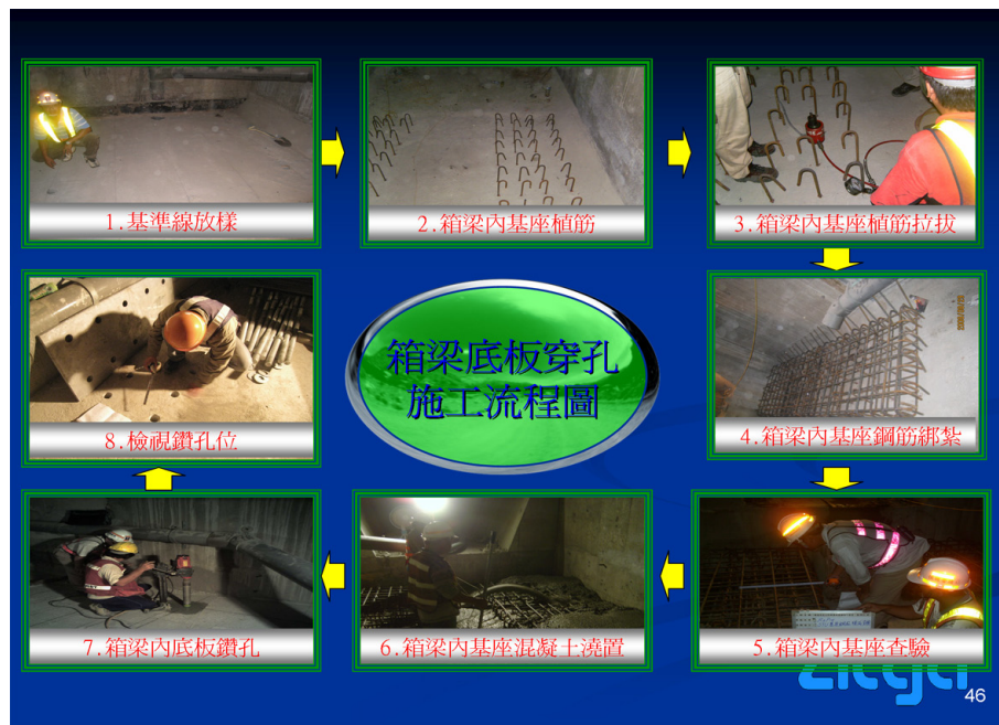
圖十.箱梁底板加厚工程及鑽孔流程
