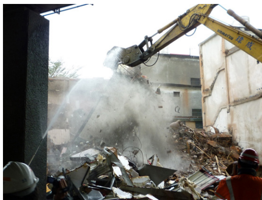
(圖4-1) 建築物拆除實景
