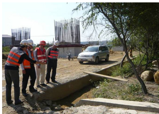
副處長指導工地
