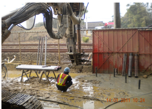
微型樁施作照片1
