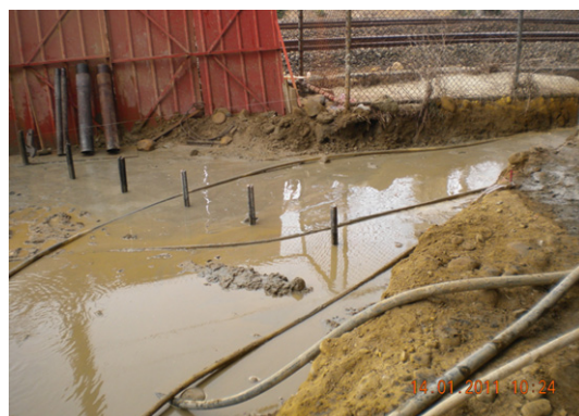
微型樁施作照片2
