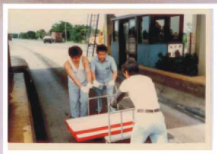
票亭加高施工
