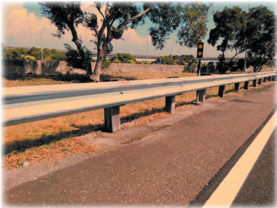
護欄柱修復（塑膠模）
